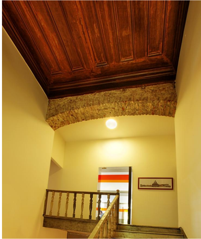
Şekil 5.37. Tavanda yer alan tuğla kemer ve ahşap tavan detayı.(Zeynep İnan Arşivi)
