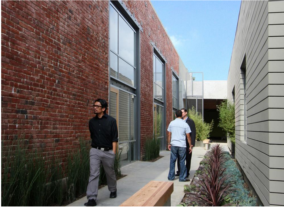
(Şekil 6.15.) Binanın yan cephesi(www.arhitectural.com)
