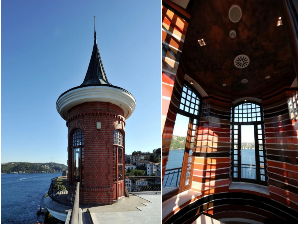
Şekil 5.20 Restorasyon sonrasında kule bölümünün yenilenmiş görünümü ( www.hurriyet.com.tr )
