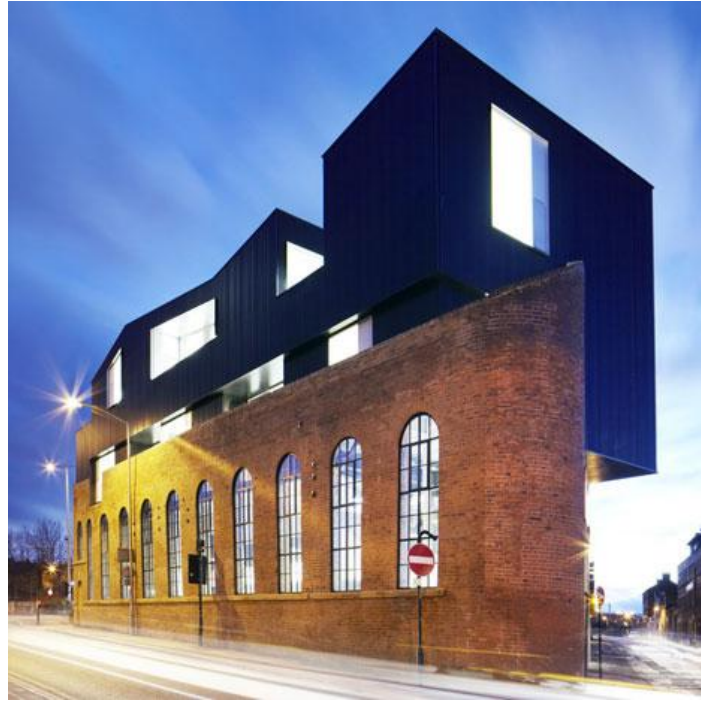
Şekil 6.9.Yenileme Sonrası son görünüşü(www.mimdap.org)
