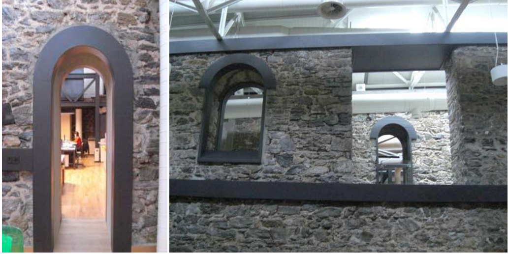
Şekil 5.14 Tuz Ambarı: Açıklıklarda kullanılan çelik bantlar.(Banu Pekol Doktora Tezi Arşivi)
