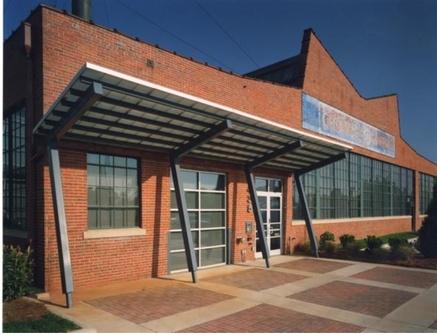
Şekil 6.44. Yapıya ait dış cephe görüntüsü.(www.arhitectural.com)
