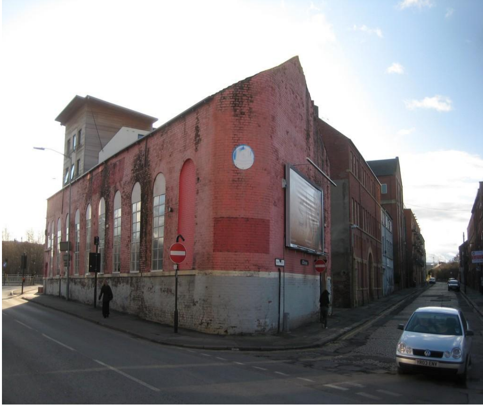
Őekil 6.1. Binanın müdahale öncesi görünümü (www.mimdap.org)
