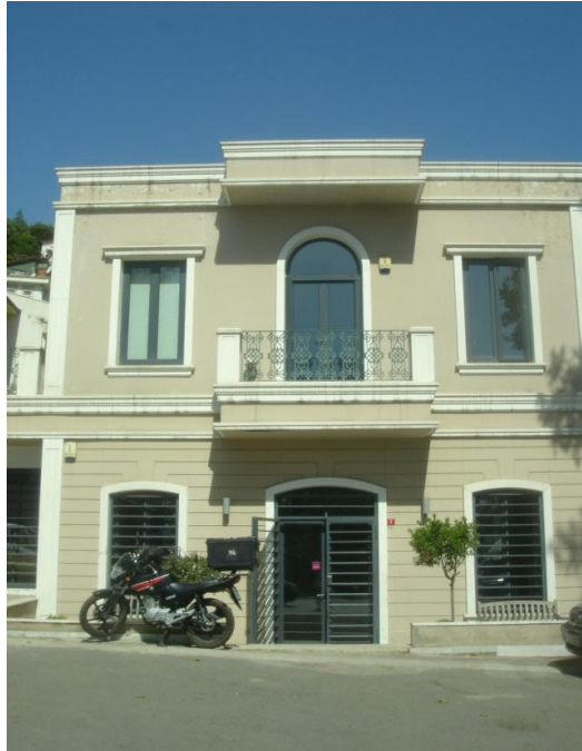
Şekil 5.51. Binanın cephe görünüşü (Zeynep İnan Arşivi)
