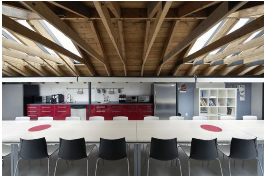
Şekil 6.31. Çatı güçlendirmesi sonrası çatıdan detay görünümü.(www.mimdap.org)
