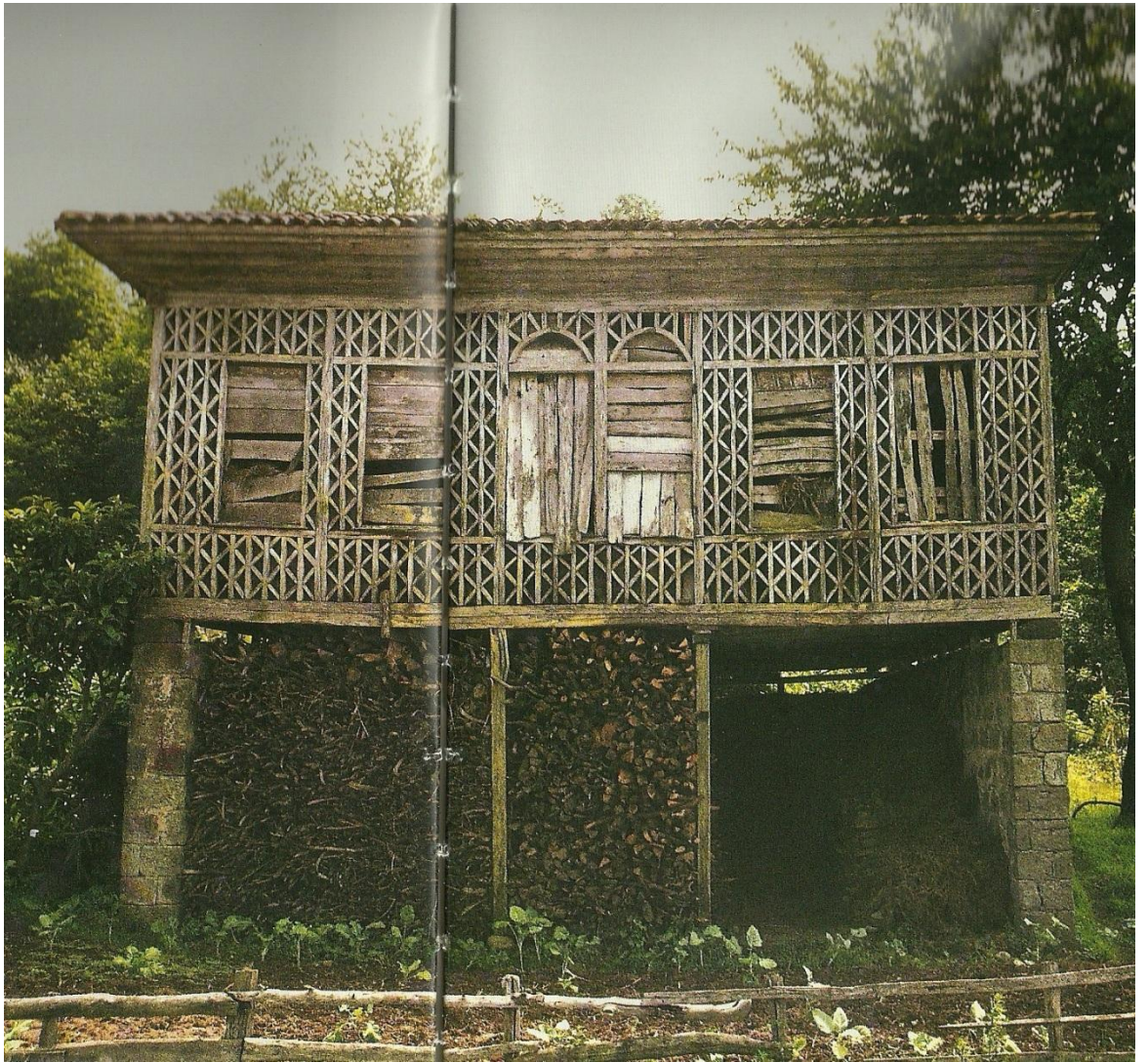
Resim 6.13. Muska tekniğinde yapılmış ahşap iskelet sistem, Trabzon. 113
