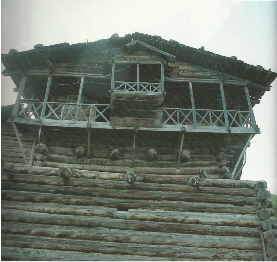
Resim 6.9. Ahşap yığma sistem, Artvin. 104
