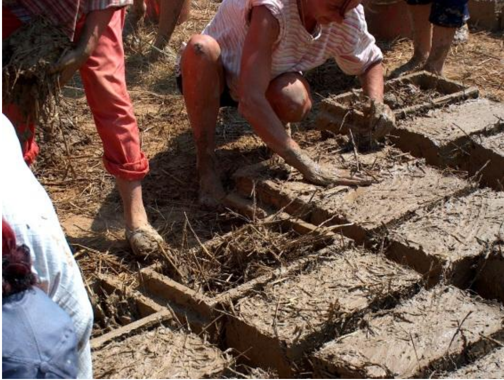
Resim 5.6. Kerpicin kalıplanması. 73
