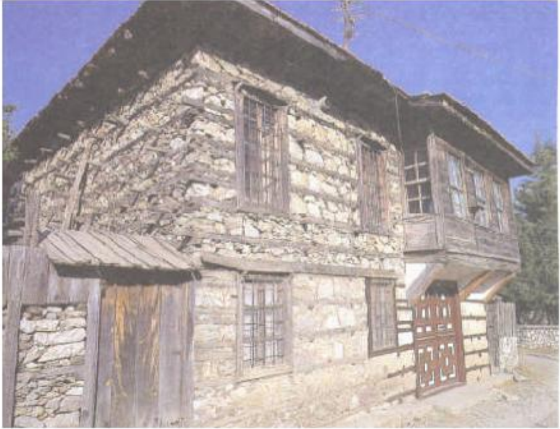
Resim 6.1. Ahşap hatıllı moloz taş duvar. 93
