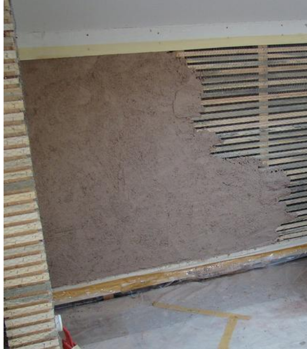
Resim 5.13. Horasan sıva uygulaması.
