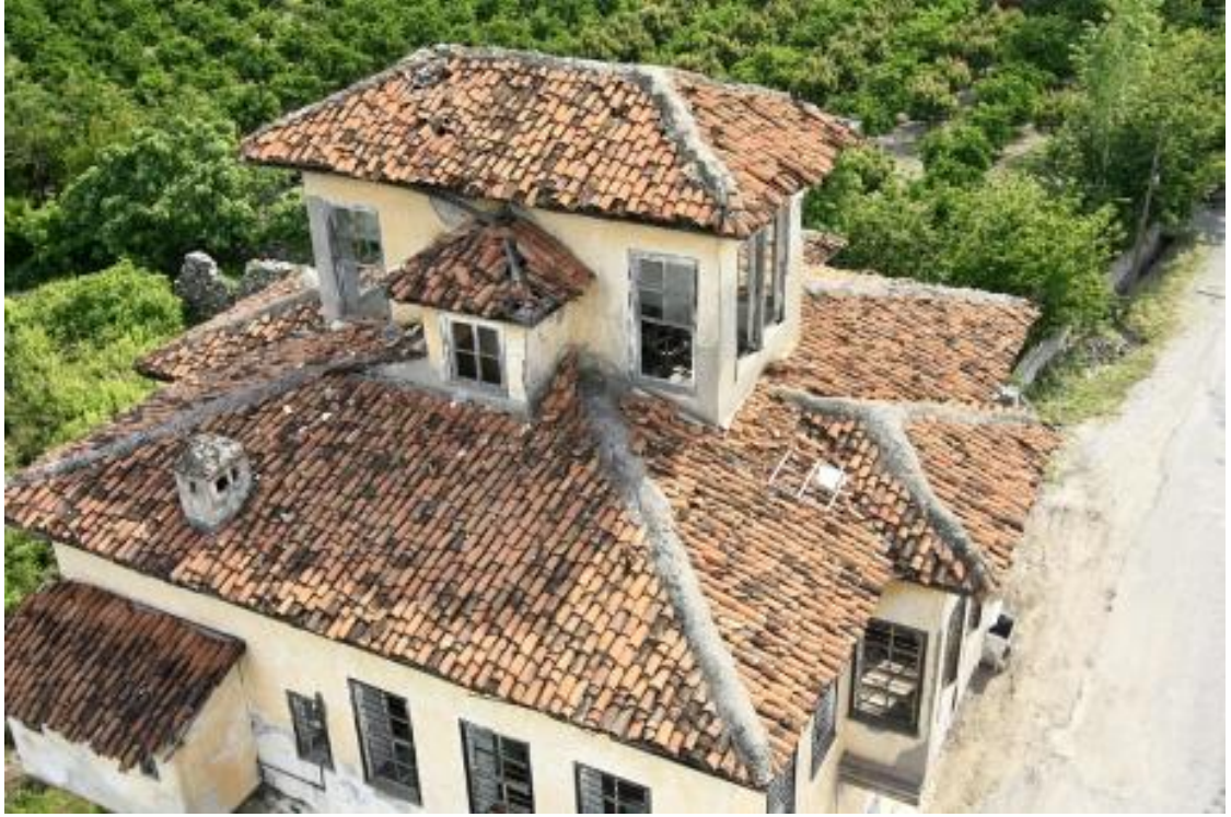
Resim 5.10. Alaturka kiremit çatı örtüsü, Hatay. 78
