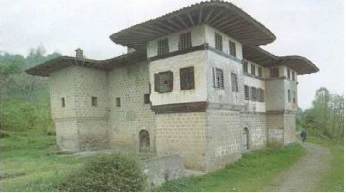
Resim 6.2. Kesme taş ile yapılmış bir yapı örneği, Trabzon. 96
