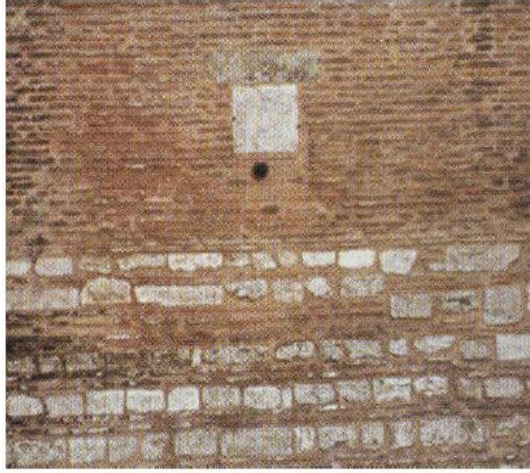
Resim 6.7. Yığma tuğla duvar.
