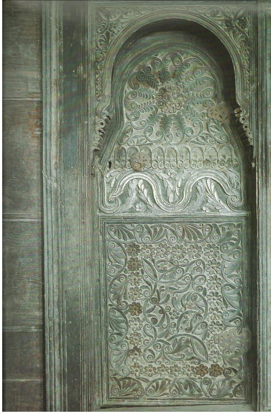
Resim 6.31 Metal kaplama kapı, Trabzon. 136
