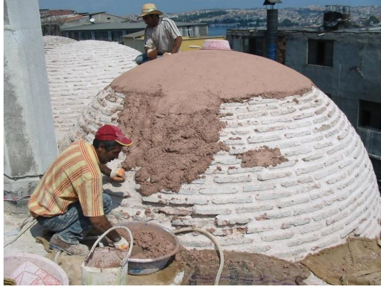
Resim 5.12. Horasan harcı ile yüzey kaplanması.
