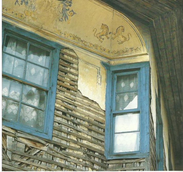
Resim 6.14. Toprak malzeme ile duvar kaplaması. 114
