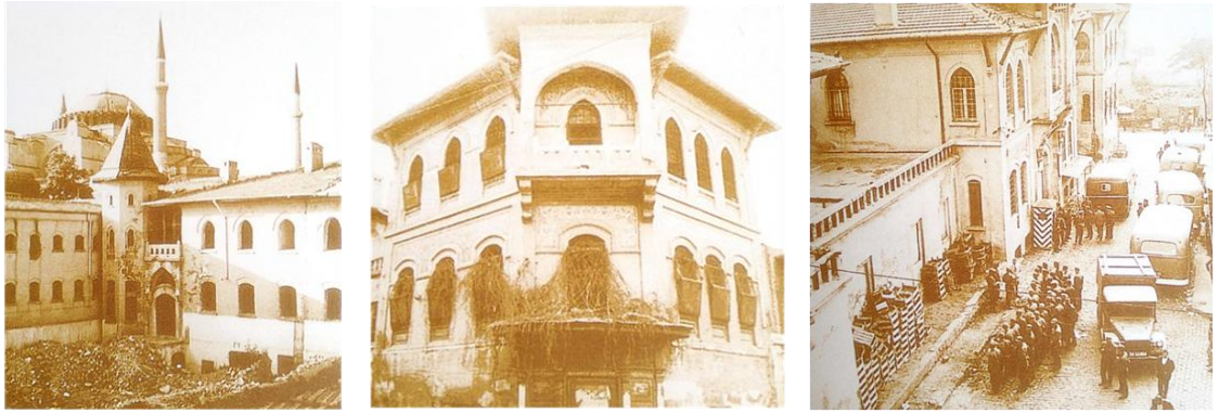
Şekil 5.90. Sultanahmet Cezaevi fotoğrafları (Four Seasons Otel Broşür, 2013)
