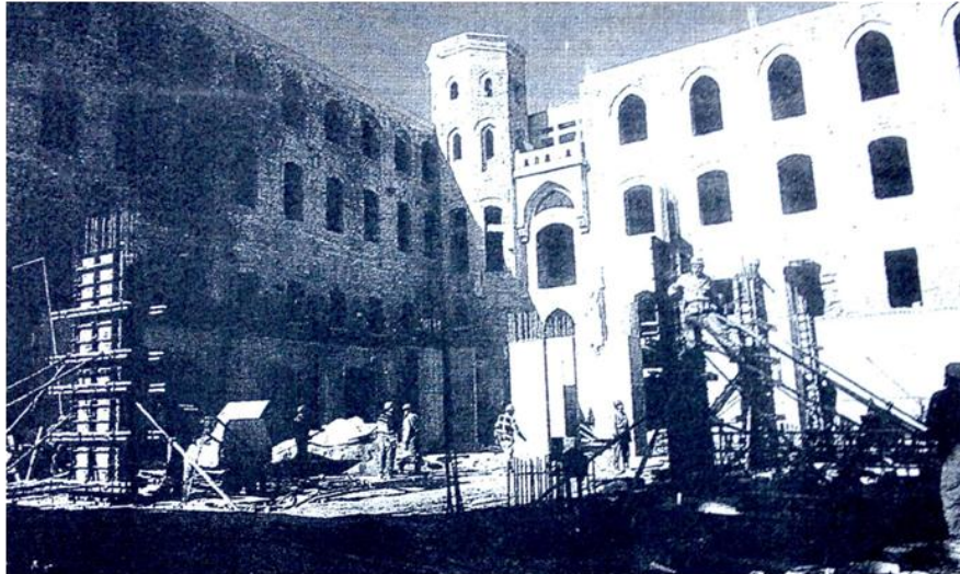
Şekil 5.105. Sultanahmet Cezaevi restorasyon öncesi avlunun fotoğrafı (www.wowturkey.com, 2008)
