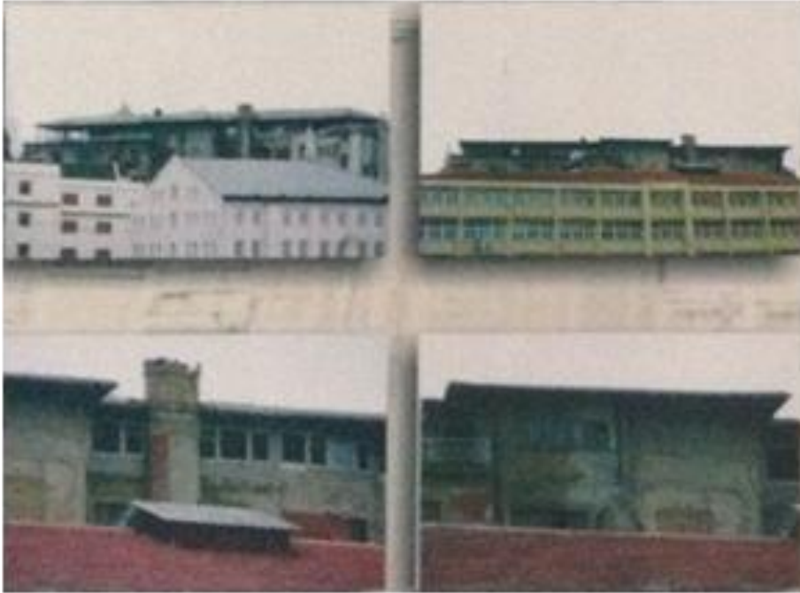
Şekil 5.10. Restorasyon öncesi deniz cephesi ve giriş (Legacy Ottoman Otel Broşür, 2013)
