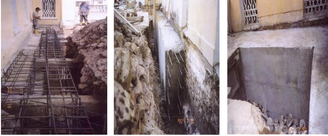
Şekil.30: Kuşak Perdesi İçine Bırakılan Betonarme Kirişler ve Temel Takviyesi
