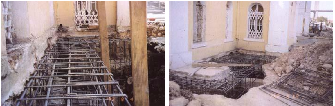
Şekil.29: Temel Donatılarının Yerleştirilmesi
