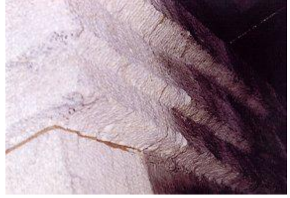
temizlenmiş ve kirli yüzeyler farkı
