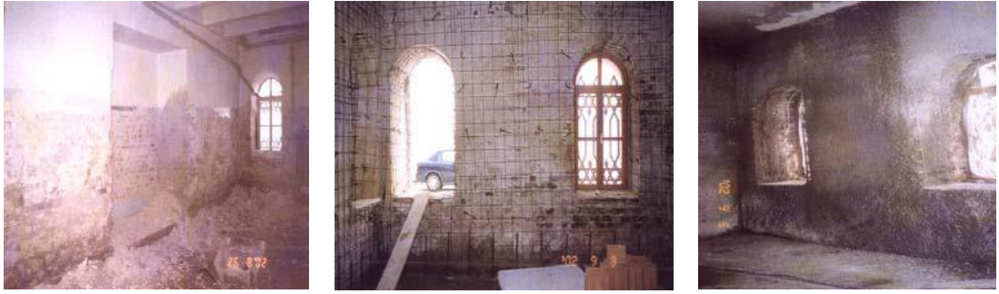
Şekil.32: Shotcrete Öncesi Duvar Sıvalarının Kaldırılması, Duvarlara Çelik Hasır ve Ankrajların Yerleştirilmesi ve Püskürtme Betonunun Tamamlanması
