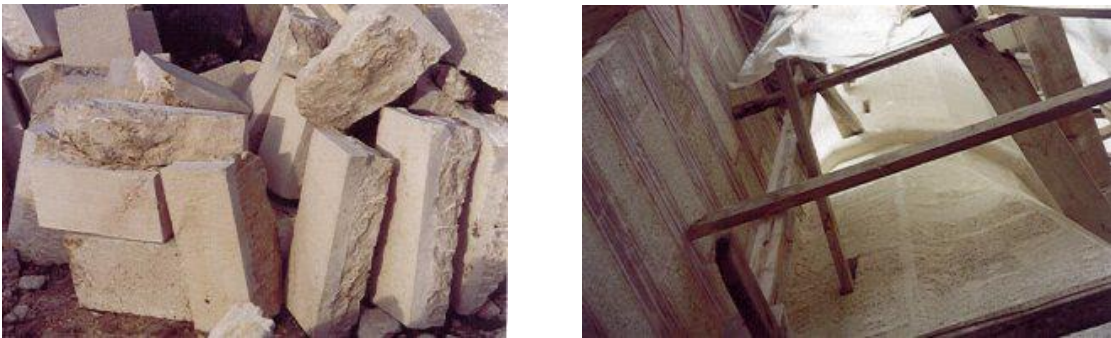
Şekil.4: İşlenmiş Taşların İstiflenmesi ve Montajı
