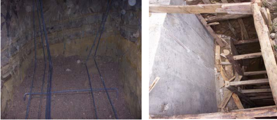
Şekil.16: Ampatmanın Teşkili ve Kalıbın Sökülmesi
