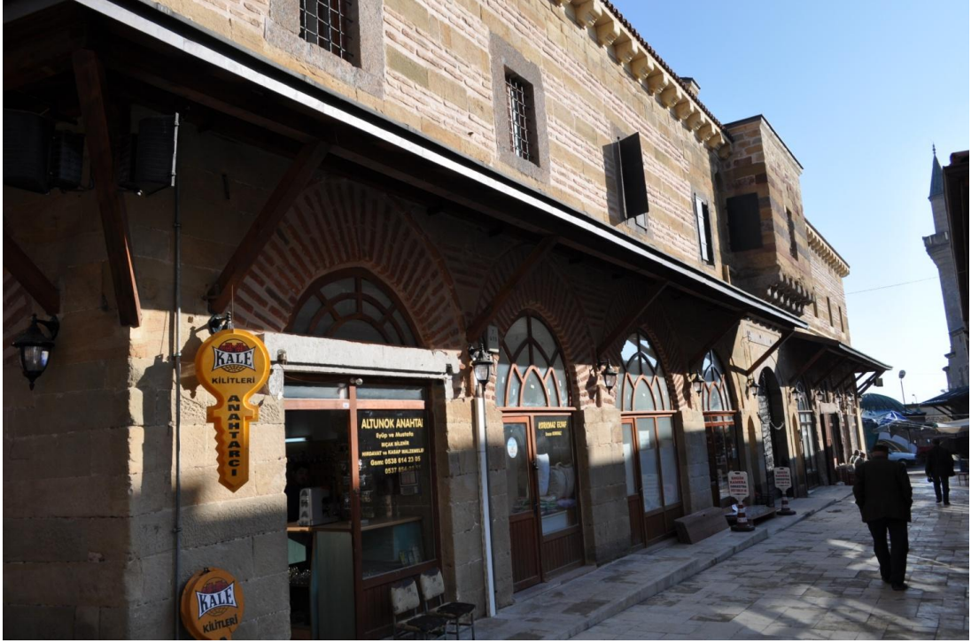
Resim 20 Giriş Cephesi Dış Dükkanlar
