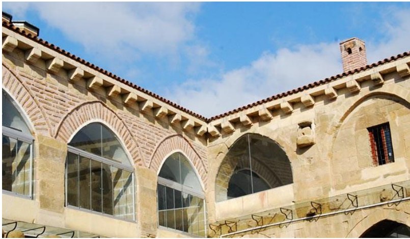
Resim 19 İç mekan Kemerler
