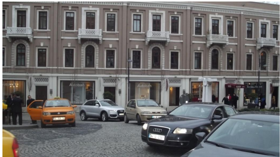
Kaynak: Zuhul Bayrakçeken Arşivi'nden Şekil 3.34 : Akaretler Sıra Evler Yeniden İşlevlendirme Sonrası 2.Tip cephe Örneği
