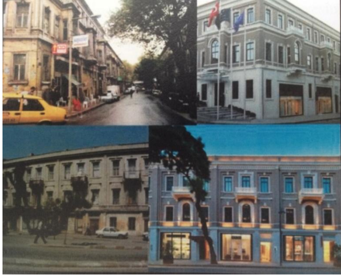
Kaynak: http://www.akaretler.com.tr Şekil 5.6 : Restorasyon Öncesi ve Sonrası Cephe Görünümleri
