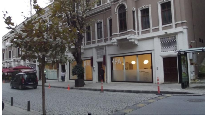
Kaynak: Zuhâl Bayrakçeken Arşivi'nden Şekil 5.165 : Rampa Sanat Ön Cephe Vitrin
