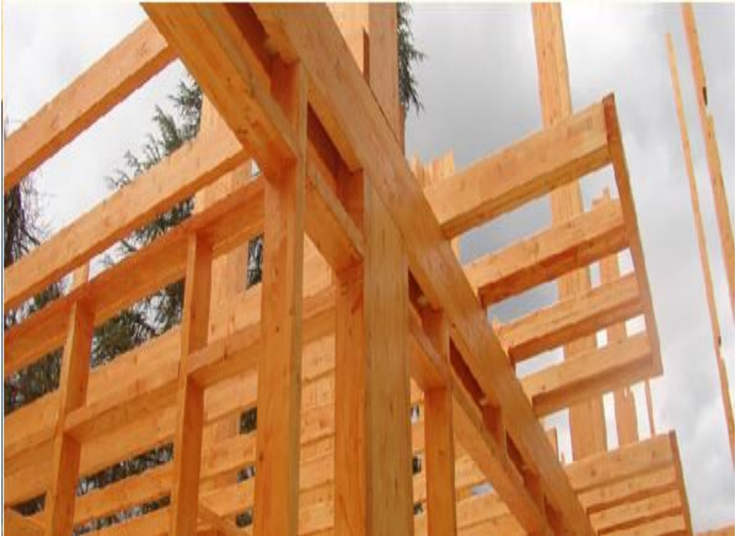
Şekil 5.41. Lamine Ahşap Konstrüksiyon Detay
