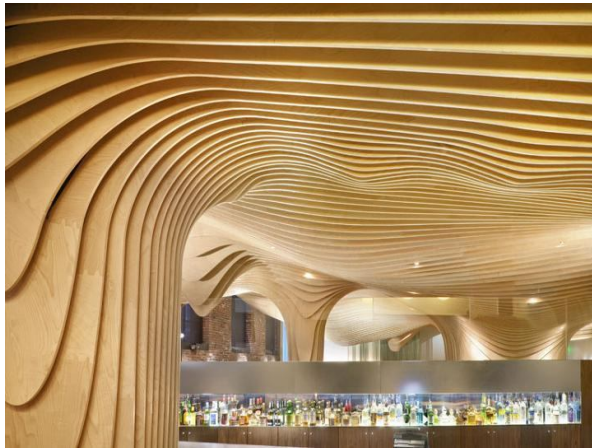
Şekil 5.9. Kavisli Ahşap Tavan Kaplaması
