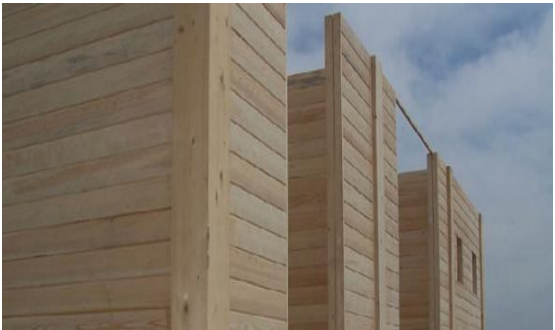
Şekil 5.47. Ahşap Duvarlar Isı Yalıtım Özelliğine Sahiptir
