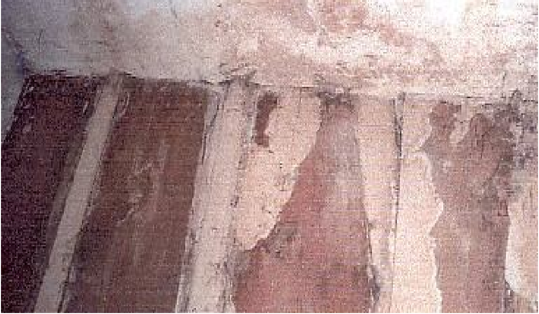
Şekil 4.2. Mantarlaşmış Ahşap
