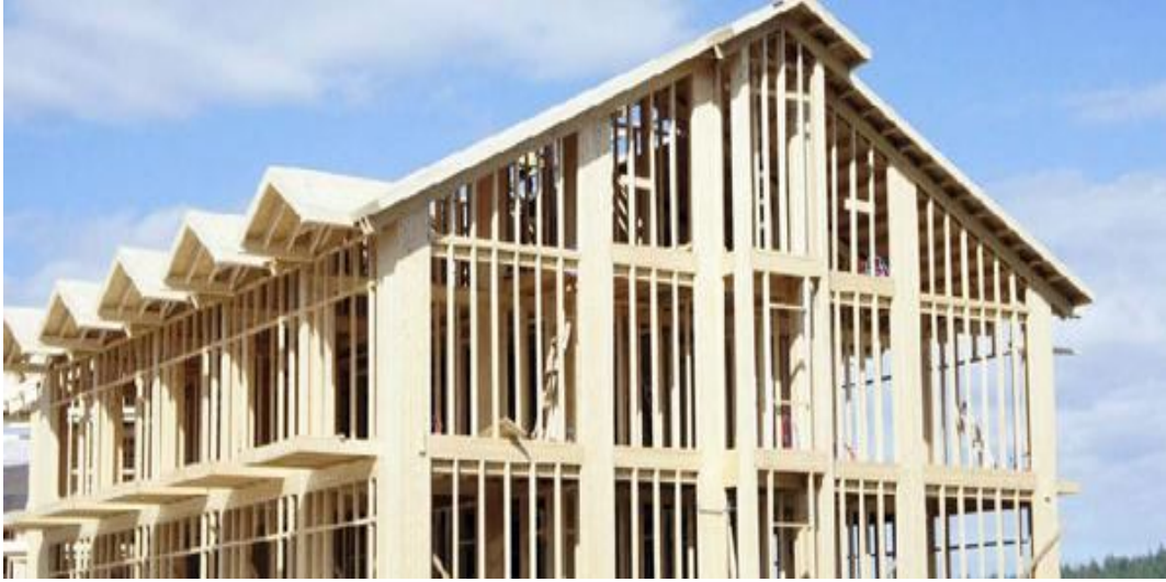
Şekil 5.42. Yapımı Devam Eden Ahşap Yapı
