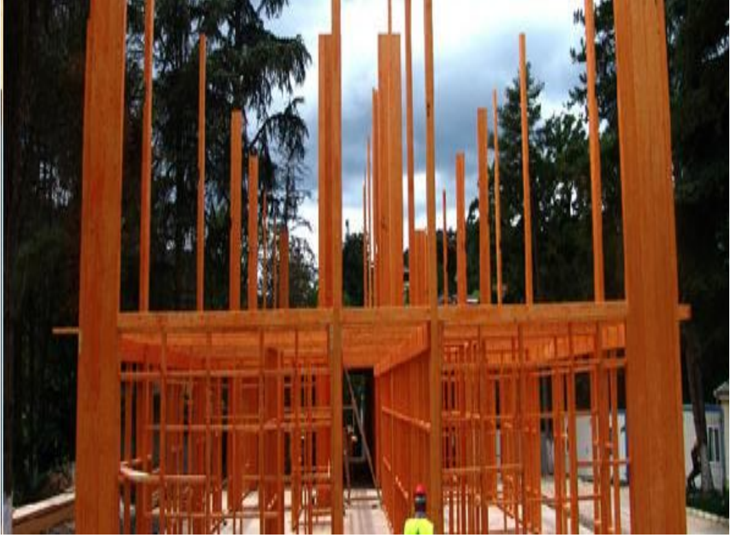
Şekil 5.40. Lamine Ahşap Konstrüksiyon
