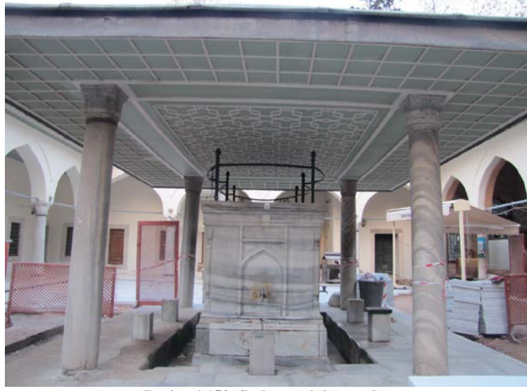
Resim 6.153. Su haznesi dar cephe
