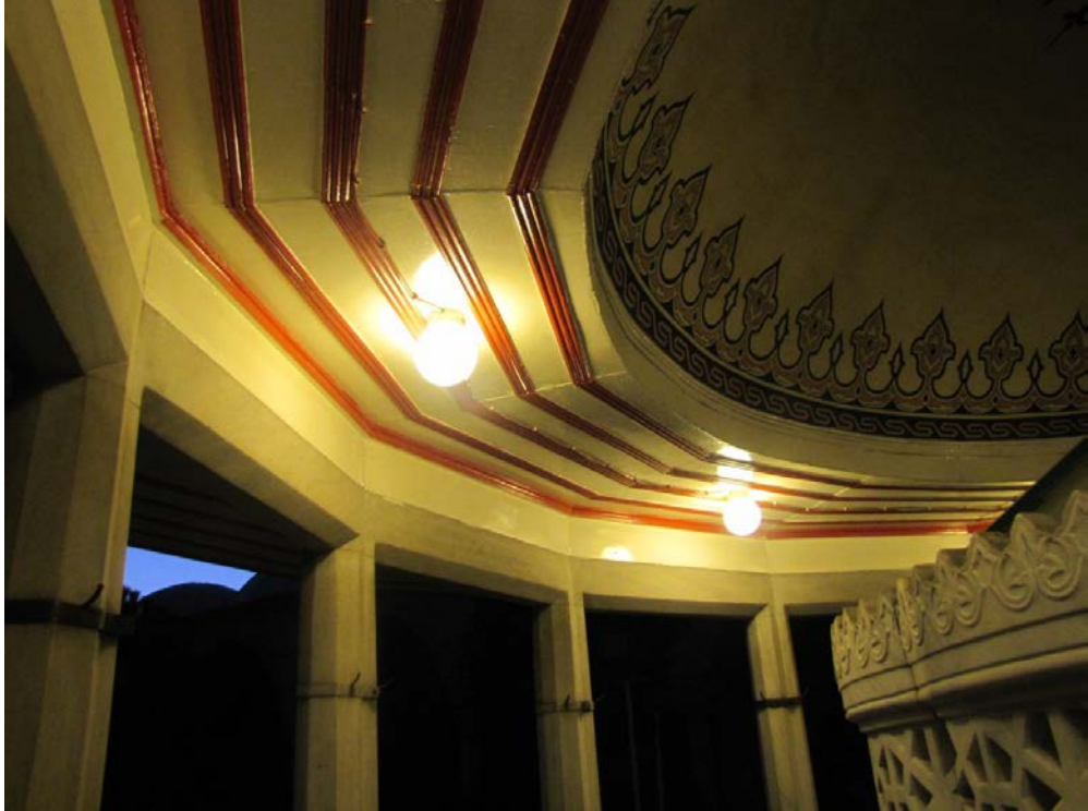
Resim 6.168. Revak ve kubbe içi kalem işleri
