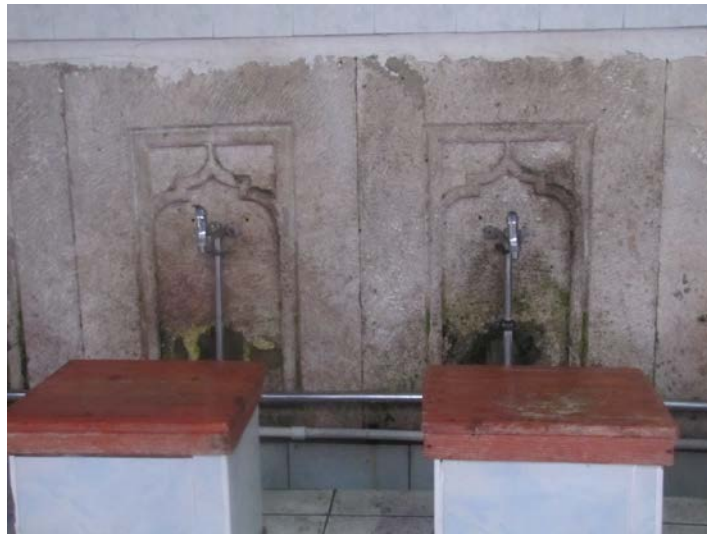
Resim 6.93. Musluk, ayna taşı, profiller ve oturak taşları
