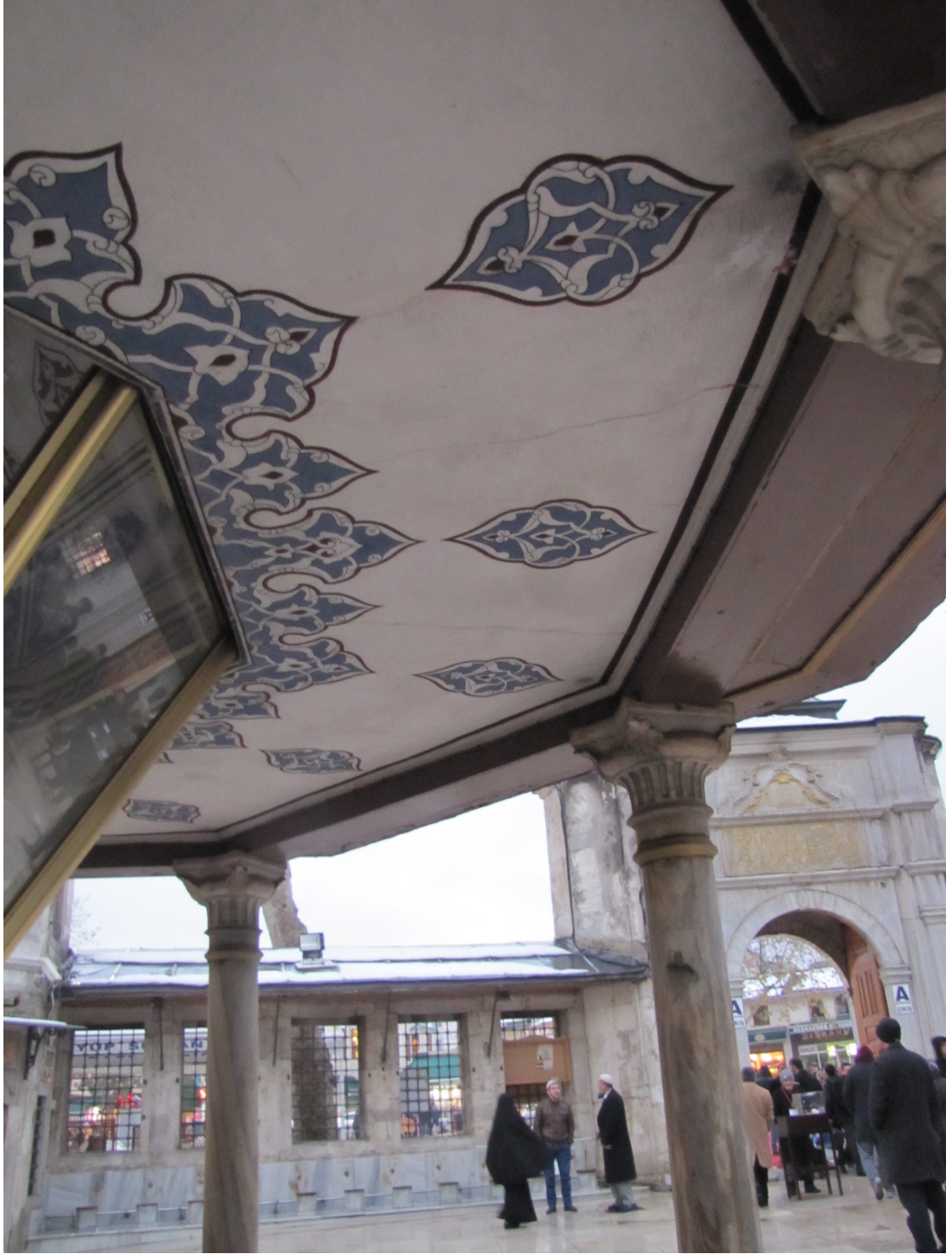
Resim 6.26. Revak ve kubbe içi kalem işleri
