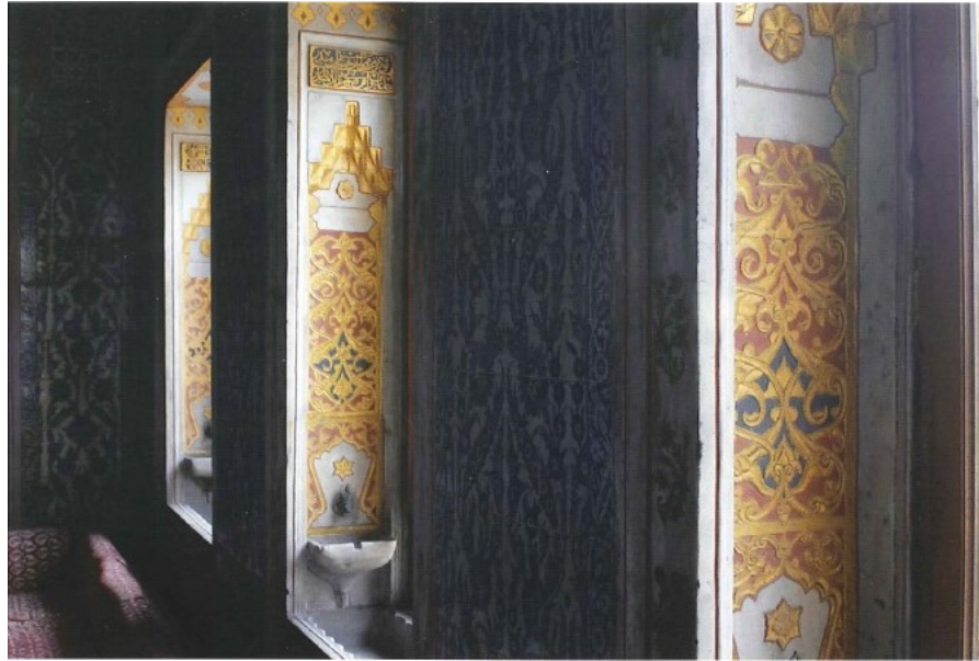
Resim 2.6. 17. yüzyılda sarayda moda haline gelen pencere içinde çeşmeler yapılması Çifte Kasırlar'da da görülür. Pencere içindeki şirin çeşmeler ve muslukların önlerindeki kurnalarla mekanda su sesinin oluşmasına çalışılmıştır, Topkapı Sarayı 27
