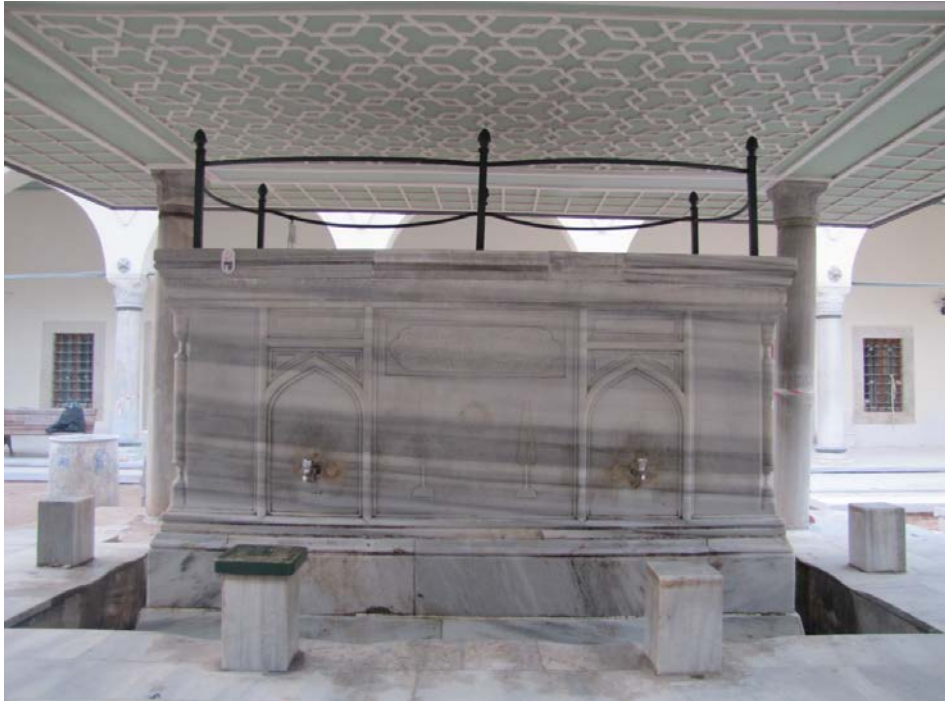
Resim 6.152. Su haznesi geniş cephe
