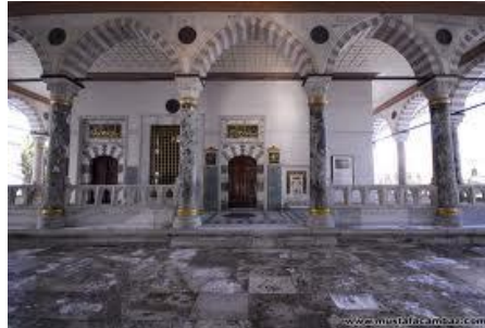
Şekil 5.2. Arz Odası giriş cephesine bakış.
