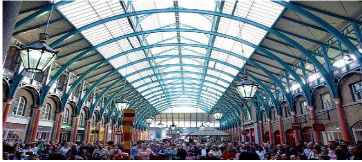
Şekil 2.8: Londra Covent Garden Çarşısı İç Görünüşü .(2.15)
