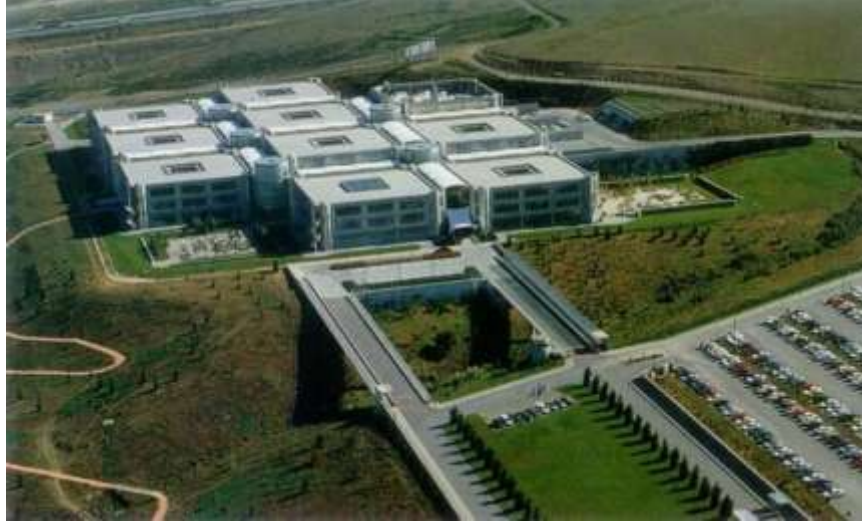
Resim 5.4.Yapı Kredi Bankası Operasyon Merkezi Binası
