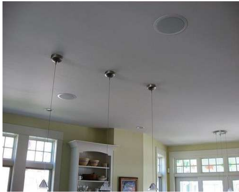
Resim 3.37. Tavana ankastre montajı yapılan speaker. ( hoparlör )
