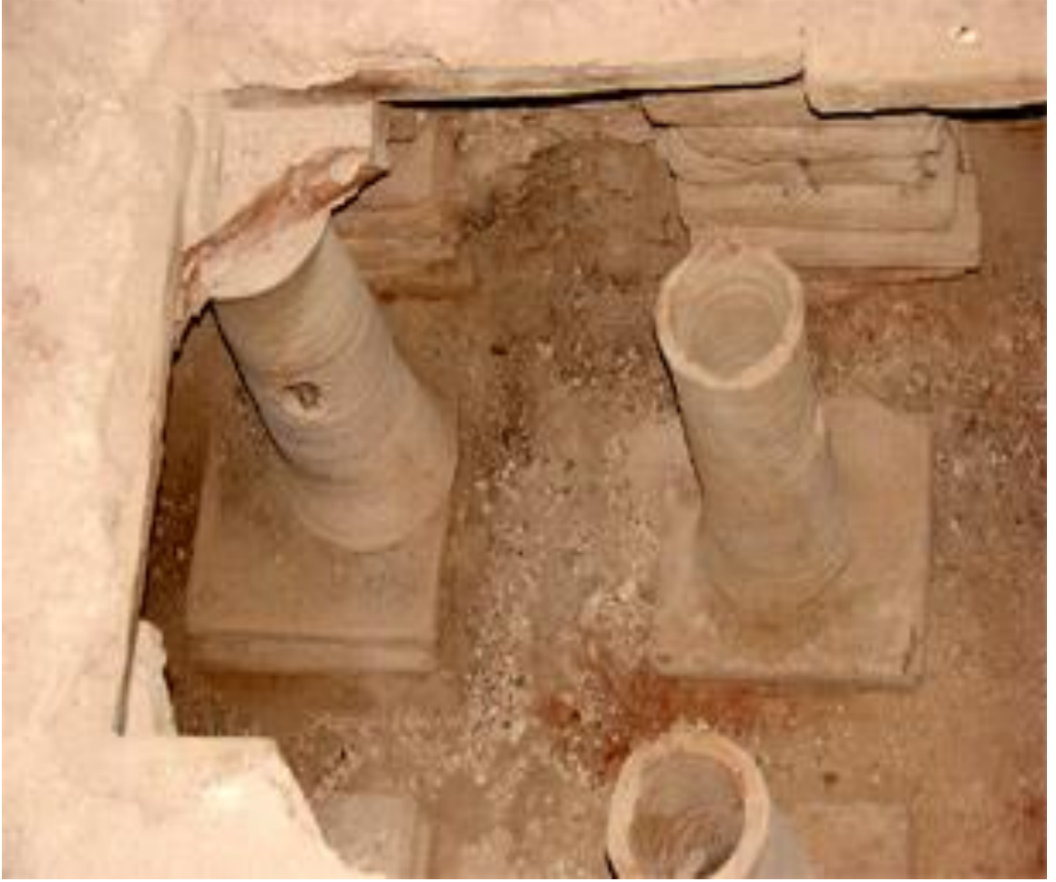
Şekil 5.20. Yunanlıların ve Romalıların Döşemden ısıtma sistemi
