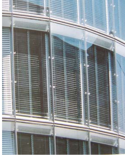
Şekil 9.24 –Cephe görünüşü, güneş kırıcılar
