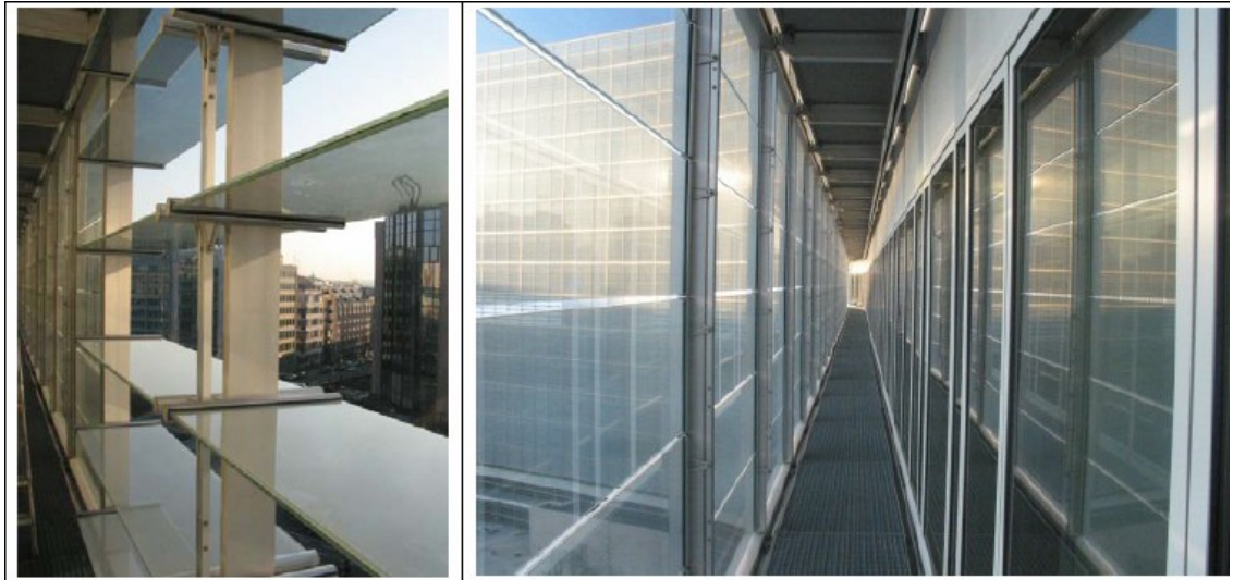
Şekil 5.26 – Jalûzilerin cephedeki yatay ve dikey pozisyonundaki görünüşleri
