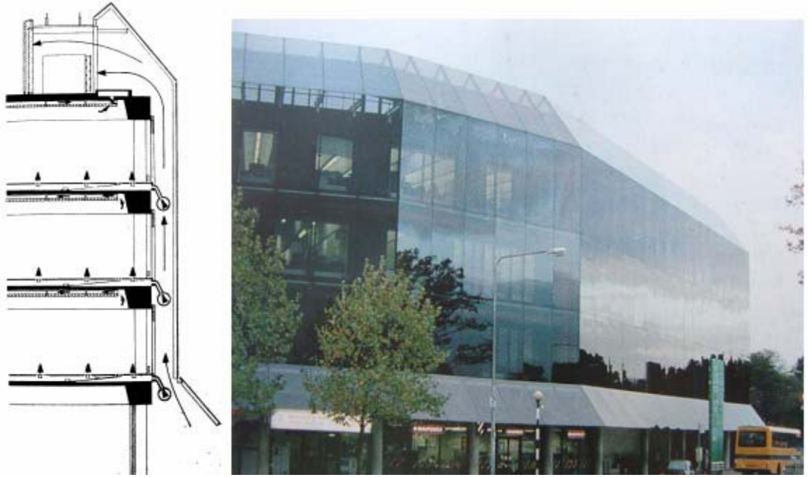
Şekil 5.18 – Mekanik Havalandırılan Cephe Örneği: Briarcliff Evi, /İngiltere
