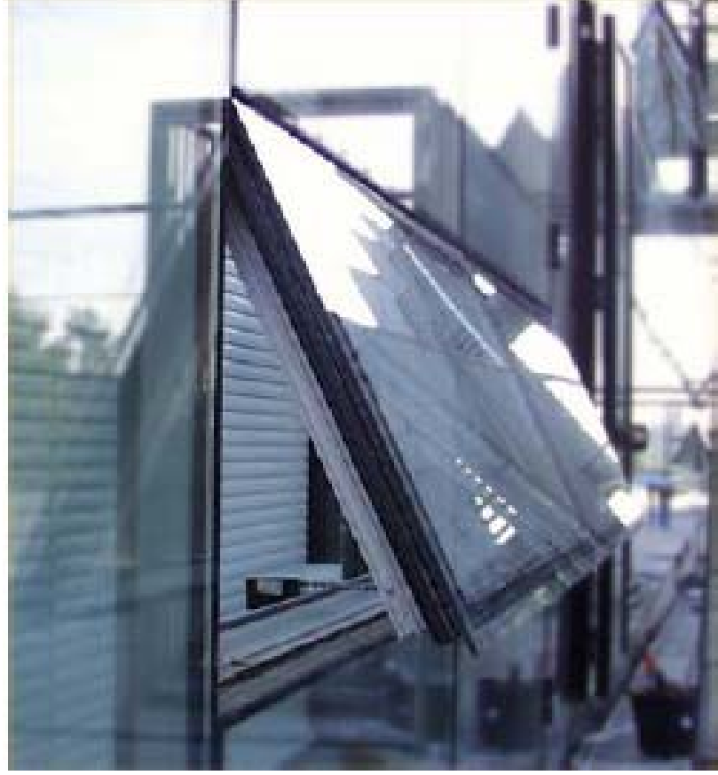
Şekil 5.16 – Doğal havalandırmalı cephelerde kullanılan mekanik pencere örneği
