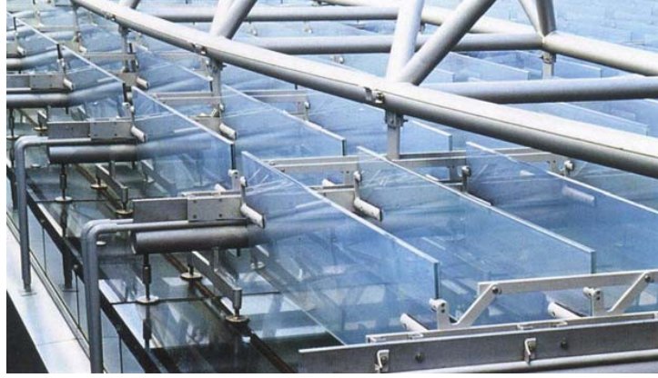
Şekil 9.26 –Hologramlı cam lameller doğrudan gelen ışığı yansıtırken yayıncı ışık iç ortama geçebiliyor
