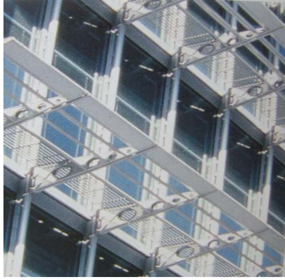
Şekil 5.3 – Hongkong ve Shanghai bankası, güneş kırıcı paneller Hong Kong
