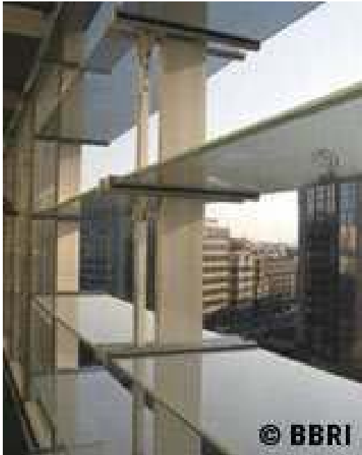
Şekil 5.17 – Doğal Havalandırmalı Çift Kabuk Cephe Örneği
