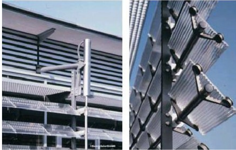
Şekil 5.14 – Sparkasse Fürstentfeldbruck binası cam güneş kontrol elemanları
