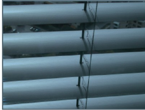
Şekil 9.33 – Hareketli alüminyum panjurların detay görünüşü
