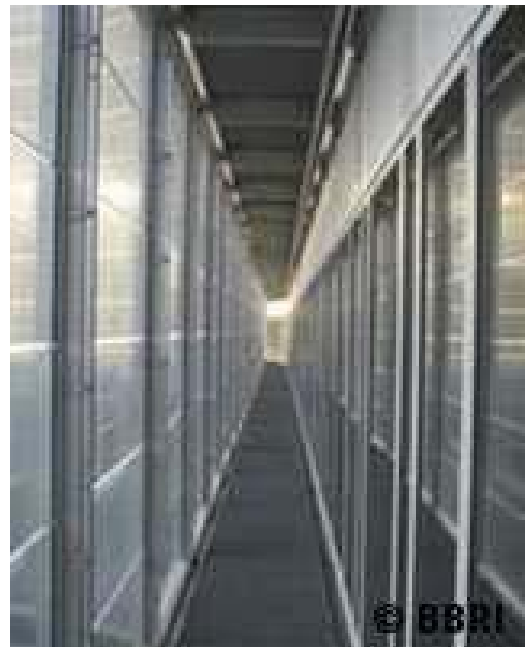
Şekil 5.17 – Doğal Havalandırmalı Çift Kabuk Cephe Örneği
