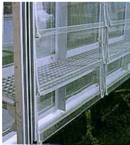
Şekil 9.38 – Yürüme yolu ve dış cephenin detay görünüşü
