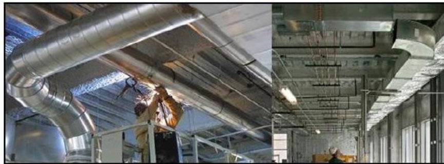
Şekil 6.11 – Yuvarlak ve dikdörtgen havalandırma kanalı
