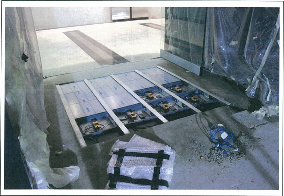
Şekil 1.41. Piezoelektrik Enerjisinden Yararlanan Zemin Paneli (Need more light powerleap., 2011).
