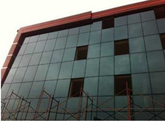
Şekil 4.2: Ağır Asma Giydirme Cephe
