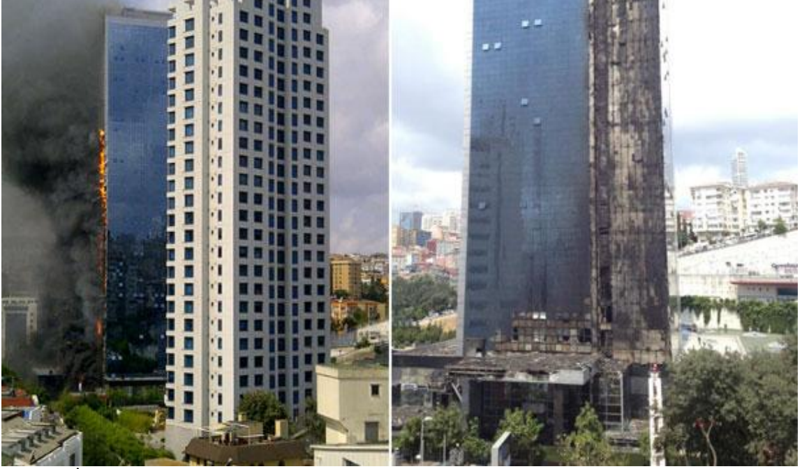
Şekil 7.3: İstanbul Polat Towers'ta Çıkan Cephe Yangını
