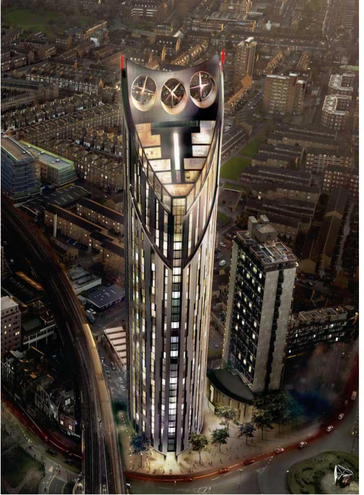
Şekil 5.13: Londra Strata SE1 Binası Rüzgâr Türbinleri
