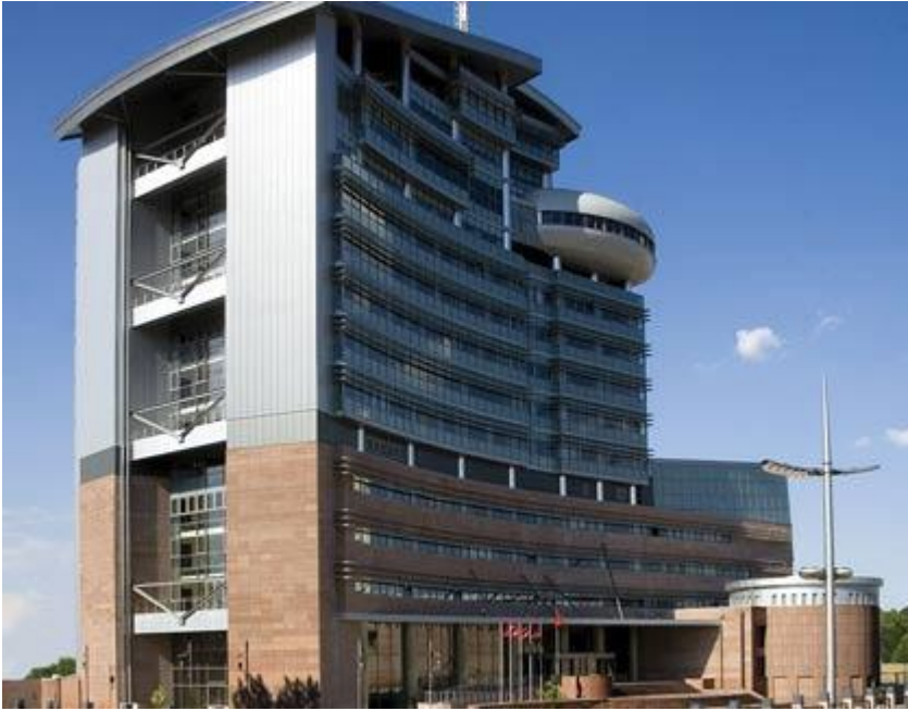
Şekil 6.3: Alüminyum Kompozit Panel Cephe
