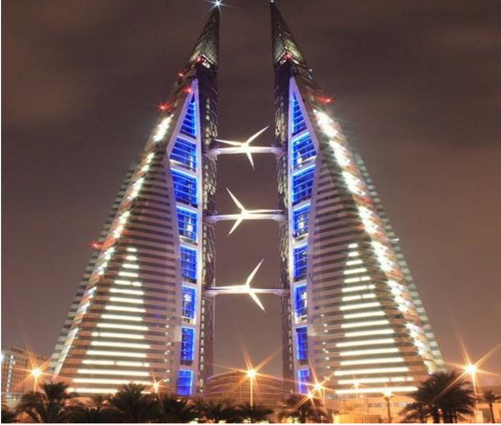
Şekil 5.12: Bahreyn Dünya Ticaret Merkezi Binasında Bulunan Rüzgâr Türbinleri
