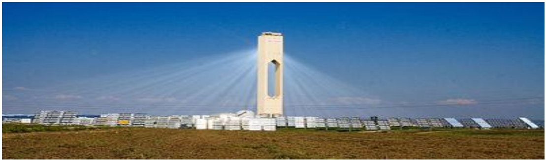
Şekil 4.2. Güneşten Isıl Elektrik Üretim Sistemi [40]
