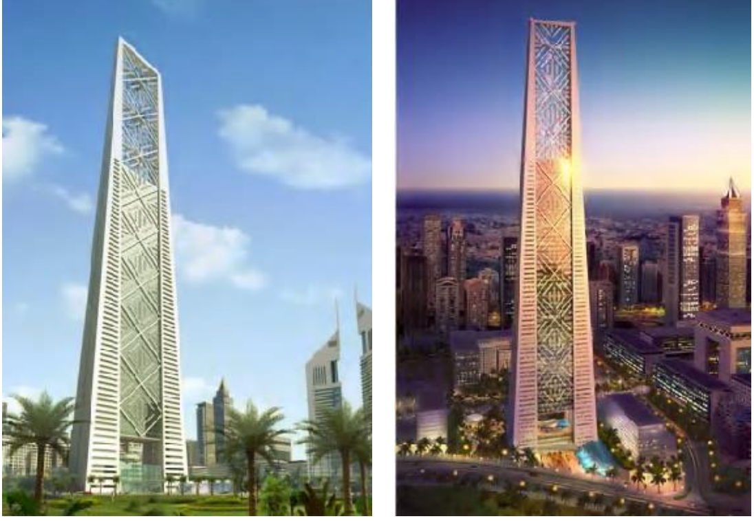
Şekil 7.7. Lighthouse kulesi cephe perspektifi [58]
