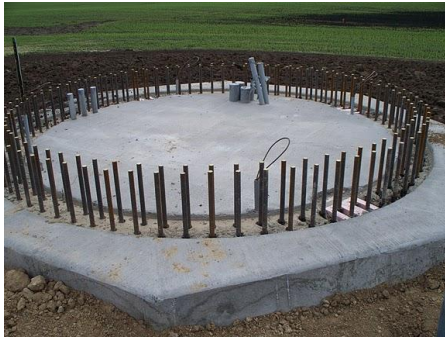
Şekil 5.36. Rüzgar türbini temel sistemi [6]
