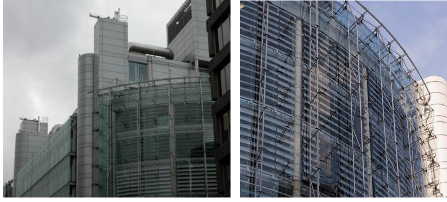
Şekil 5.73. Helicon Building (Londra) cephe görünüşü [6]
