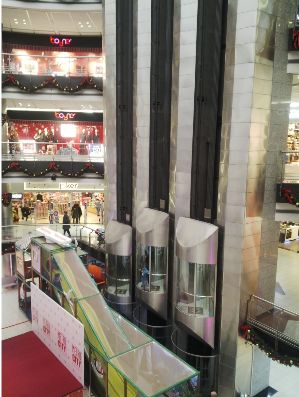
Şekil 6.62. Metrocity galeri boşluğunda bulunan asansör örneği
