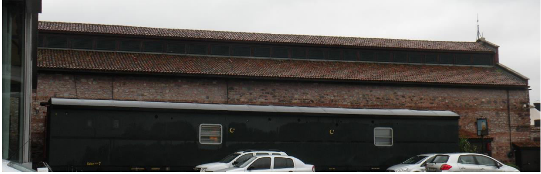
Şekil 5. 26. Hasköy Tersanesi Restorasyon Sonrası Cephe Fotoğrafi Kaynak 5. 26: Selcem Bayır Arşivi
