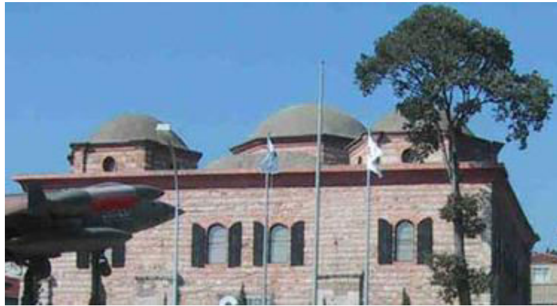
Şekil 5. 22. Restorasyon Sonrası Cephe Fotoğrafı
