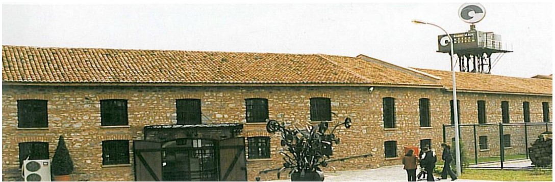
Şekil 5.21: Restorasyon Sonrası Fotoğraflar Kaynak 5.21: Rahmi Koç Müzesi Tasarım Dergisi Arşivi
