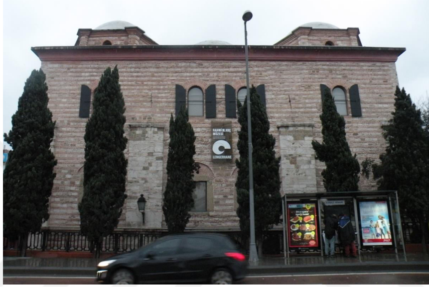
Şekil 5.5.: Lengerhane Binası Restorasyon Sonrası Yol Cephesi Kaynak 5.5.:Selcem Bayır Arşivi
