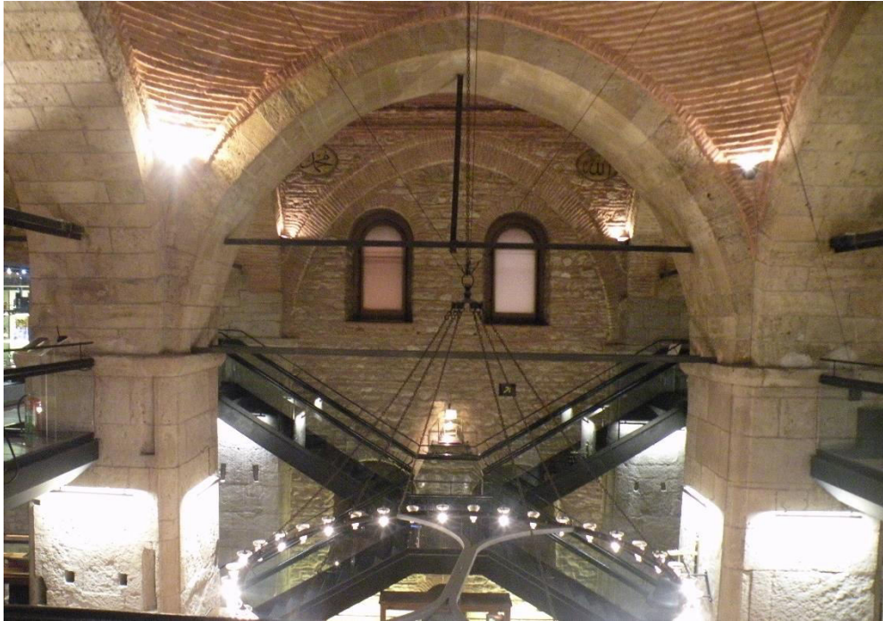
Şekil 5. 27. Lengerhane Binasi Restorasyon Sonrası İç Cephe Fotoğrafi Kaynak 5. 27: Selcem Bayır Arşivi
