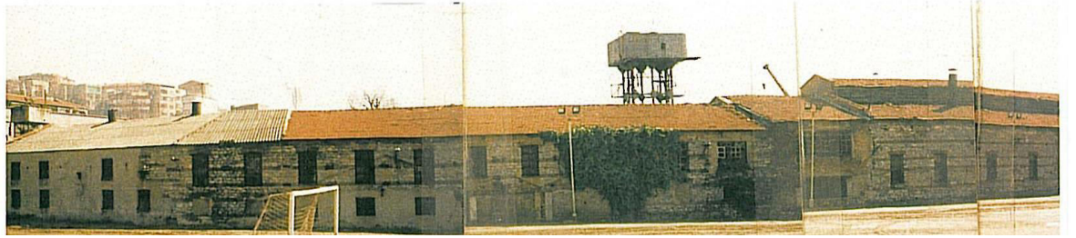
Şekil 5.14. Restorasyon Projesi Cephe Çizimleri Ve Cephe Görünüşü Kaynak 5. 14: Koç Müzesi Tasarım Dergisi Arşivi
