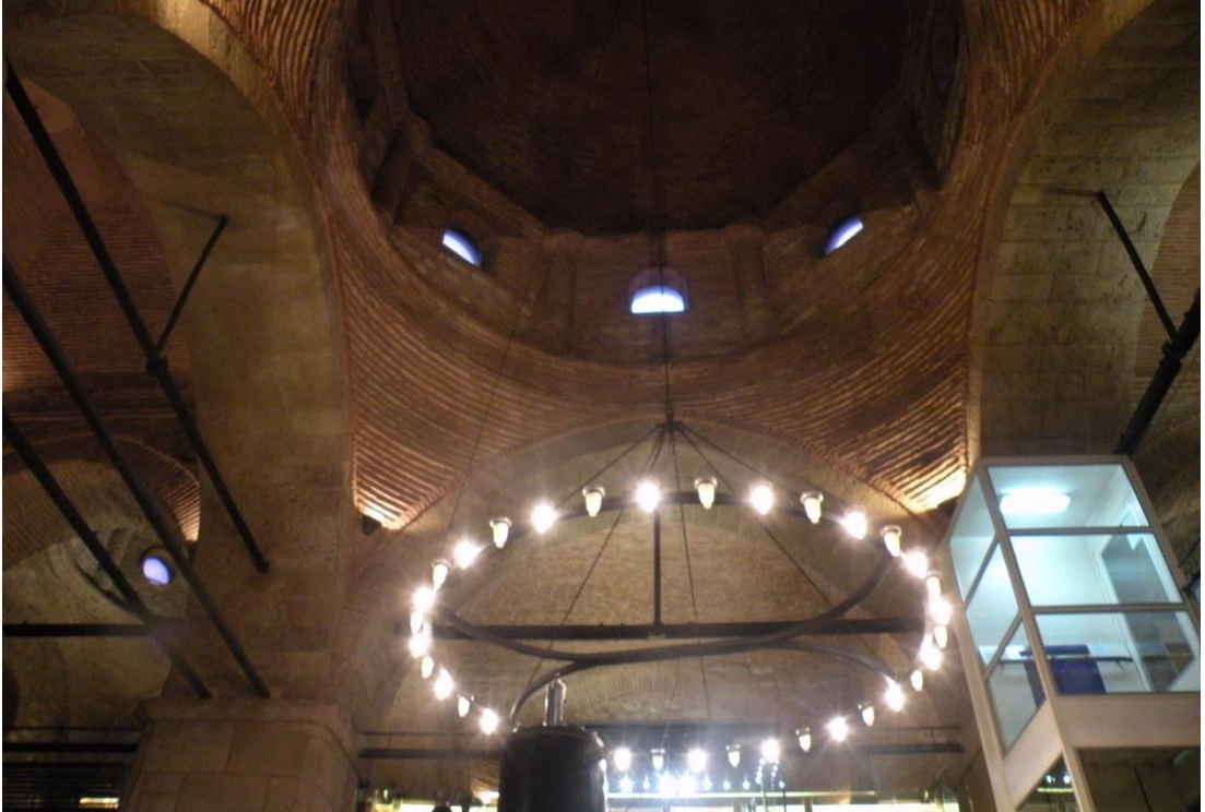
Şekil 5. 36. Lengerhane Binası İç Mekân Fotoğrafi Kaynak 5. 34: Selcem Bayır Arşivi
