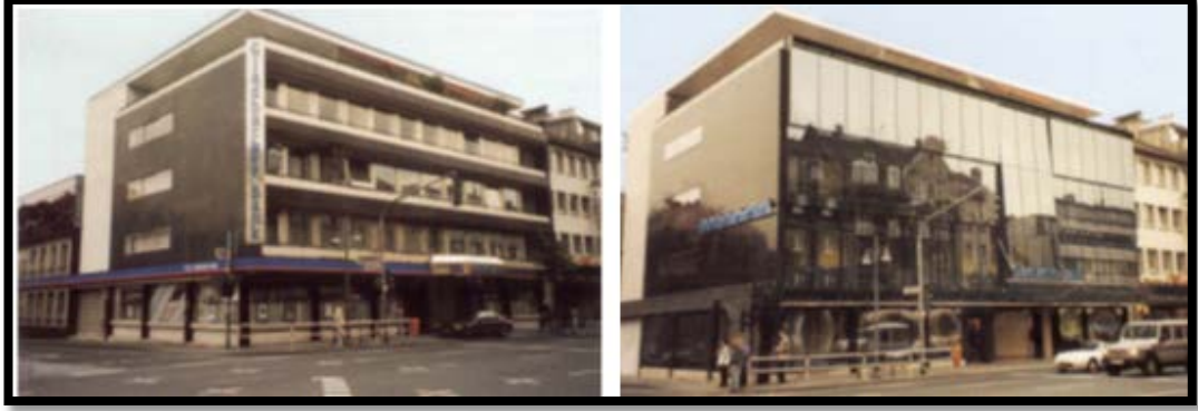
Şekil 2.47. Gladbacher Bank binasının yenileme öncesi ve sonrası (Ünal, 2006: 128)
