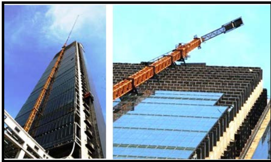
Şekil 3.8. Panel Sistem Dış Kabuğun Binaya Montajı
