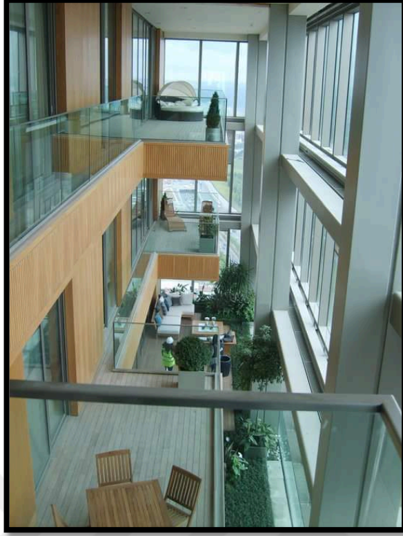
Şekil 3.6. İç Kabuk ile Dış Kabuk Arasındaki Gök Avlulu Havalandırma Boşluğu (Fotoğraf: Gözde ÇAKIR KIASIF, 2010)
