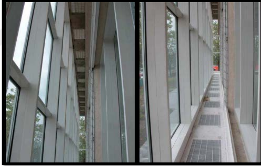
Şekil 2.13. Occidental Chemical Center Ofis Binasının havalandırma boşluğunun tadilatın sonraki durumu ( http://tboake.com/pdf/double_facade_general.pdf )
