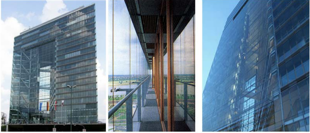
Şekil 9. Koridor Tipi Çift Cephe – Stadttor Binası, Düsseldorf – Almanya [15]
