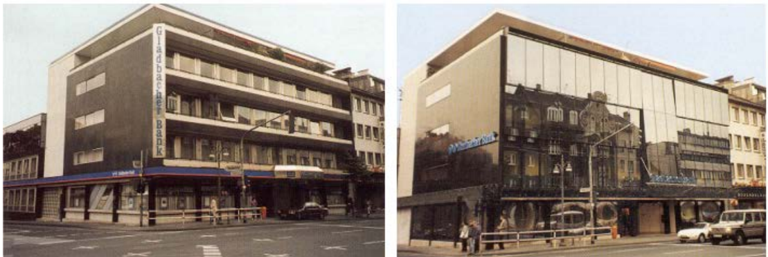
Őekil 15. Gladbacher Bank binasının yenileme ncesindeki ve yenileme sonrasındaki durumu. [9]
