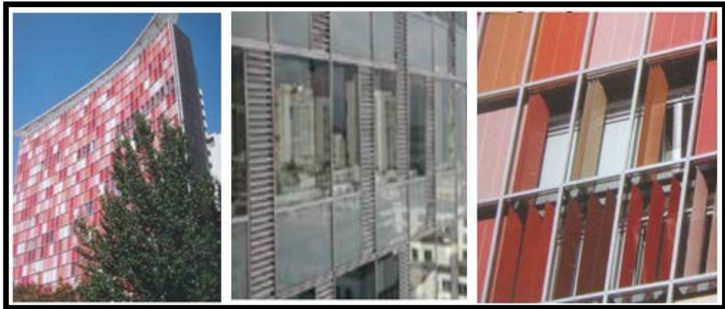
Şekil 2.34. GWS Headquarters Ofis Binasının Genel Görünüşü, Doğu ve Batı cepheleri (Compagno, 2002)
