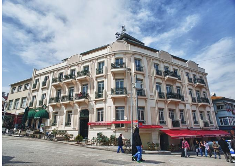
Şekil2.19 Princess Hotel cedde cephesi-Büyük Ada Princess Hotel Web Sitesi
