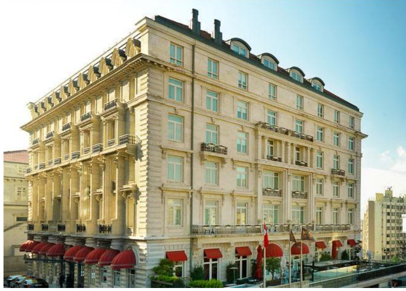
Şekil2.13Pera Palas cephe görüntüsü-Pera Palas web sitesi
