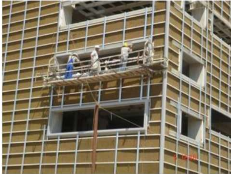
Şekil 2.20 Trapez sac uygulaması. Kaset sistem taşıyünü + tek kat trapez sac+tek kat trapez sac (Polyplex Folyo Fabrikası/Çorlu, http://www.artikelmuhendislik.com )
