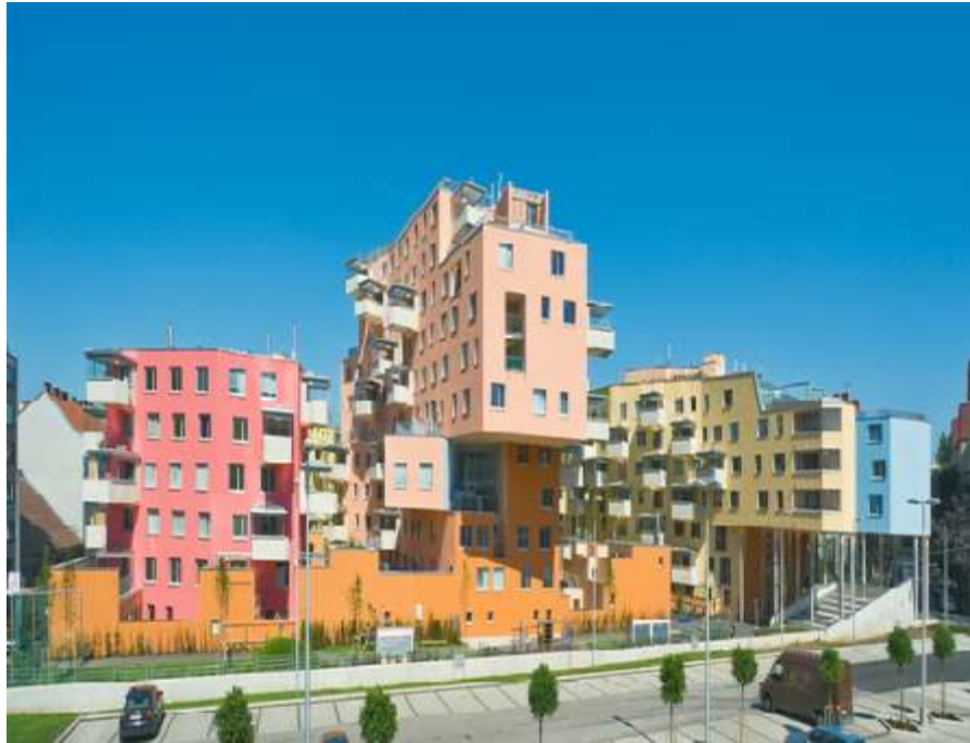
Şekil 3.1 Patlayan Apartmanlar(Viyana,AVUSTURYA,2008) ( http://mitademo.com )
