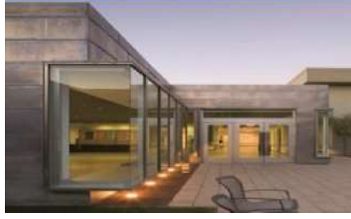
Şekil 2.11 Cephede Düz Metal Levha Uygulaması
