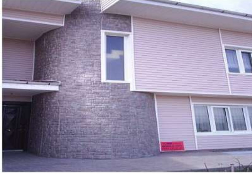
Şekil 2.68 PVC kaplama uygulaması – Taş görünüm ve yalı baskısı ( http://www.paksiding.com )
