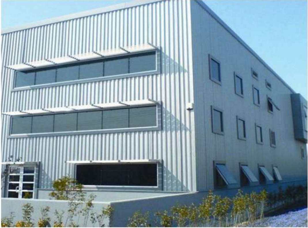
Şekil 2.17 Trapez sac cephe kaplaması örnek (artikelmuhendislik.com, 2012)
