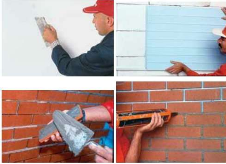
Şekil 2.53 Tuğla kaplama aşamaları ( http://building.dow )
