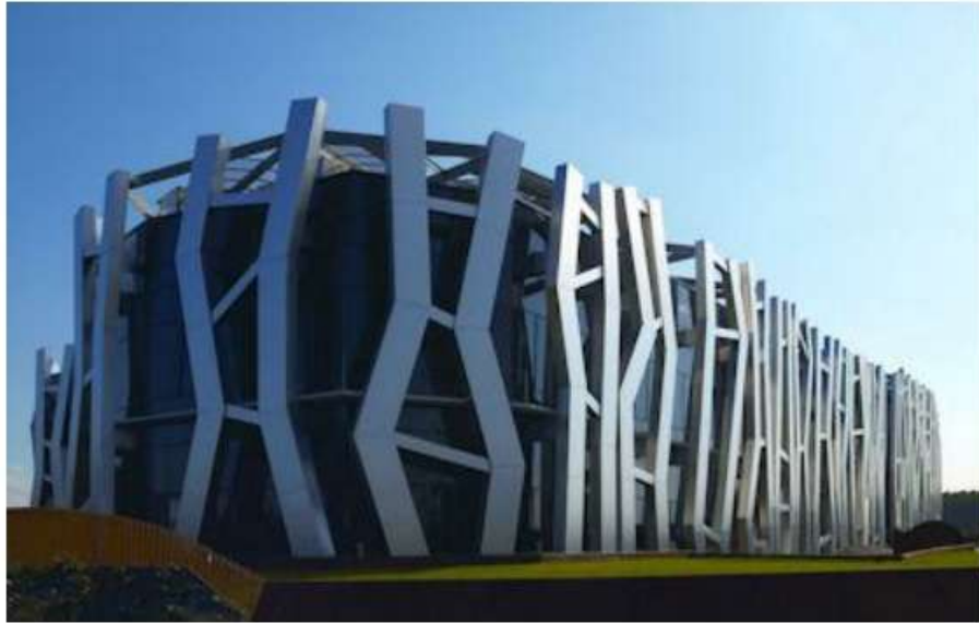
Şekil 2.26 Paslanmaz çelik dış cephe malzemesi kullanımı ( www.raf.com.tr )
