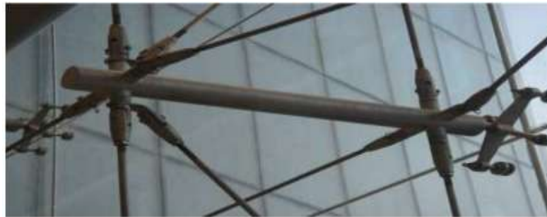
Şekil 2.65 Noktasal bağlantılı sistem giydirme cephe (discephegiydirme.net, 2012)
