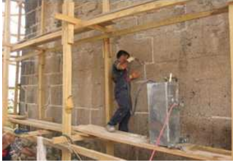
Şekil 2.21.: Cephe Çatlaklarını Onarmak İçin Kireç Esaslı Malzemenin Kullanımı 123
