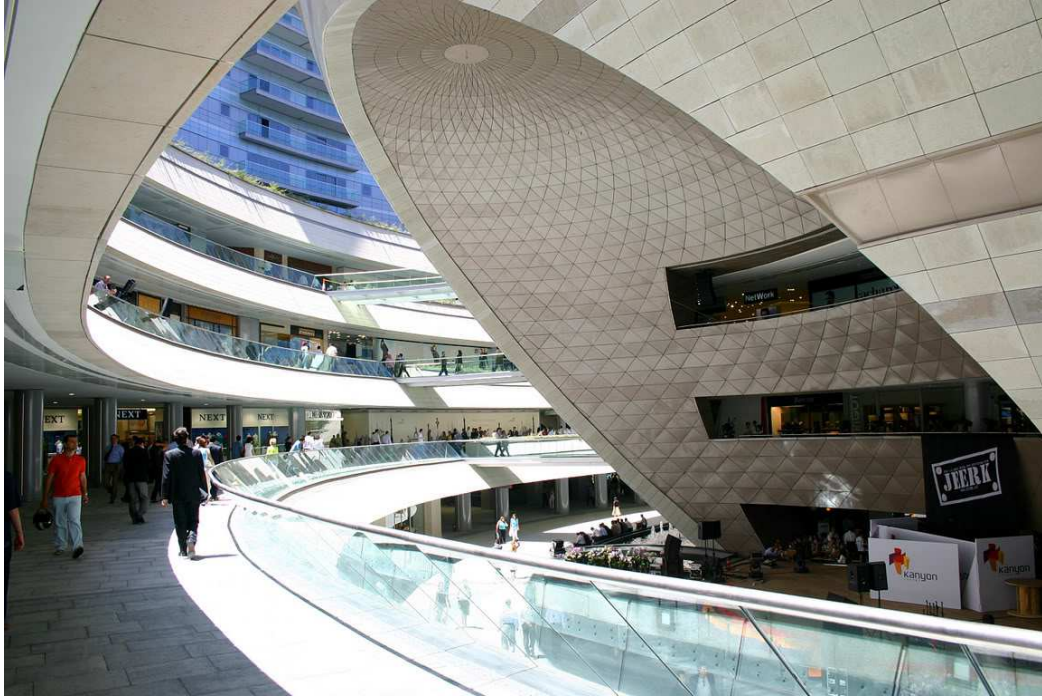
Şekil 2.29.: Cephe Kaplama Malzemesi Olarak Seramik (Kanyon Alışveriş Merkezi, İstanbul) 152
