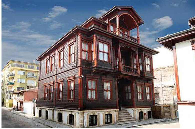
Şekil 2.15.: Ahşaptan Yapılmış Ev (Mihran Hanım Konağı) 105
