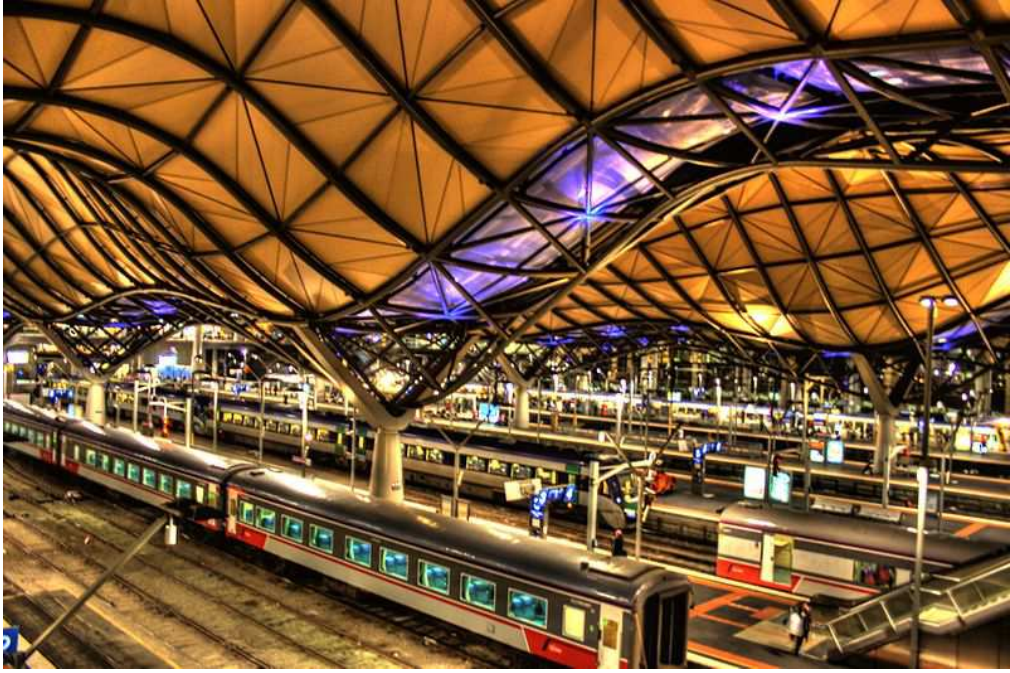
Şekil 2.20.: Çelik Malzemenin Kolon ve Kiriş Olarak Kullanımı (Southern Cross İstasyonu Melbourne, Avustralya) 120
