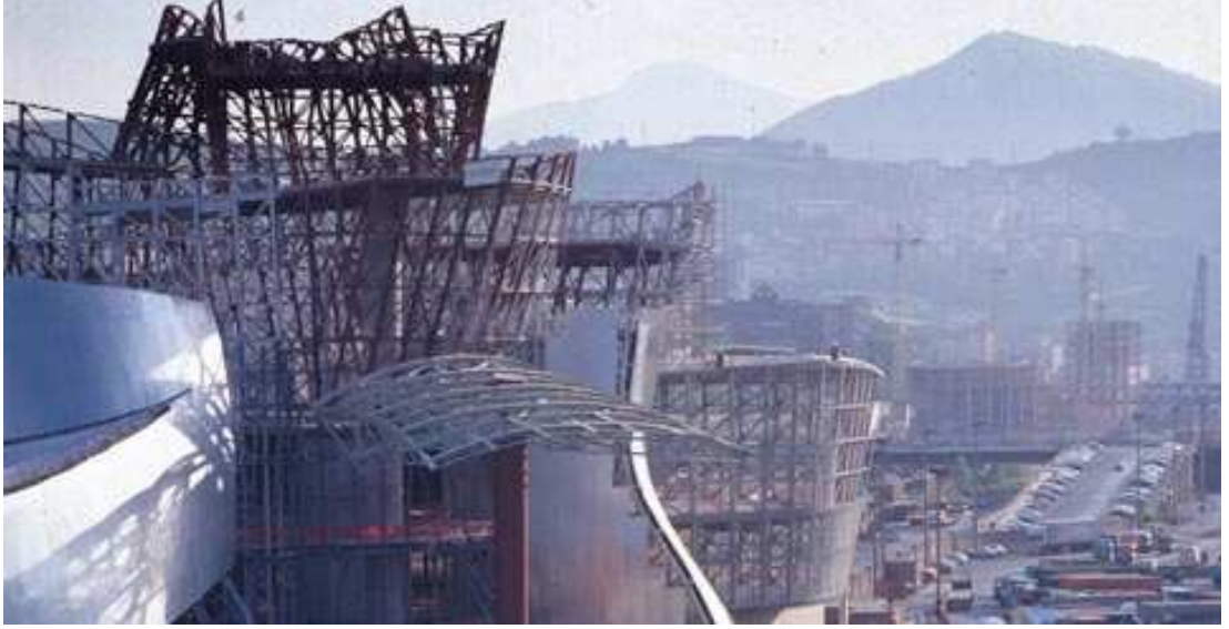
Şekil 4.25.: Yapımı Aşamasındaki Guggenheim Bilbao Müzesi 278
