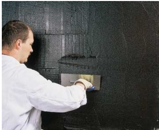
Şekil 2.24.: Su Yalıtımında Bitüm Duvar Kaplamaları 131
