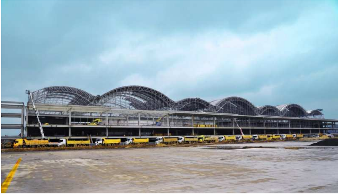
Şekil 4.2.: Sabiha Gökçen Havalimanı Eski İç ve Dış Hatlar Terminali Çatı Kaplama İşleri 223
