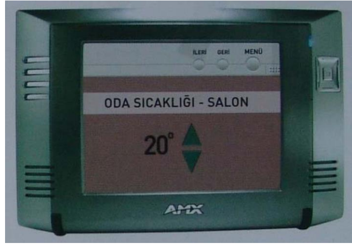
Resim 6 Oda sıcaklık derecesi seçilmiş touch panel
