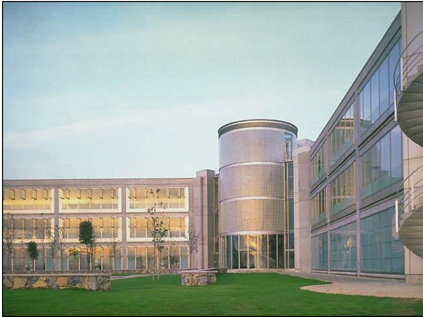
Resim 23 .Yapı Kredi Operasyon Merkezi Binası-1
