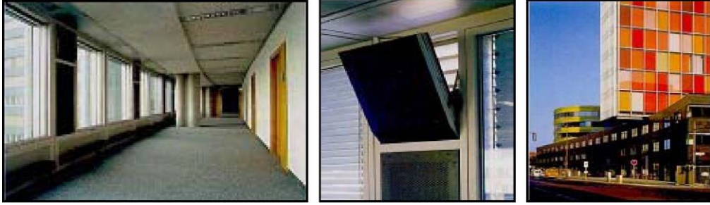
Resim 21. Doğu cephesindeki üç katlı cam sistemi ve batı cephesindeki düşey pivotlu lameller [68]
