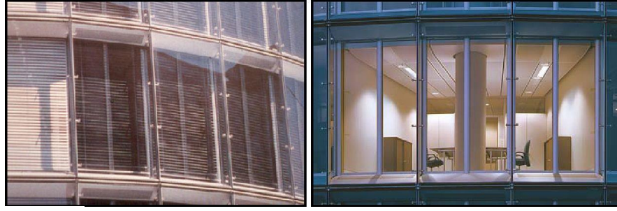
Şekil 18. RWE AG Binasının cephe detay görünüşü [71-72]
