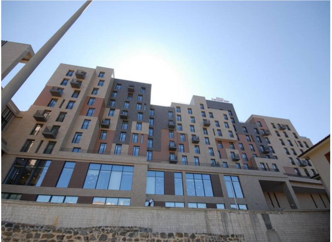
Resim 4.46 Hilton garden inn İstanbul ahşap dış cephe kaplaması
