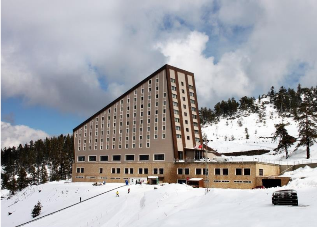
Resim 4.44 Kaya palazzo bolu ahşap dış cephe kaplama uygulaması ( www.hekimyapi.com 1 mart 2015)
