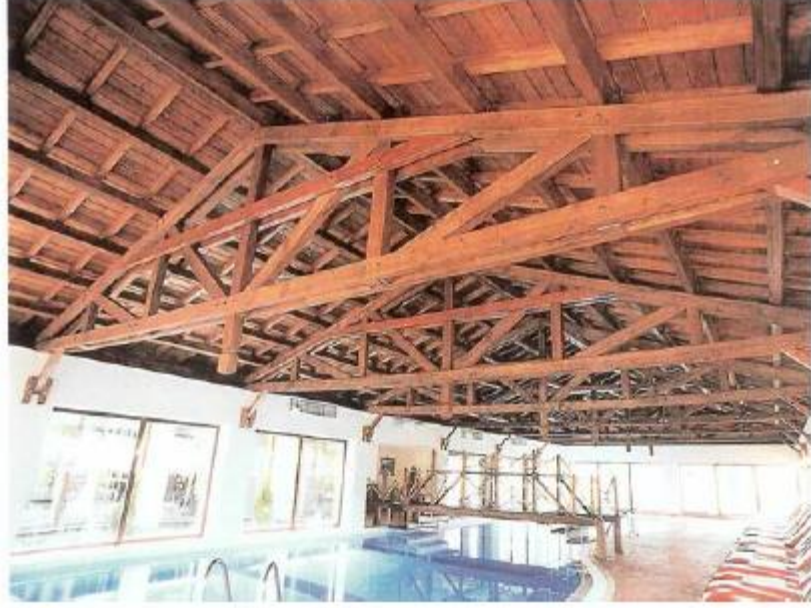
Şekil 3.9 Laminasyonlu ahşap kirişin çatıda kullanımı (www.en.wikipedia.org)
