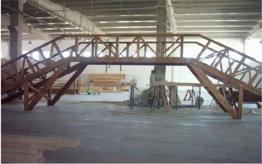
Şekil 3.12 köprünün son hali
