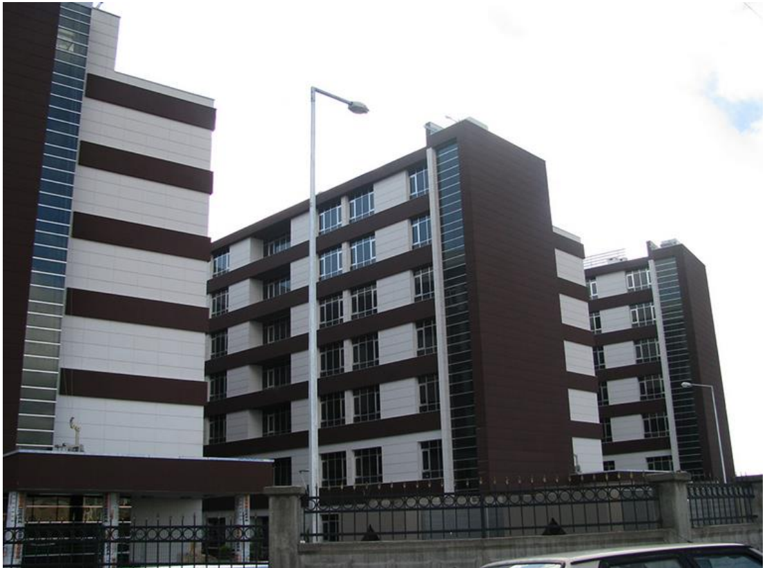
Resim 4.45 T.C Sağlık bakanlığı Adiyaman eğitim araştırma hastanesi ahşap kompozit cephe (www.hekimyapi.com 1 mart 2015)
