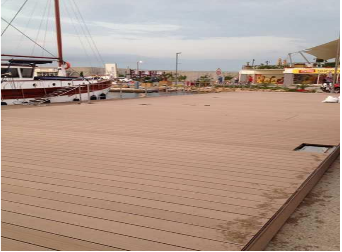
Resim 4.40 Pendik marina çelik konstruksiyon üzeri ahşap kompozit uygulaması ( www.interkps.com 20 şubat 2015)
