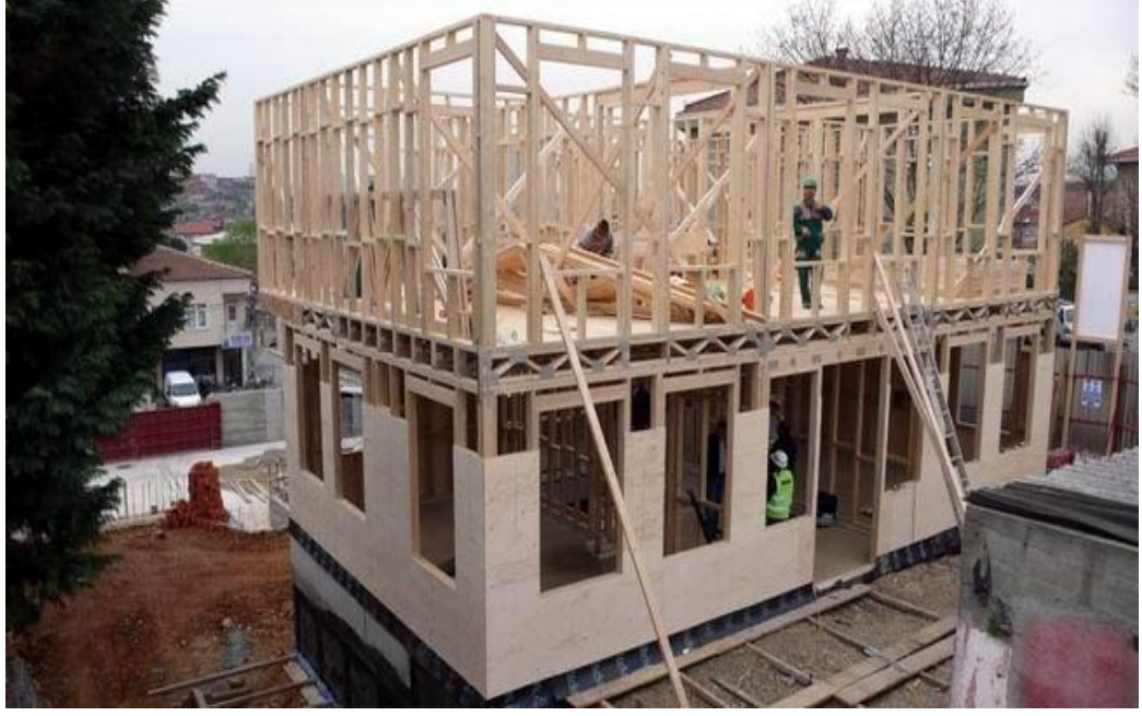
Resim 4.2 İstanbul –avcılar ahşap iskelet sistem örneği (www.emlakansiklopedisi.com 5 şubat 2015)
