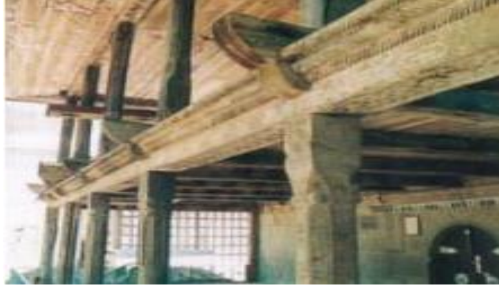
Resim 4.12 Çokgen kesitli sütun uygulaması
