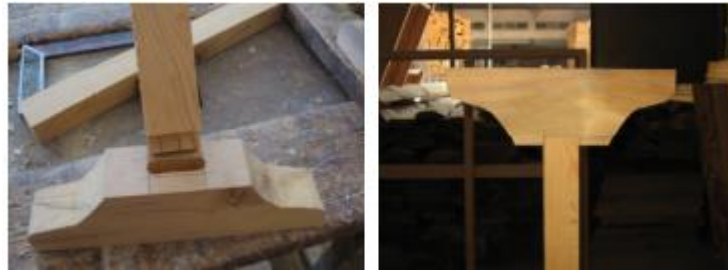
Resim 4.17 Zıvana ve kertme birleştirilmesi
