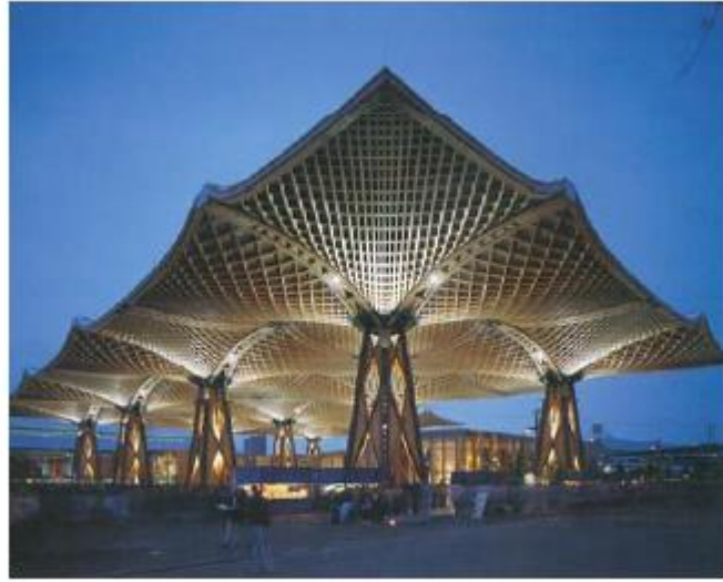
Şekil.3.10 Laminasyonlu ahşap kirişlerle yapılmış fuar alanı Almanya(www.en.wikipedia.org)
