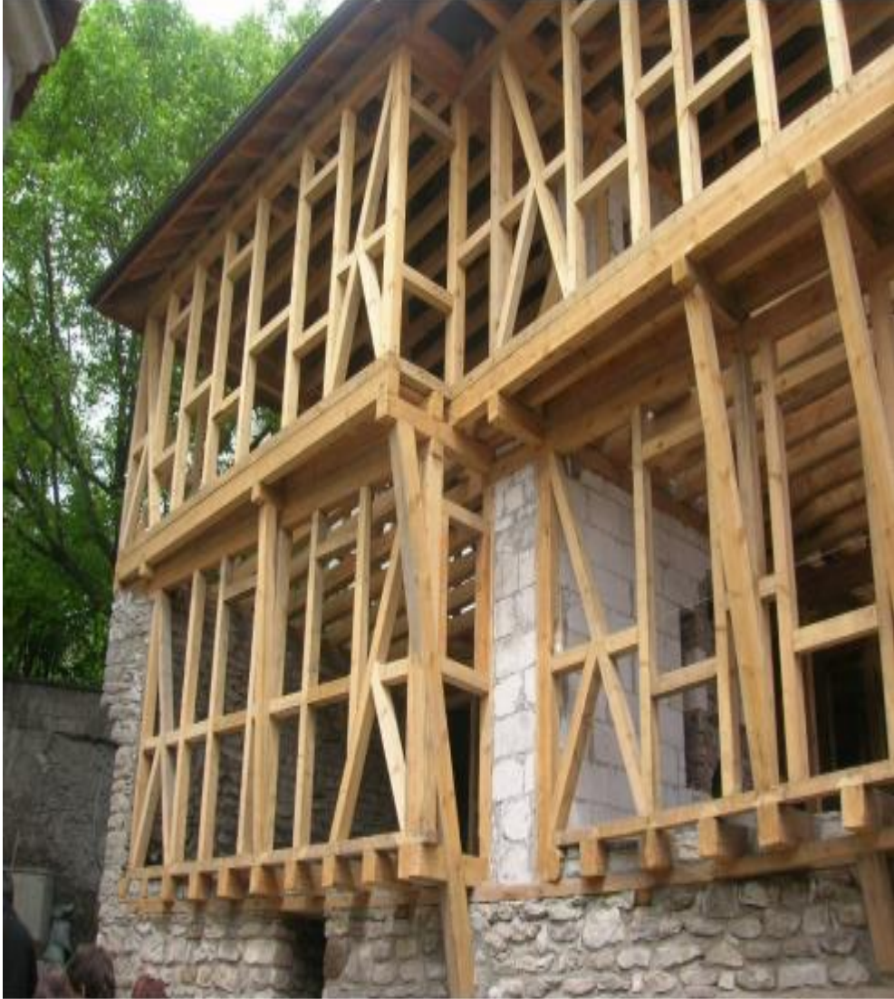
Resim 4.1 Ahşap İskelet Sistem Taşıyıcı Kısımlar
