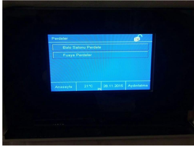
Şekil: 4.12. İstanbul'da Bulunan Bir Otelin Balo Salonu Dokunmatik Panel Perde Ayarları-1
