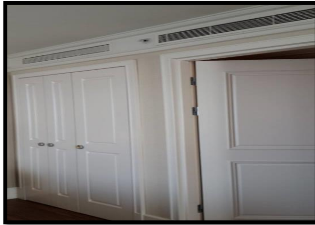
řekil: 3.78. King Suit Oda Fan-coil Havalandırma Sistemi
