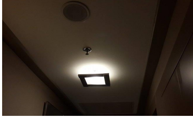
Şekil: 4.40. Renaissance İstanbul Polat Bosphorus Hotel, Deluxe Oda Yangın Sprinkleri
