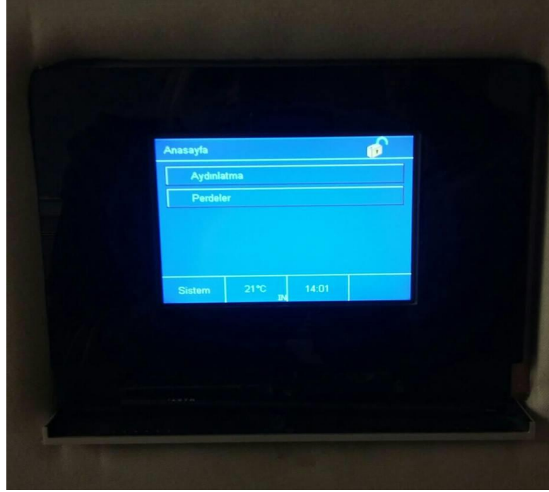
Şekil: 4.14. İstanbul'da Bulunan Bir Otelin Balo Salonu Dokunmatik Aydınlatma Ayarları-1 Kaynak: Bahar Yüce,2015
