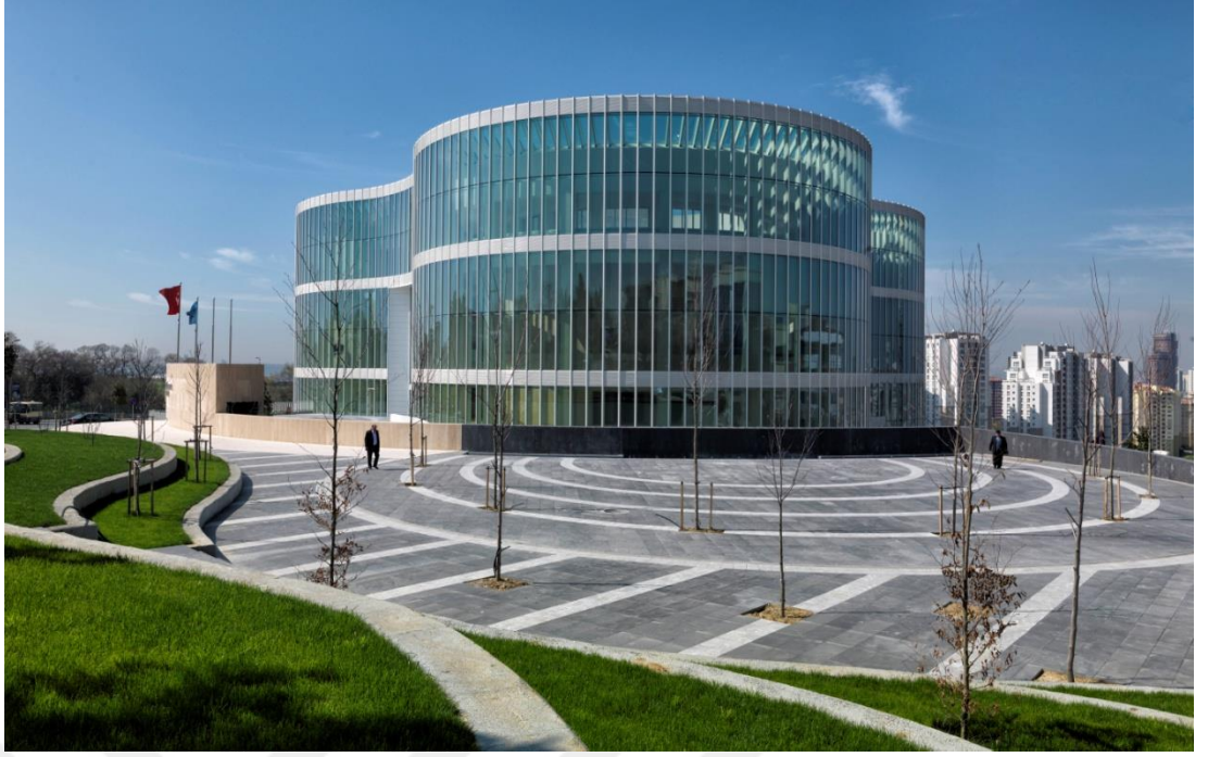
Şekil 3.22. Çift Kabuklu Cephe, Küçükçekmece Belediye Binası( http://ismd.org.tr/wp-content/uploads/anafoto1.jpg ) -Mutlu Çilingirođlu
