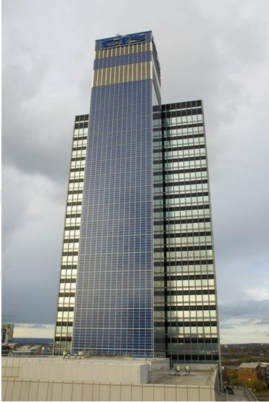
Şekil 3.15. Dünyanın İlk Forovoltoik Cephe Kaplamalı Binası - Skidmore Owings Merrill ( http://wonderfulengineering.com/worlds-first-skyscraper-that-is-covered-with-solar-panels/ )
