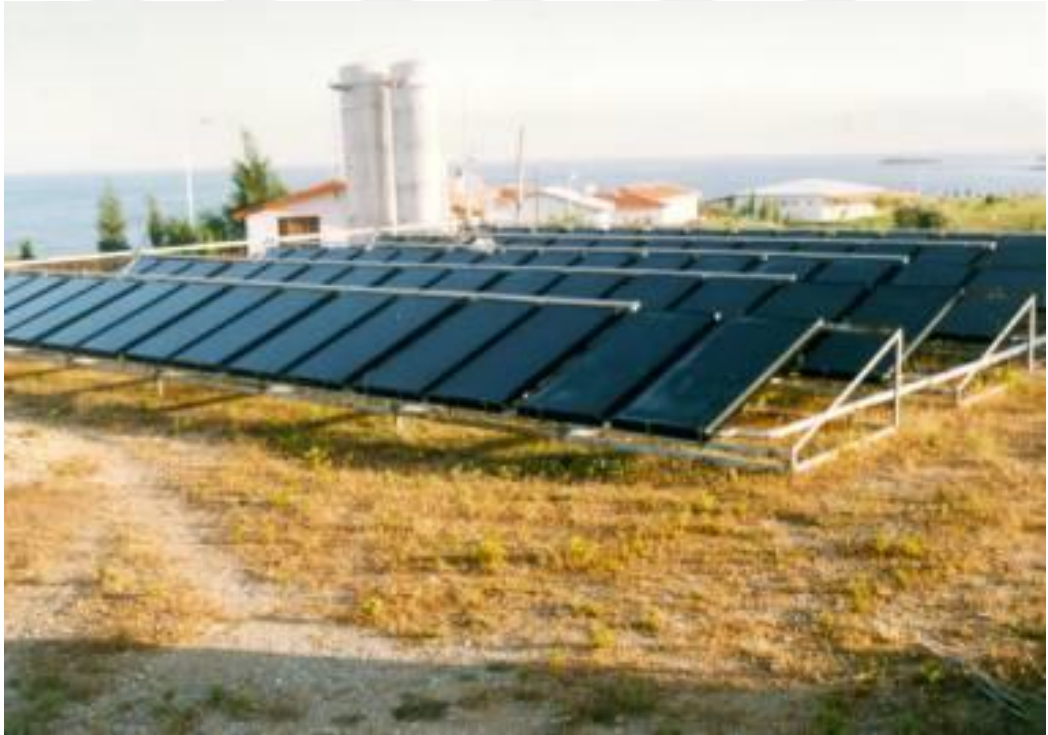
Şekil 3.17. Düzlemsel Güneş kolektörleri ( http://www.guvenetin.com/Enerji/GunesEnerjisi/image0014.jpg )
