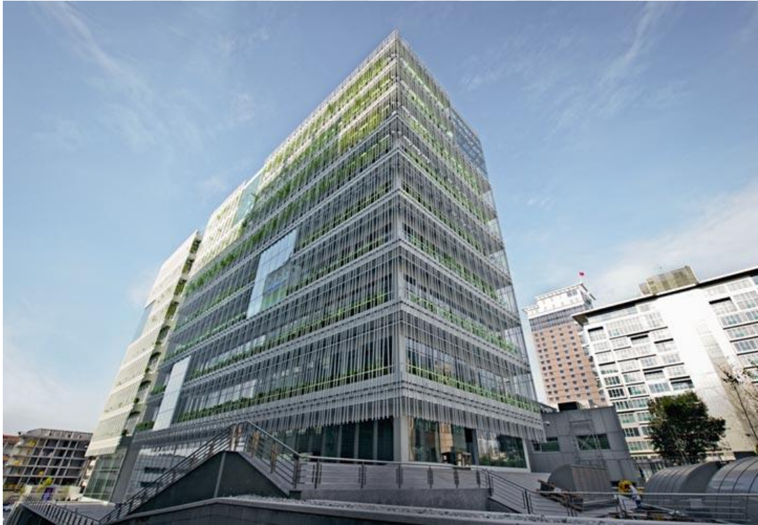
Şekil 3.44. Tekfen Levent Ofis Binası (Altensis, 2016)
