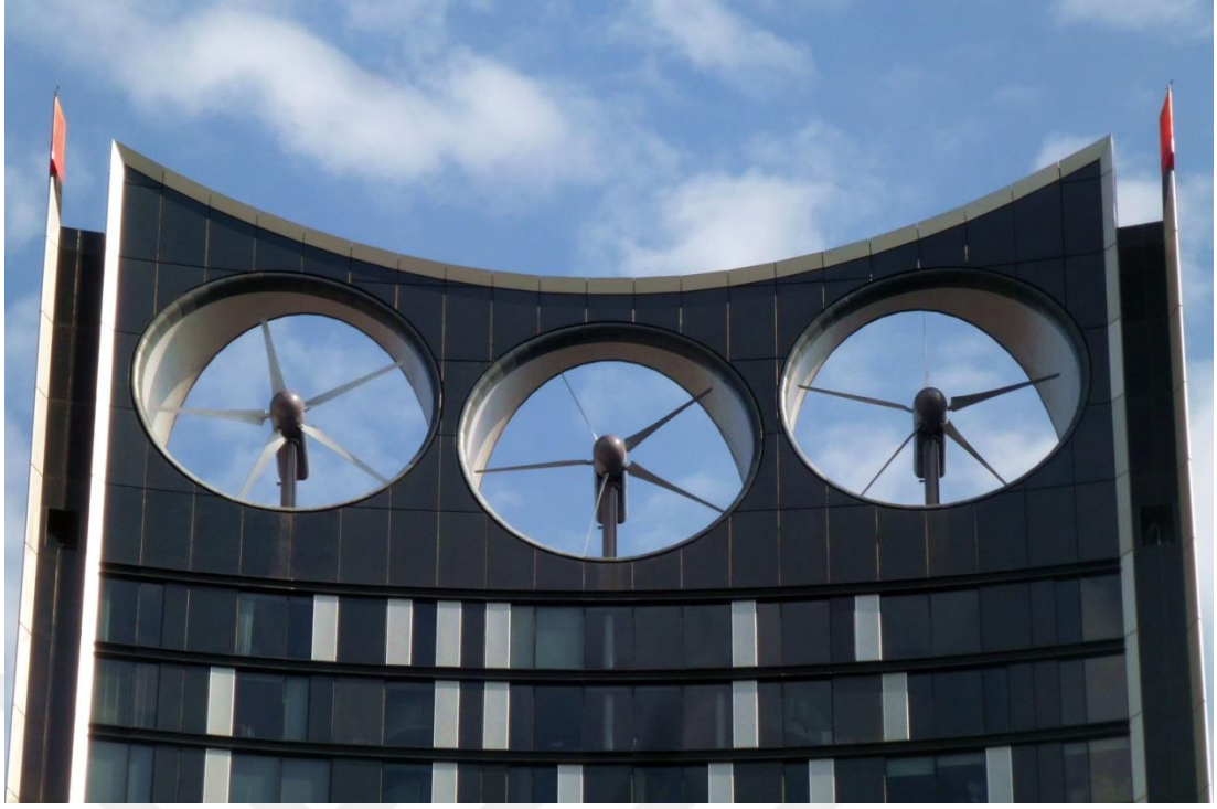
Şekil 3.18. Panel İçerisine Yerleştirilmiş Rüzgar Türbini Strata_Tower - BFLS
