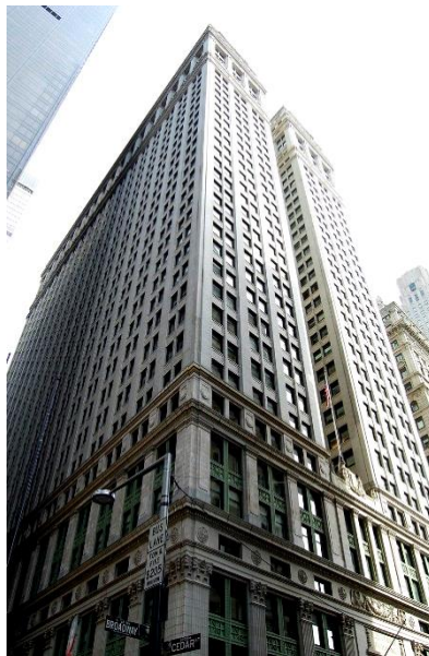
Şekil 2.8. Equitable Binası (URL – 10)
