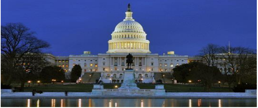
Şekil 3.2. D.C Washington Capitol Binası (URL – 110).
