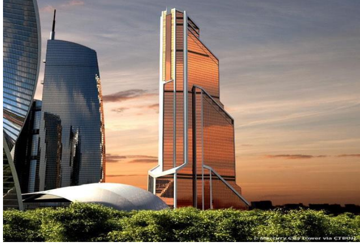
Şekil 2.26. Mercury City Tower (URL- 33)
