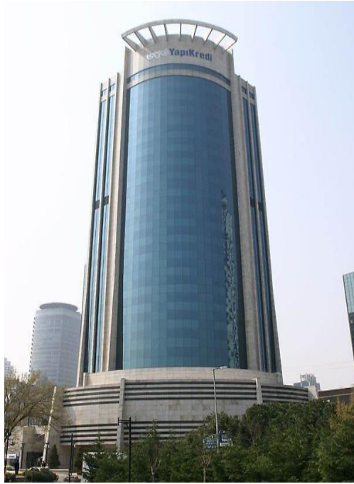
Şekil 2.59. Yapı Kredi Headquartes (URL – 75)
