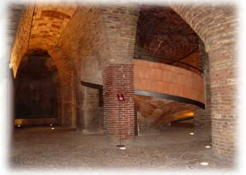
Şekil 4.55. Spiral giriş rampası
