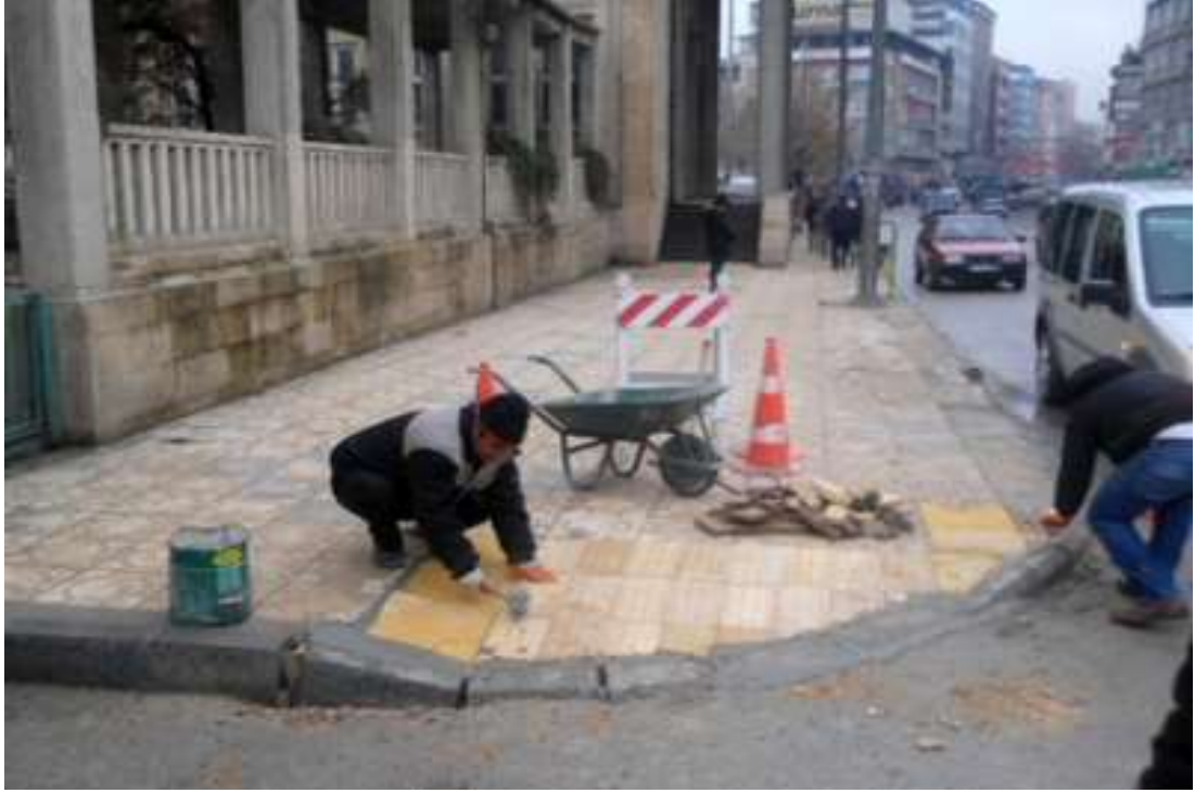
Şekil 2.15. Gaziantep Büyükşehir Belediyesi'nin yapmakta olduğu engelli rampası ve hissedilebilir yüzey çalışması- Mart 2012 ( http://www.haberler.com/bu-kaldirimlar-engelli-dostu-3435834-haberi/ )
