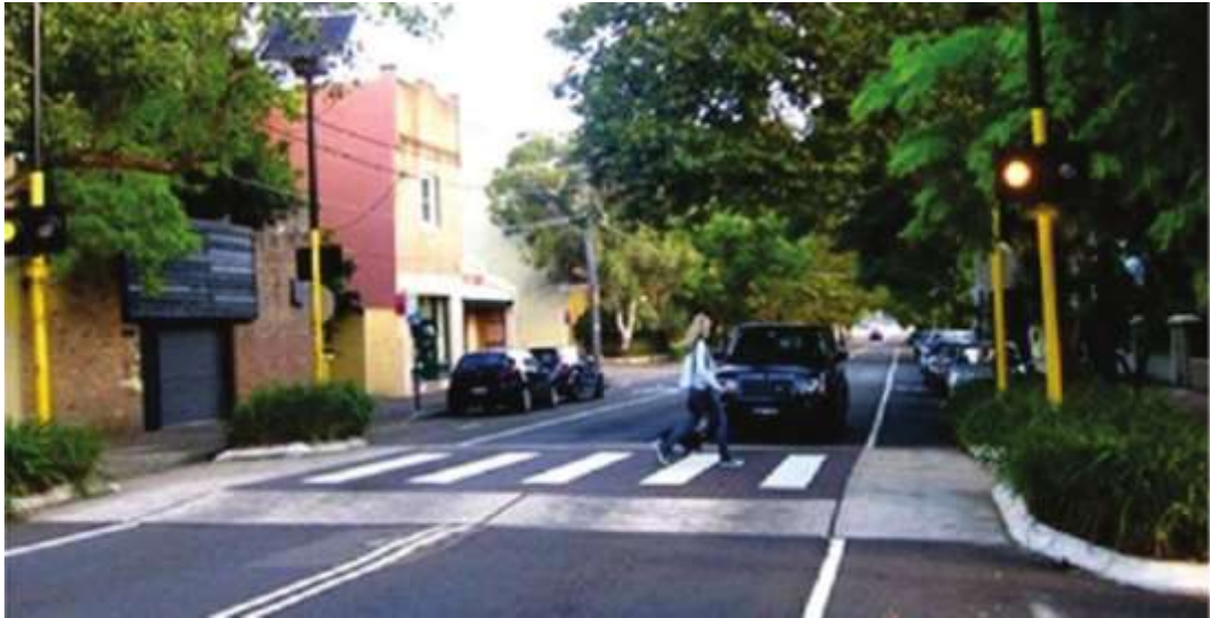
Şekil 3.29. Işık kontrolsüz hemzemin yaya geçişlerinden örnek. Haziran 2012 tarihli TS 12576 nolu standart. s.30
