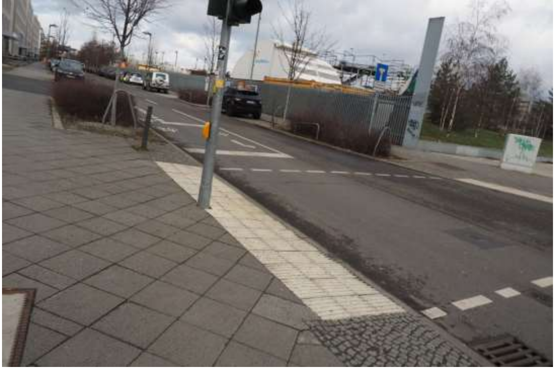
Şekil 3.31. Işık kontrollü hemzemin yaya geçişlerinden hissedilebilir yüzey kaplama tipleri. Berlin-Almanya 2016 (K.Karakuş Arşivi).
