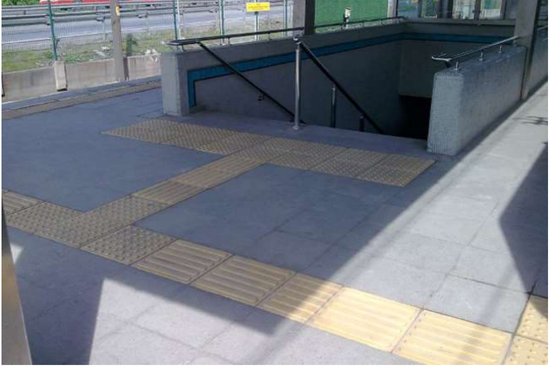
Şekil 2.17. İstanbul Büyükşehir Belediyesi'nin Aksaray-Havalimanı Metro Hattı İstasyonlar'nda uygulamış olduğu hissedilebilir yüzey çalışması örneği.
