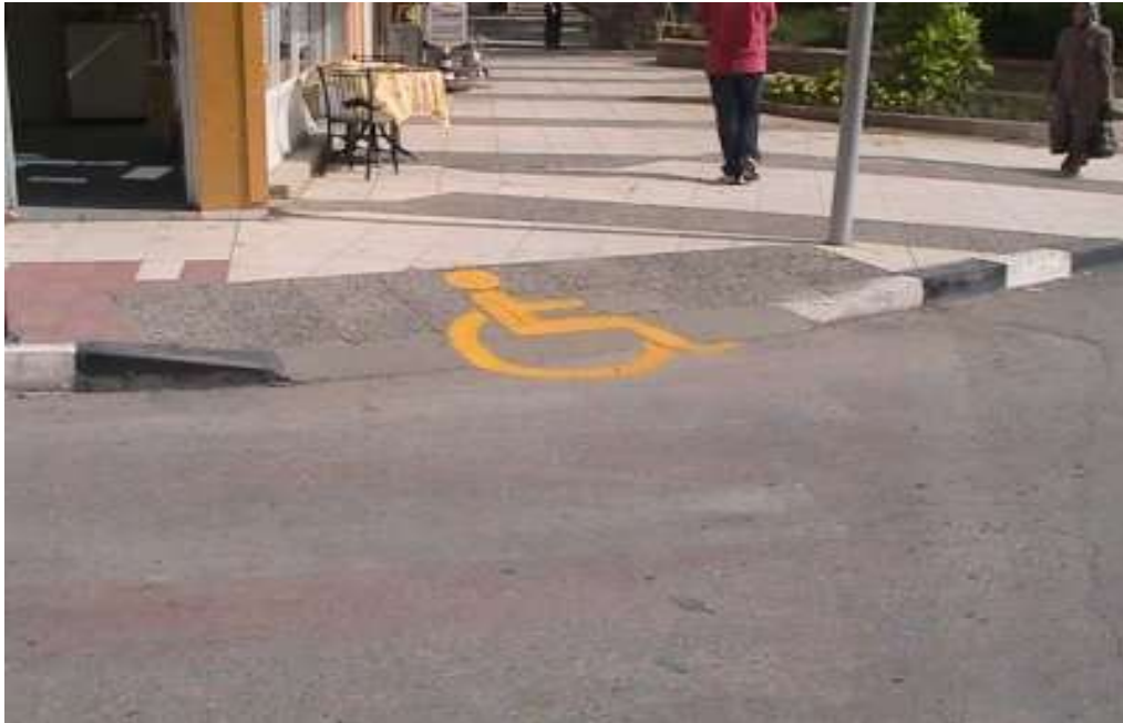
Şekil 2.8. Manisa'da kaldırım rampa uygulaması
