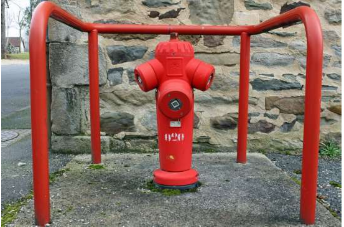
Şekil 1.15. Yangın musluğu örneği ( https://pixabay.com/tr/yangin-musluğu-sokak-hidrant-270064/ )
