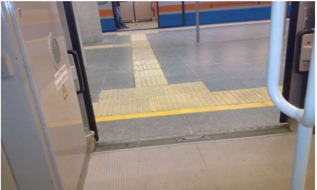
Şekil 2.18. İstanbul Büyükşehir Belediyesi'nin Aksaray-Havalimanı Metro Hattı İstasyonlar'nda uygulamış olduğu hissedilebilir yüzey çalışması örneği
