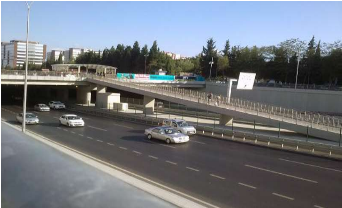
Şekil 2.10. İstanbul Büyükşehir Belediyesi'nin Beylikdüzü Metrobüs istasyonunda uygulamış olduğu engelli rampası çalışması ( http://static.panoramio.com/photos/large/78656872.jpg )
