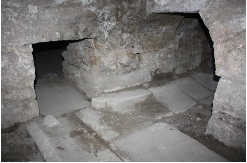
Resim 36: Yıkama ihtiyacını karşılamak için yapılan oda su giderini ayarlamak için taş eğimler yapılmıştır.
