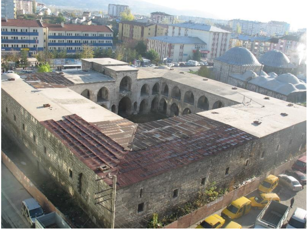
Resim 42: Çatının 10 cm 2008 de mozaikle kaplanmış hali
