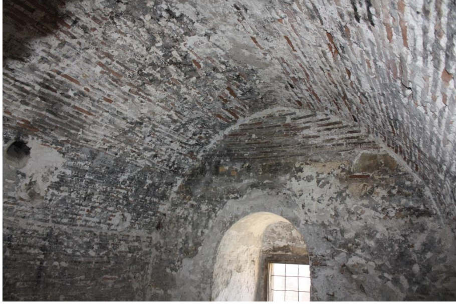
Resim 11: Sivas Behram Paşa Hanı Oda Çatı Örtüsü Örneği
