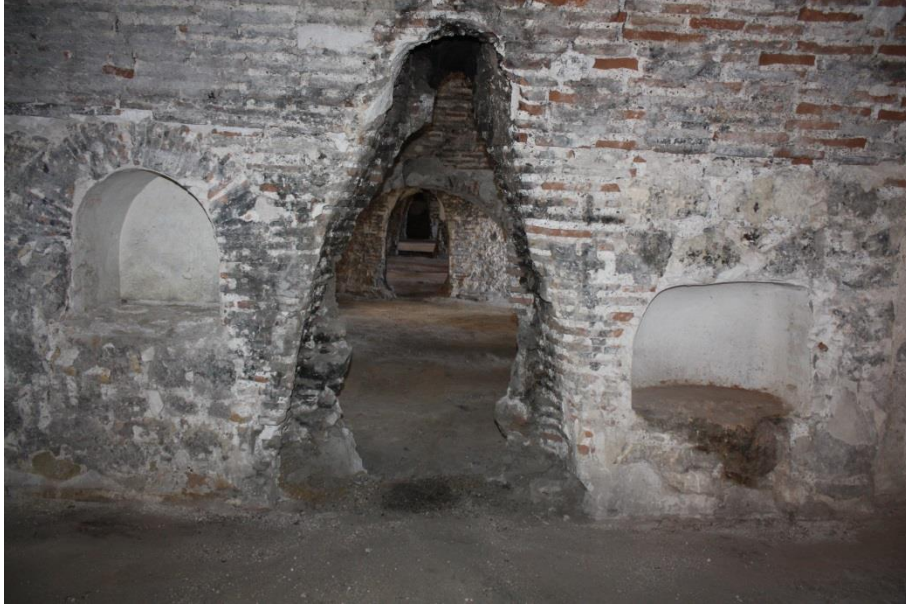
Resim 13: Sivas Behram Paşa Hanı Oda Örneği Askeri Kışla Zamanında Odalar Birleştirilerek Yatakhane Olarak Kullanılmıştır.
