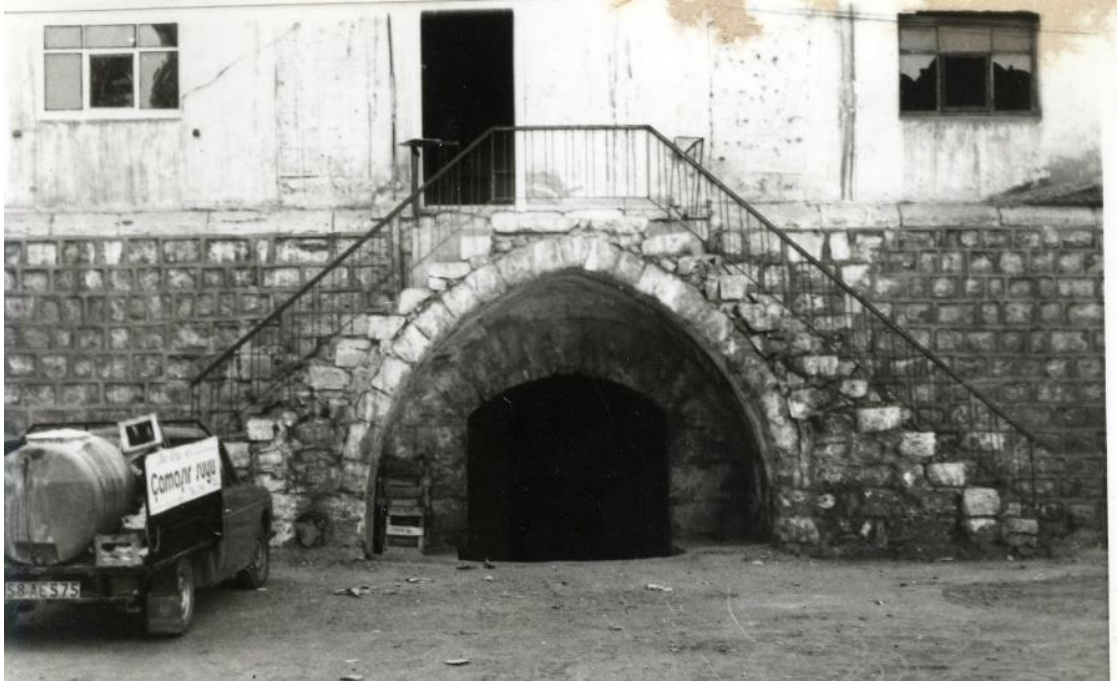
Resim 38: Kuzeybatı yönündeki Develik (ahır girişi) kısmı ve üst kat merdiveni
