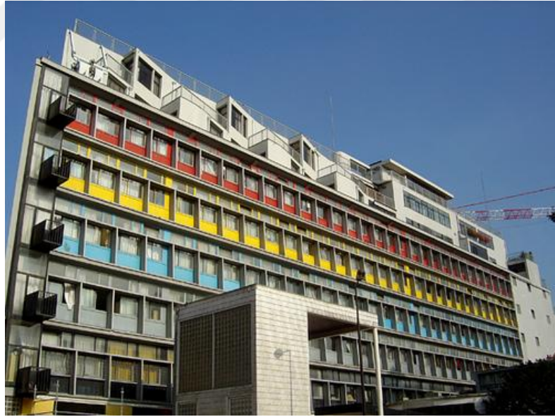
Resim 2.5 Cité de Refuge Binası, (Evsizler sitesi), ((b.t.). 10 Temmuz 2009,
