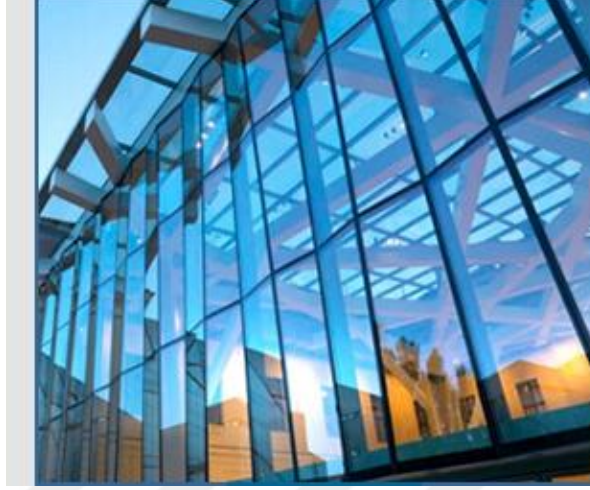
řekil 7.2: Yarı kapaklı cephe sistemi
