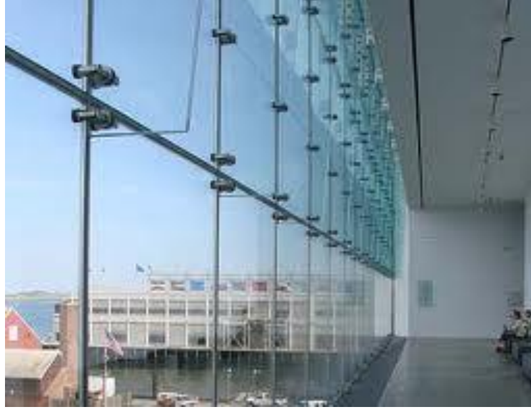
Şekil 7.6: Spider cephe sistemi
