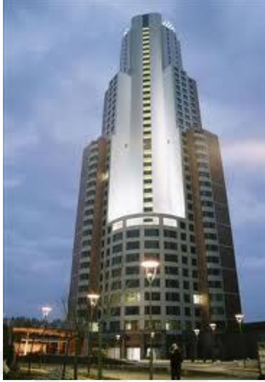
Şekil 2.3: Ülkemizden bir giydirme cephe örneği
