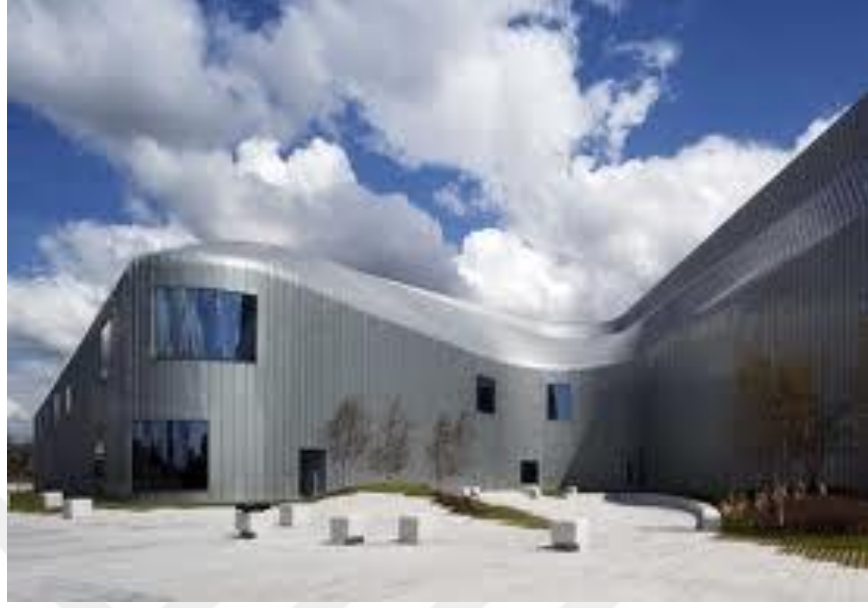
Şekil 8.4: Çinko cephe sistemi
