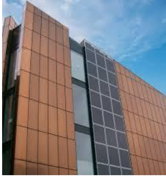
Şekil 8.6: Terracotta cephe sistemi
