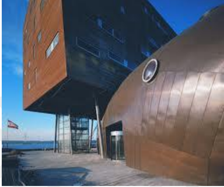
Şekil 8.3: Bakır cephe sistemi
