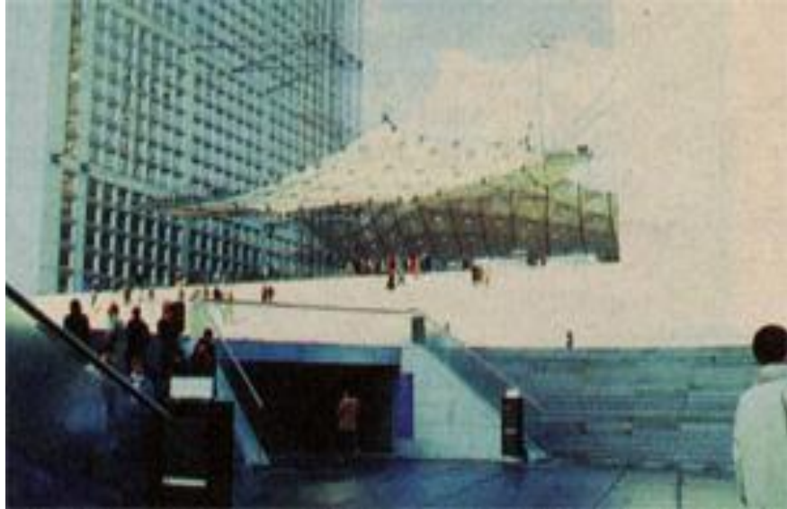
Şekil 6.2: Peter Rice, Paris'te Le Grand' Arche binası giriş saçağı. Asma germe sistemle 'bulut'.
