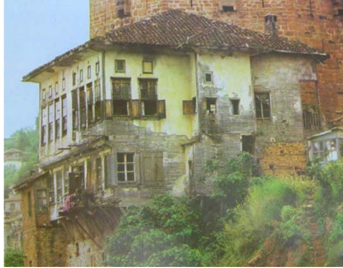
Resim 3.23: Alanya, karkasın üzerine bağdadi çıtaları çakılmış (Özhan 2006)
