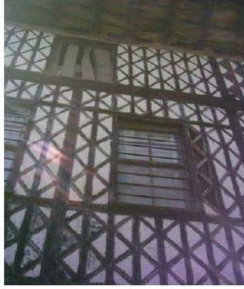
Resim 3.35: Muskalı dolma sistem için sıvalı bir örnek.
