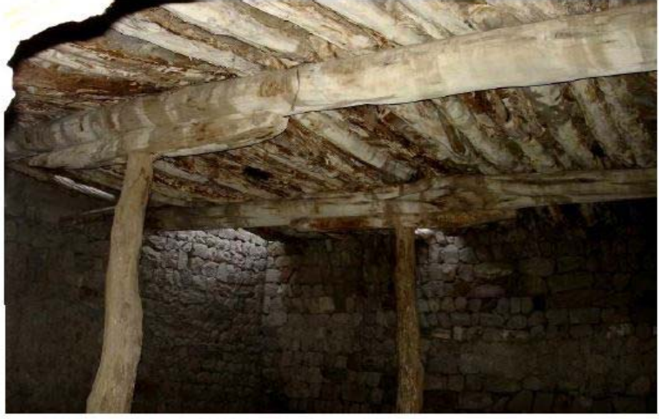
Resim 3.7: Son derece dayanıklı bir tür olan ardıcın yapıda kullanımı, Karahöyük/Kayseri
