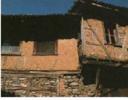
Resim 3.3 (üstte): Taş örgü üzerinde yükselmiş kerpiç yığma şeklinde karkas sistemli ev
