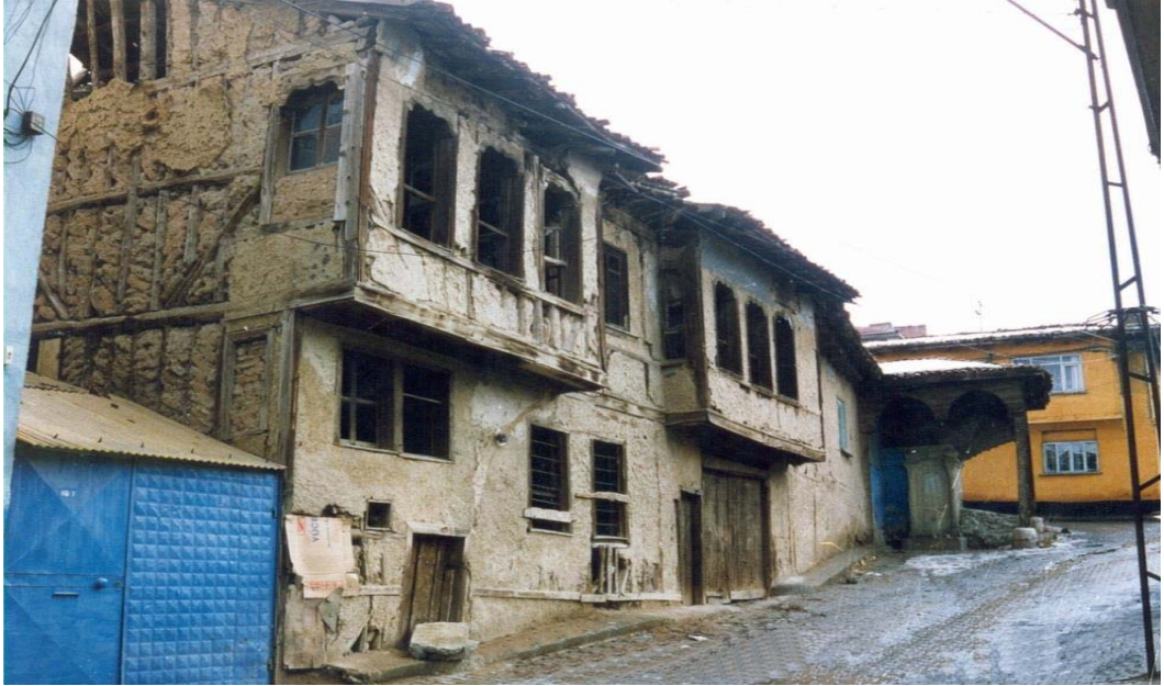
Resim 3.19: Eskişehir Paşa Mahallesi, Ayvazlar Konađı (kerpiç dolgu)
