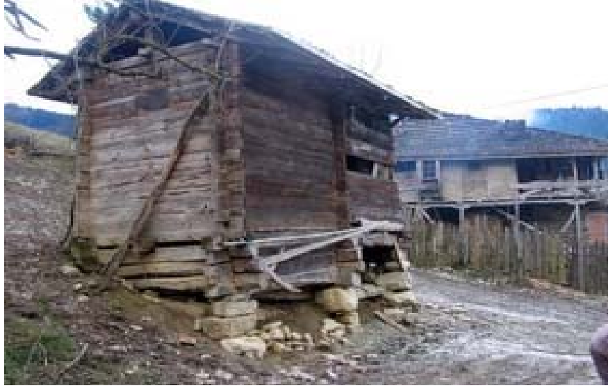
Resim: 3.10: Yığma ahşap (kütük) ev, Bartın.
