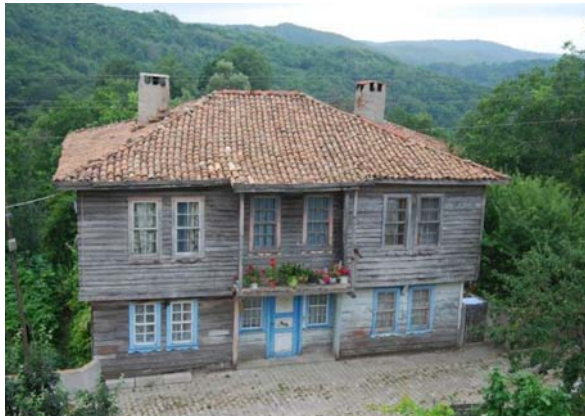
Resim 3.21: İstanbul, Şile bağdadi çıtalı ahşap yapı( http://www.restorasyonforum.com , 2011)
