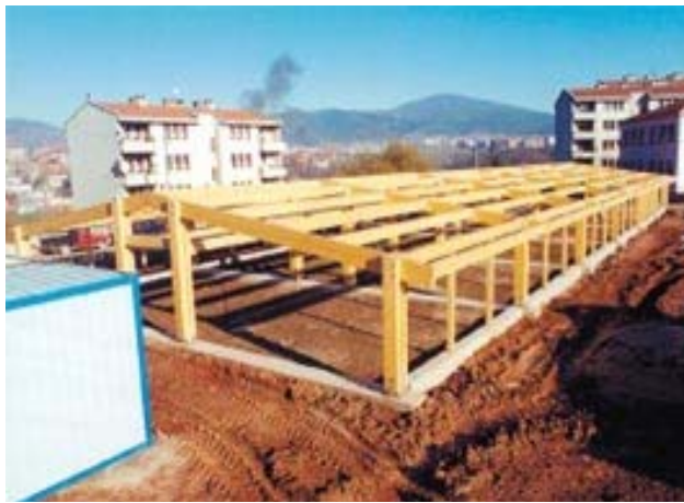
Resim 4.10: Marmara Bölgesi Taşınabilir Deprem Okulları(1999)
