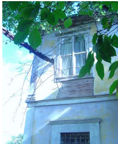
Resim 3.13: Yatay çıtalarla güçlendirilmiş ahşap yapı, Giresun.
