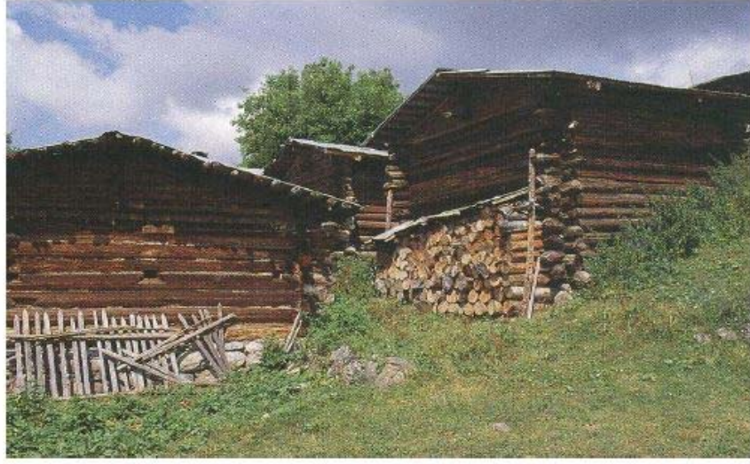
Resim 3.28: Kaba boşluklu kütük yığma yapı örneği, Şavşat / Artvin
