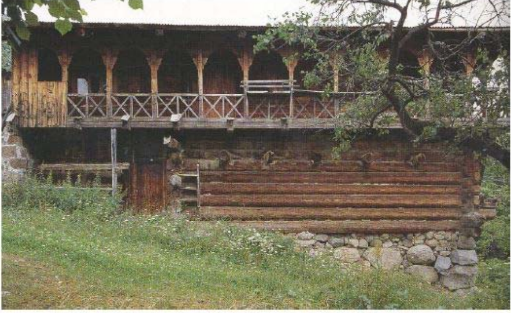
Resim 3.1: Ahşap yapıların zeminle ilişkisini kesen taşlar, Şavşat / Artvin
