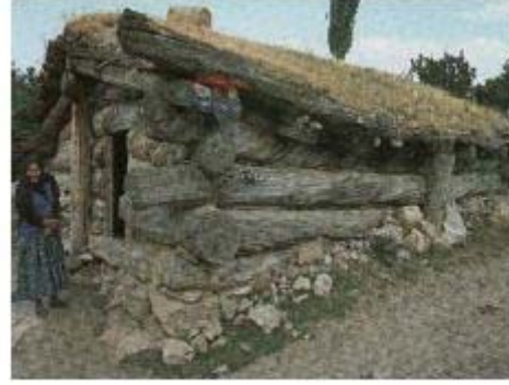
Resim 3.4(üstte): Yığma şeklinde kullanılmış ahşap malzeme ve dolgulu ev Cumalıkızık/ Bursa
