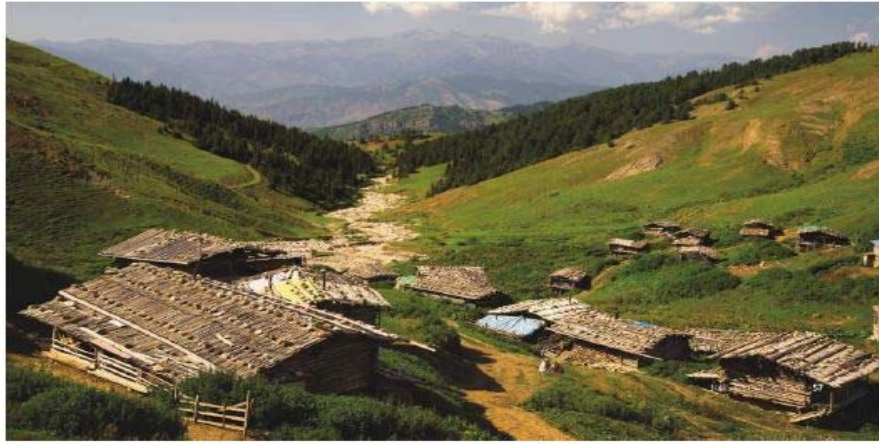
Resim 3.9: Çatısı yarma ahşapla(Hartama) kaplanmış yayla evleri. Ahşaplar üst üste bindirilerek kaplanır ve rüzgâr etkisinden korunmak için üzerine sırayla taş konur. Ardanuç/Artvin
