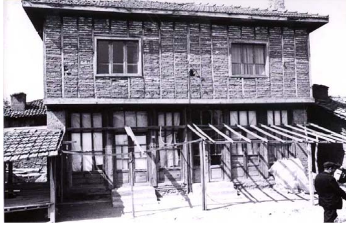
Resim 3.11: Taşıyıcı sisteminde payanda bulunmayan yapı, Kuzey Anadolu
