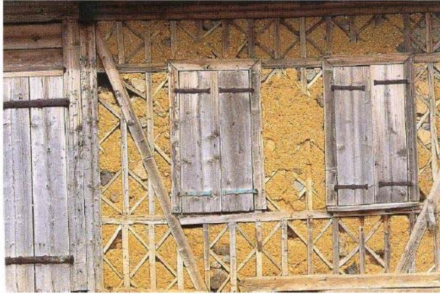
Resim 3.39: Muska dolgulu sistemde kerpiç sıvanın uygulandığı bir örnek.
