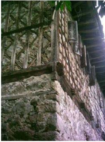
Resim 3.36: Muskalı dolma sistem sıvasız örnek Resim 3.37: Muskalı dolma sistem konut cephesi
