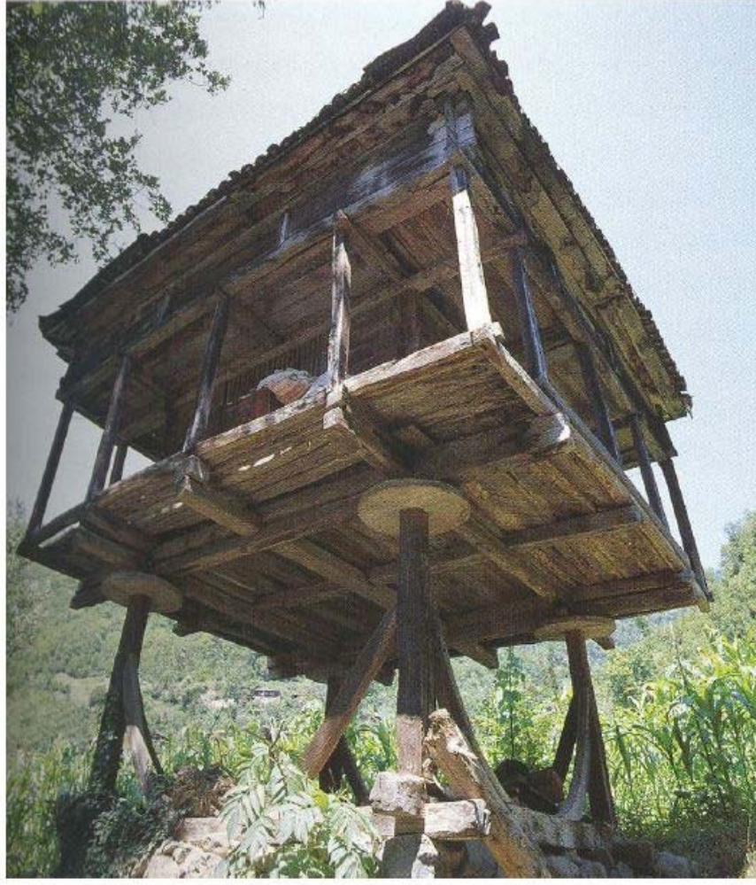
Resim 3.33: Basit ahşap iskelet sistemle yapılmış bir serander örneği.
