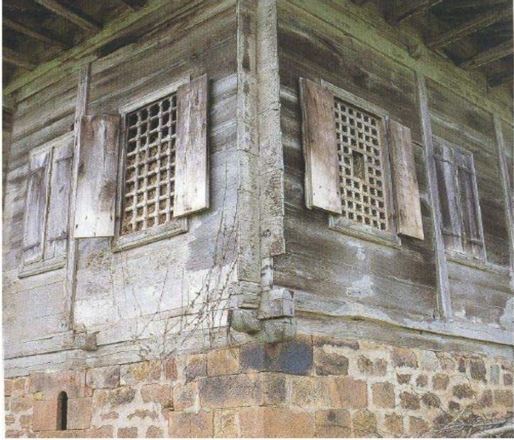
Resim 3.29: Taş duvar üzerine oturan yontulmuş kütük yığma, Çamlıhemşin/ Rize.
