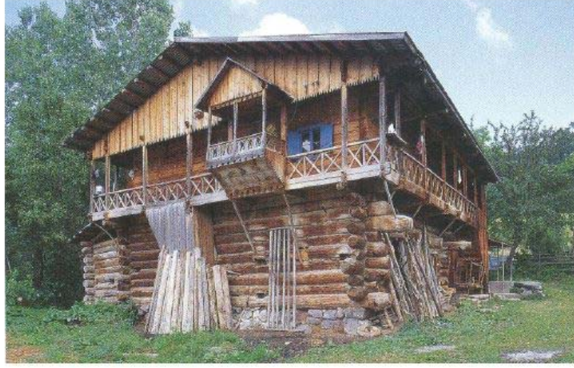
Resim 3.8: Doğu Karadeniz bölgesinde iklim özellikleri ve ormanların sıklığı yapım tekniğini ve malzemesini belirlemiştir.
