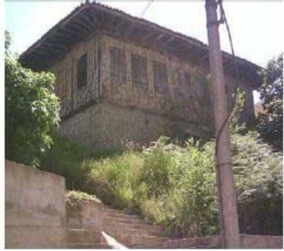
Resim 3.36: Muskalı dolma sistem sıvasız örnek Resim 3.37: Muskalı dolma sistem konut cephesi
