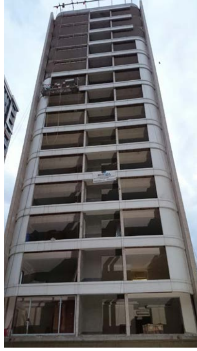
Şekil 4.5.: Erer Yapı-Ev64, şantiyede montaj devam ederken cephe görünüşü (özgün arşivinden, 2015)
