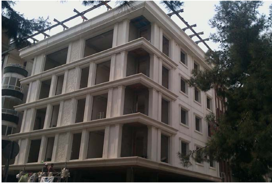
Şekil 4.12.: Paşa Otomotiv-Konut, montaj sonrası cephe görünüşü (özgün arşivinden, 2015)
