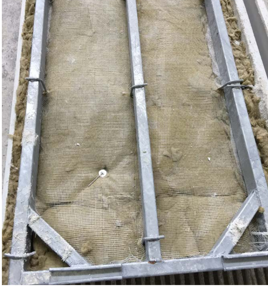
Şekil 3.19.: File üstü son katmanı dökmeden önce, taşıyıcı ve file uygulamasından sonra GRC (özgün arşivinden, 2016)
