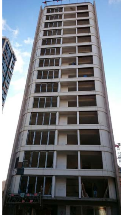
Şekil 4.6: Erer Yapı-Ev64, montaj sonrası renk numune çalışması cephe görünüşü (özgün arşivinden, 2015)
