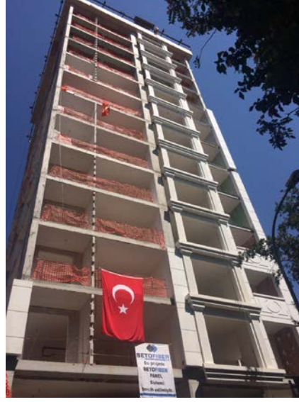
Şekil 4.17.: Göktuğ İnşaat-Merih Apartmanı, montaj devam ederken ön cephe görünüşü (özgün arşivinden, 2015)
