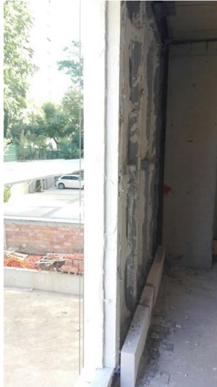
Şekil 4.18.: Göktuğ İnşaat-Merih Apartmanı, montaj sonrası dış duvarlar örülürken (özgün arşivinden, 2015)
