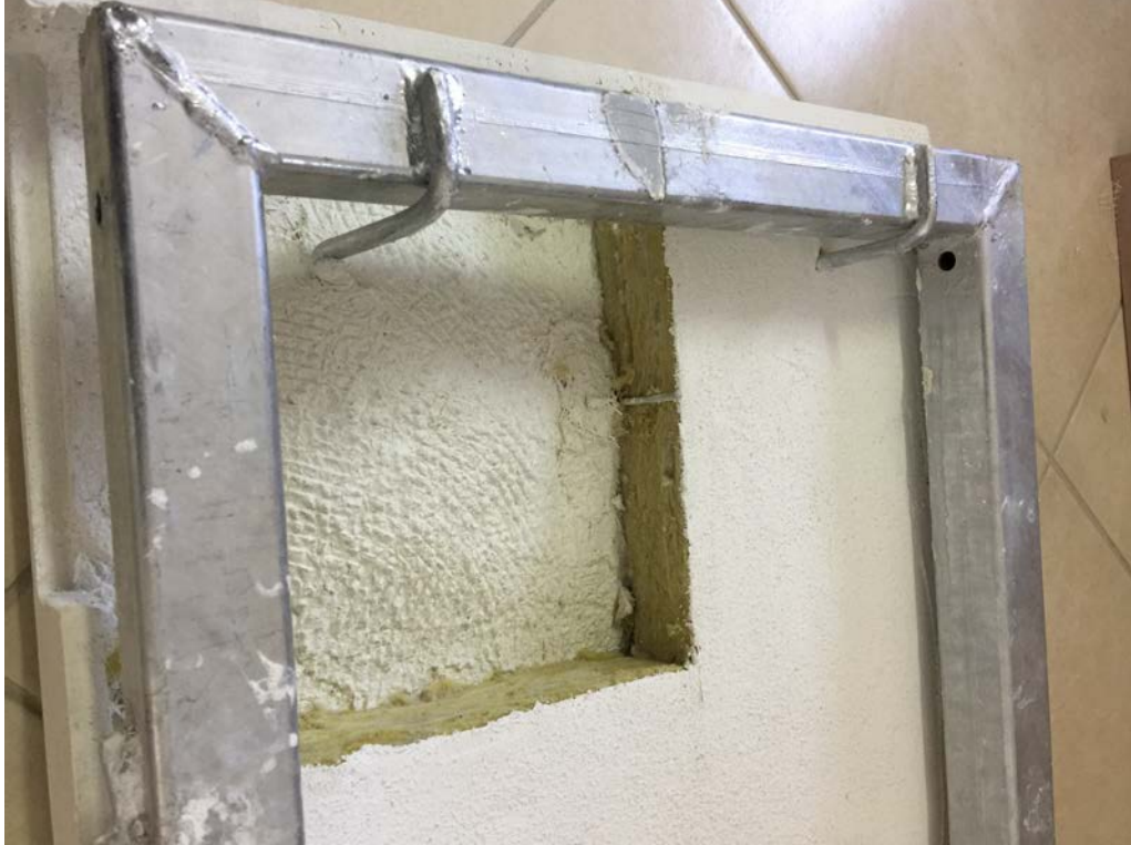
Şekil 3.18.: İzolasyonlu panel kesiti (özgün arşivinden, 2016)
