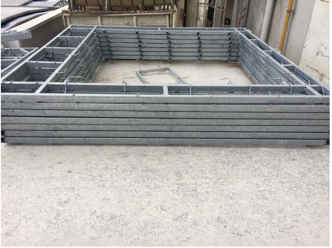
Şekil 3.14.:Döküm için hazırlanmış olan karkaslar (özgün arşivinden, 2016)
