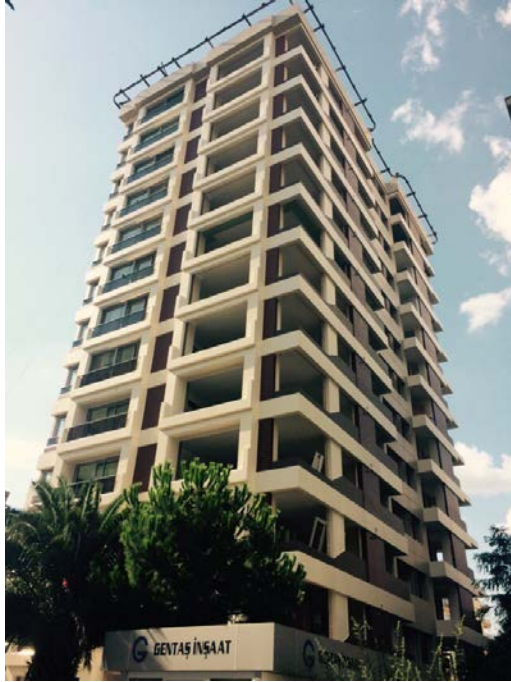
Şekil 2.1.:Gentaş İnşaat Caddebostan Konut (özgün arşivinden, 2014)
