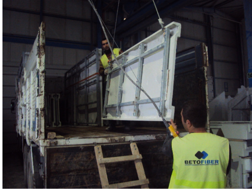
Şekil 3.27.: GRC elemanların nakliye aracına yüklenmesi (özgün arşivinden, 2013)
