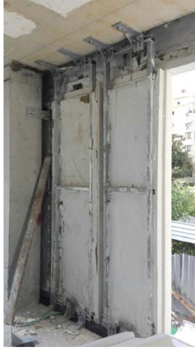
Şekil 4.16.: Göktuğ İnşaat-Merih Apartmanı, açık cephe montaj görünüşü (özgün arşivinden, 2015)
