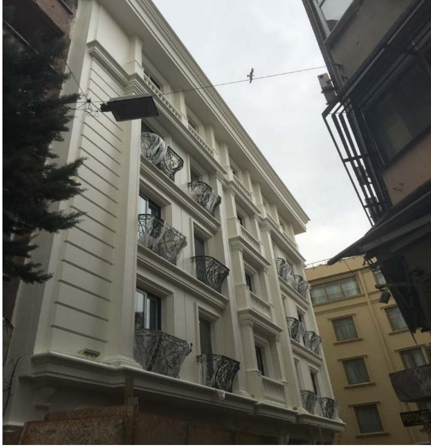
Şekil 4.10.: Cabana Mimarlık-Anthemis Otel, montaj sonrası cephe görünüşü (özgün arşivinden, 2015)
