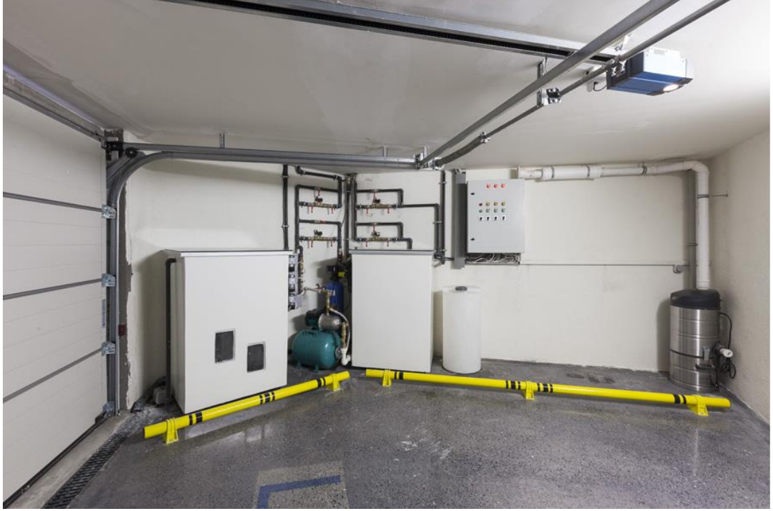
Şekil 4.16. Erke Green Academy, Havalandırma ve İklimlendirme Üniteleri (URL-16)
