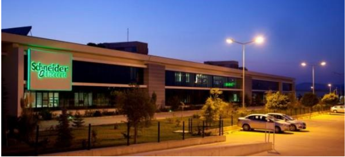
Şekil 4.23. Schneider Electric, Manisa Fabrikası (URL-22)
