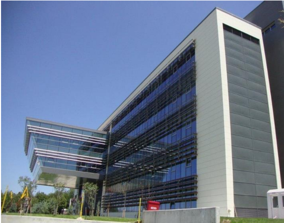
Şekil 4.6. Prokon-Ekon Merkez Binası Güney Cephesi Şeffaf PV Panelleri (URL-11)
