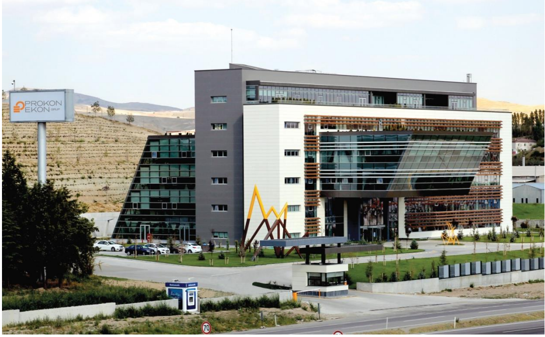
Şekil 4.5. Prokon-Ekon Şirketler Grubu Merkez Binası (URL-11)
