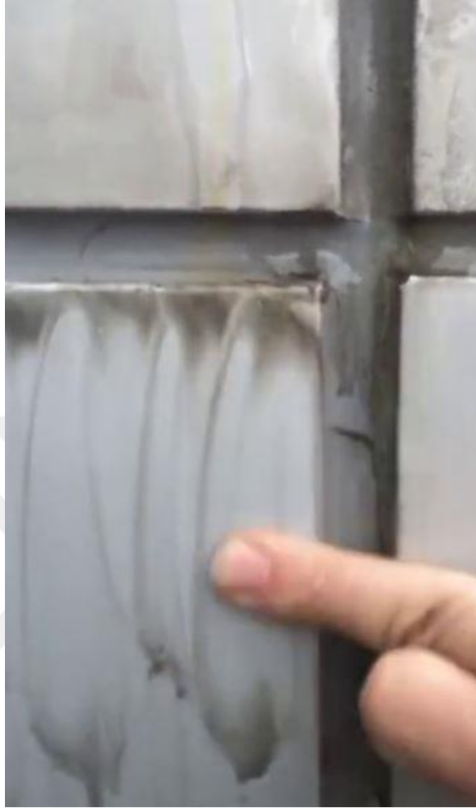
Resim3.5:AluminyumKompozitYüzeydekiLeke Belirtileri(URL 24)
