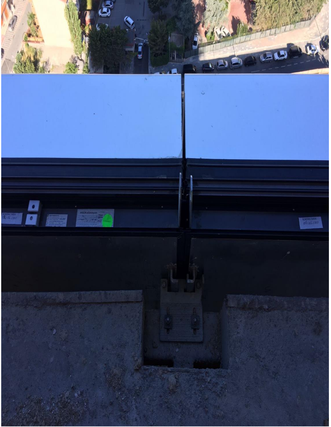
Resim 4.41:Emaar Address Cephe alüminyum birleşim uygulama
