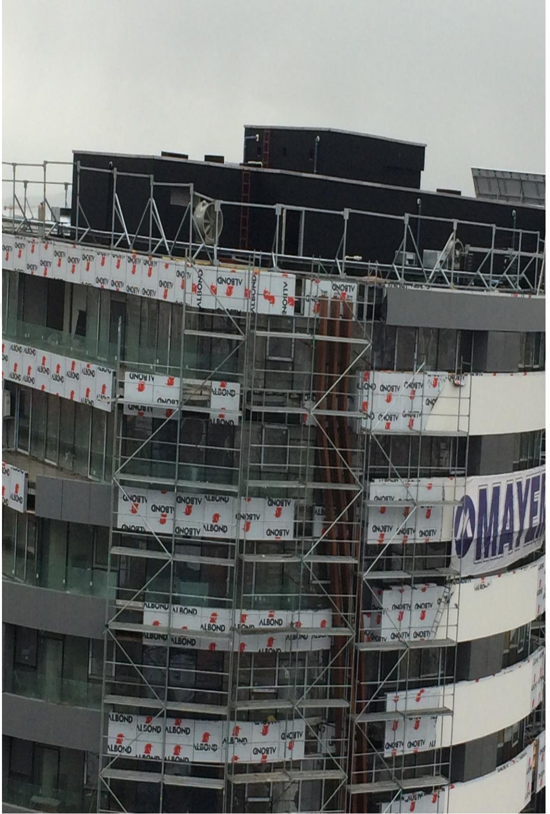
Resim 4.36:Kent Plus Cephe kompozit levha uygulama 3
