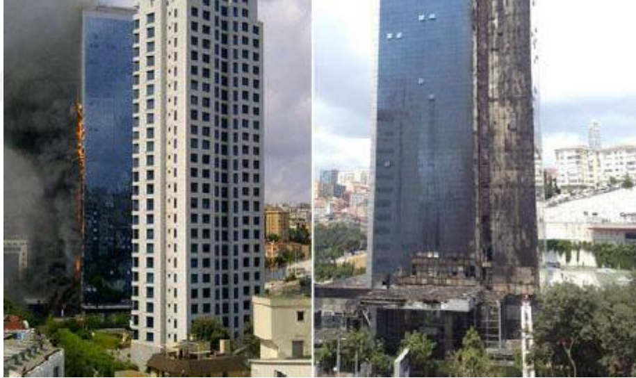
Resim 3.2:Polat Tower Cephe Yangını(URL 17)
