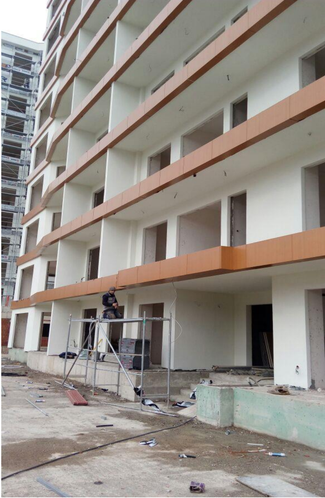
Resim 4.50: Gate of Anatolia alüminyum kompozit levha uygulama 1
