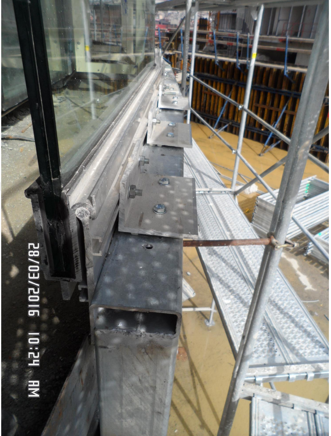
Resim 4.31: Kent Plus Cam korkuluk uygulama 2
