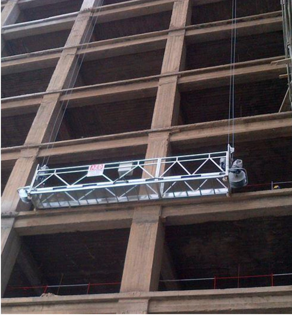
Resim 2.1:Cam malzeme montajı için yatayda ve düşeyde hareket edebilen asma iskele(URL 7)
