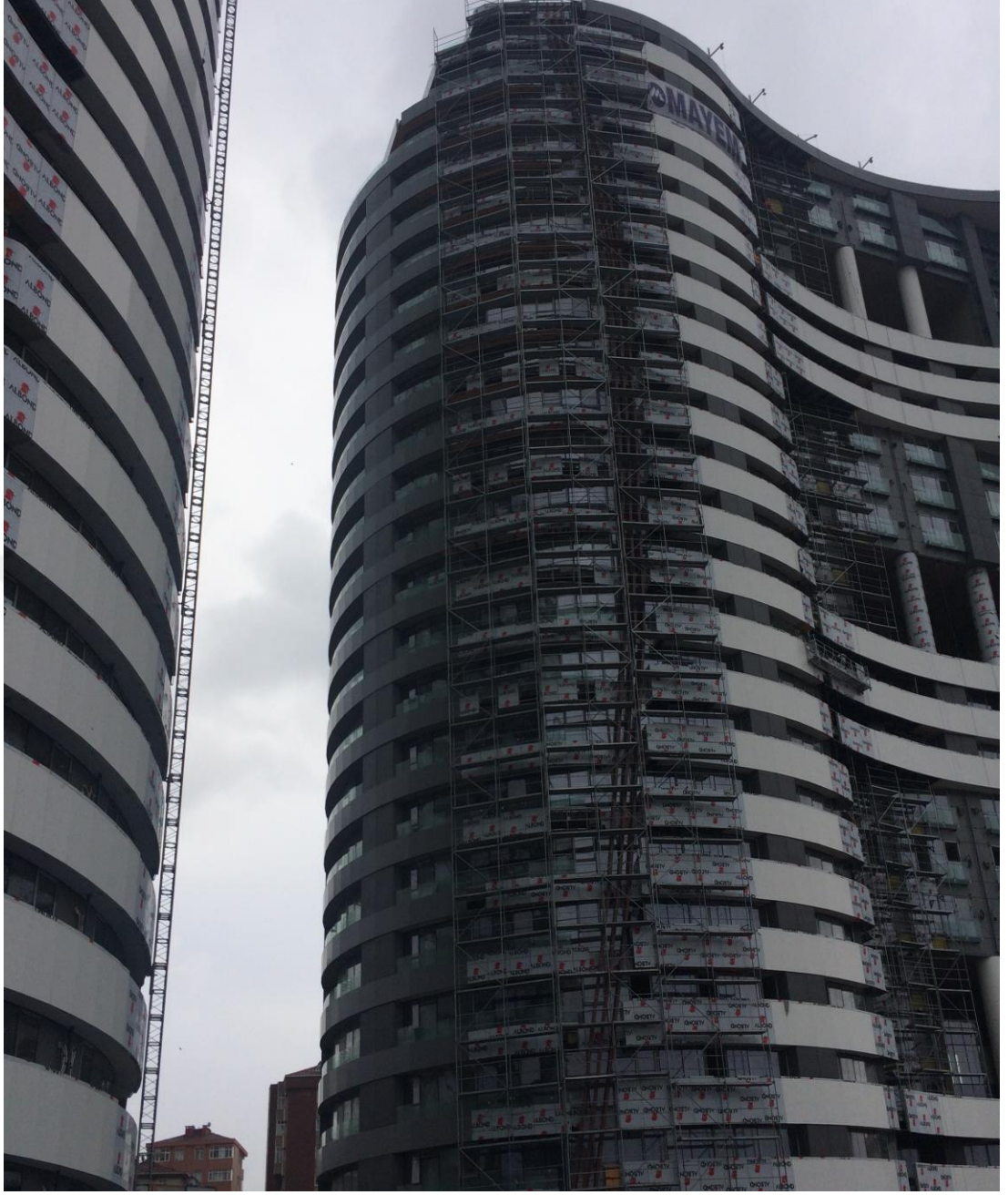
Resim 4.34:Kent Plus Cephe Kompozit levha uygulama 1
