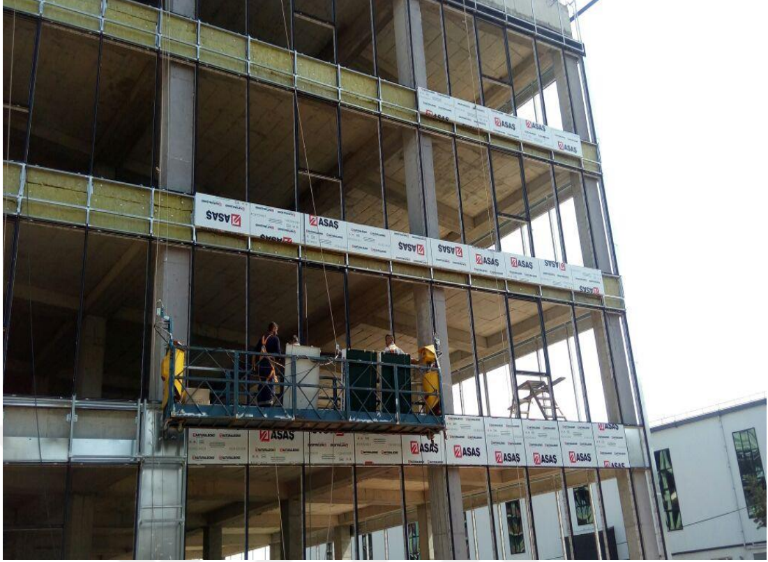
Resim 4.51: Gate of Anatolia alüminyum kompozit levha uygulama 2
