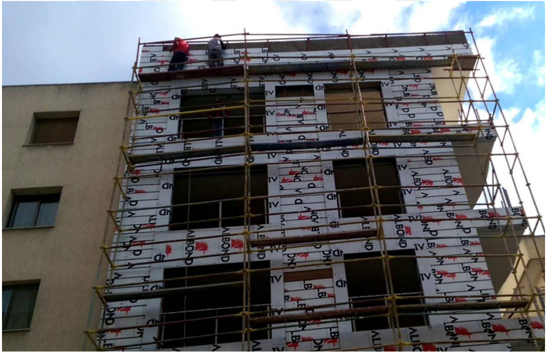
Resim3.8:Cepheye Aluminyum Kompozit Montajı(URL 30)
