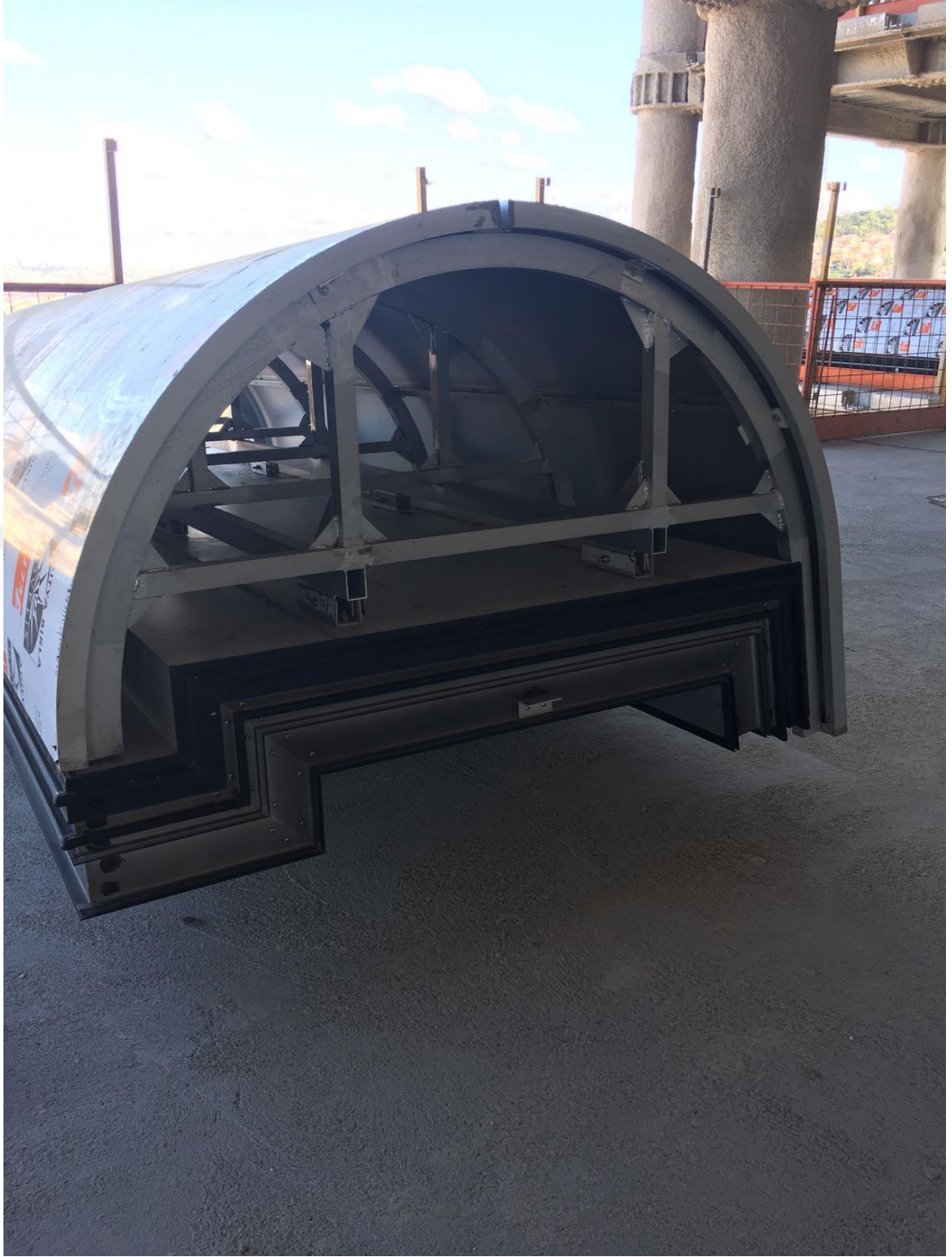
Resim 4.37:Emaar Address Köşe profil montaja hazır
