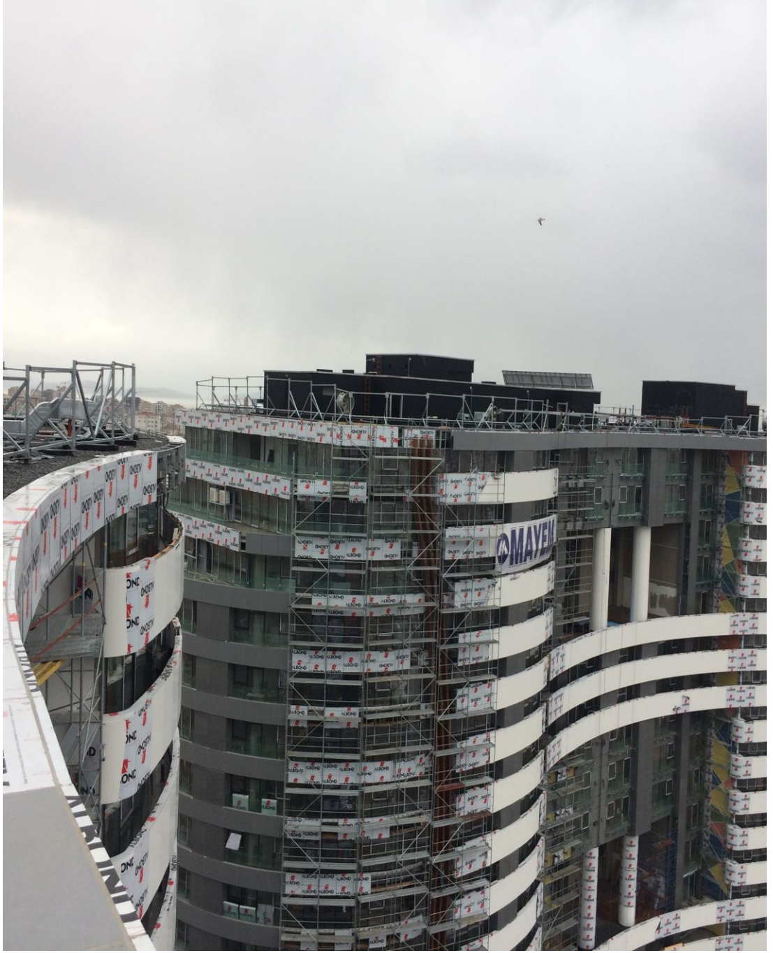
Resim 4.35:Kent Plus Cephe kompozit levha uygulama 2
