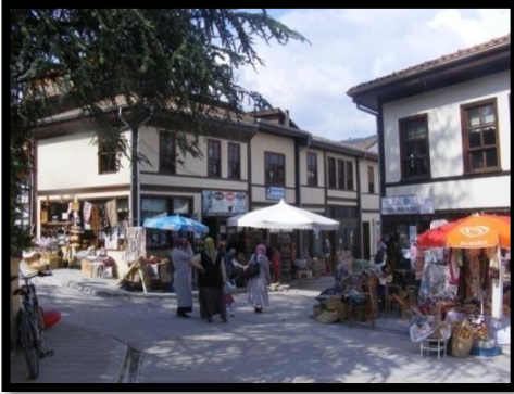
Resim 5.5. Yunuspaşa Çarşısının Restorasyon Sonrası Görünümü
