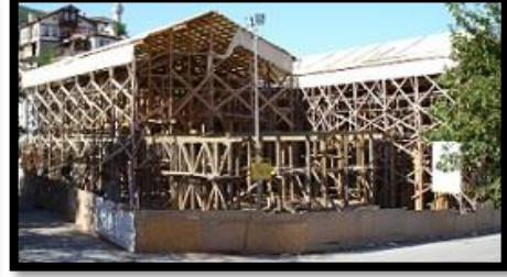
Resim 5.42. Hacı Atf Hanı Restorasyon Aşamasındaki Hali
