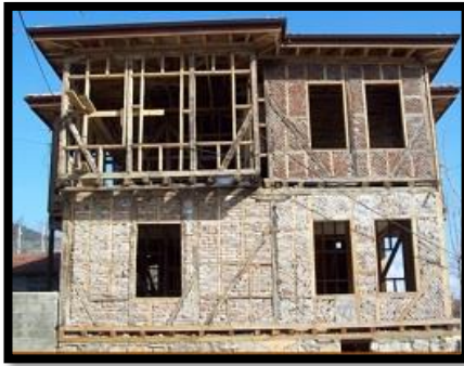
Resim 5.12. Hanımeli Konağının Restorasyondan İşlemindeki Durumu
