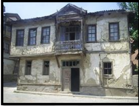
Resim 5.19. Abdi İbrahim Konağının Restorasyondan Önceki Durumu
