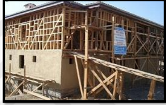
Resim 5.15. Hacırifatlar Konağının Restorasyon İşlemindeki Durumu
