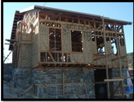
Resim 5. 32. Hisar Konađı Restorasyon Ařamasındaki Hali
