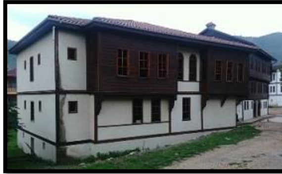
Resim 5.16. Hacırifatlar Konağının Restorasyondan Sonraki Hali
