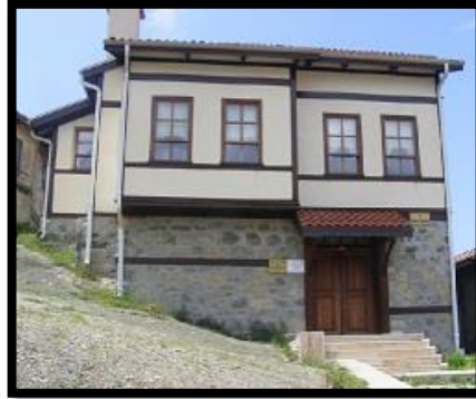
Resim 5.33. Hisar Konađı Restorasyon Sonrasındaki Hali
