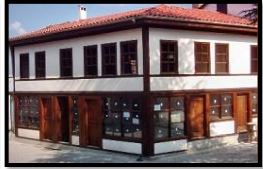
Resim 5.40. Küçükhan Restorasyondan Sonraki Görünüşü
