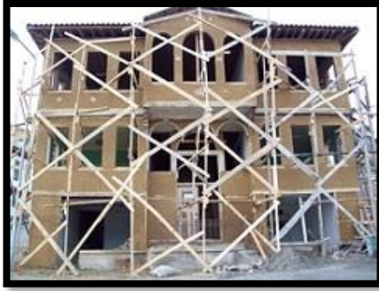
Resim 5.24. Kadirler Konağının Restorasyondan Aşamasındaki Hali
