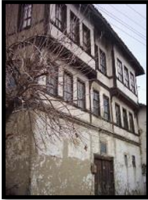
Resim 5.45. Ayşe Tekin Konağı Restorasyondan Önceki Hali
