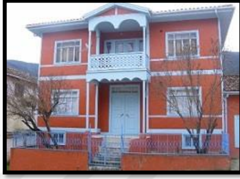
Resim 5.27. Kadirler Konağının Restorasyon Sonrasındaki Hali
