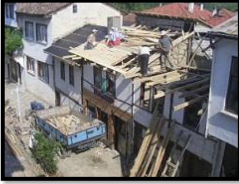
Resim 5.3. Çarşının Çatı Kaplamasının Yenilenmesi
