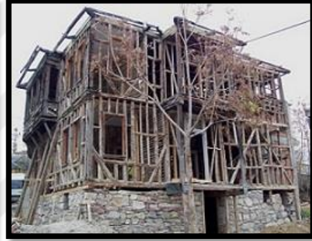
Resim 5.11. Hanımeli Konağının Restorasyon İşlemlerindeki Durumu
