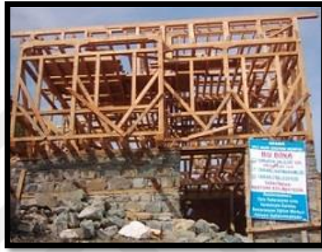
Resim 5.31. Hisar Konađı Restorasyon Ařamasındaki Hali
