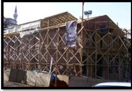
Resim 5.43. Hacı Atf Hanı Restorasyon Aşamasındaki Hali
