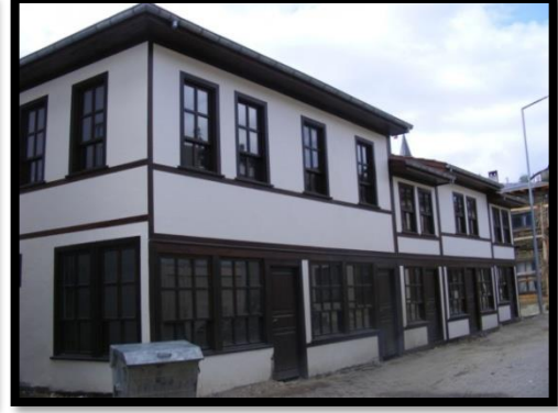
Resim 5.2. Yunuspaşa Çarşısının Restorasyon Sonrası Görünümü
