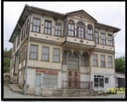
Resim 5.22. Kadirler Konağının Restorasyondan Önceki Durumu
