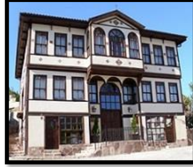
Resim 5.25. Kadirler Konağının Restorasyon Sonrasındaki Hali
