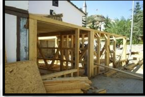
Resim 5.38. Rüştüye Mektebi Restorasyon Aşamasındaki Hali
