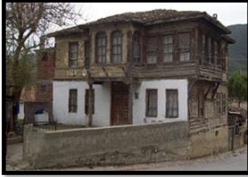
Resim 5.10. Hanımeli Konağının Restorasyondan Önceki hali
