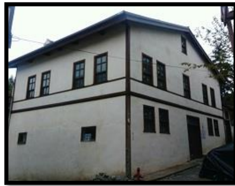
Resim 5.29. Mehmet Büyüközer Evi Restorasyon Sonrasındaki Hali
