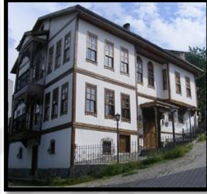
Resim 5.18. Çakırlar Konağının Restorasyon Sonraki Durumu
