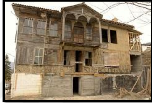
Resim 5.23. Kadirler Konağının Restorasyon Aşamasındaki Hali
