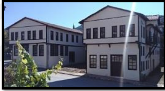
Resim 5.44. Hacı Atf Hanı Restorasyondan Sonraki Hali
