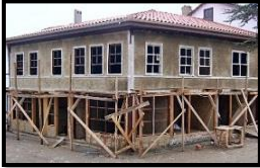
Resim 5.39. Küçükhan Restorasyon Aşamasındaki Hali
