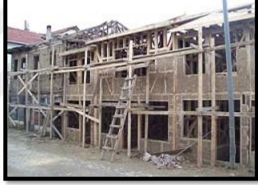
Resim 5.4. Çarşıdaki dükkanları Kerpiç Dolgu İşleminin Yapılması
