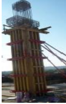
Şekil 2.7. İnşaata Beton Kalıbı Örneği
