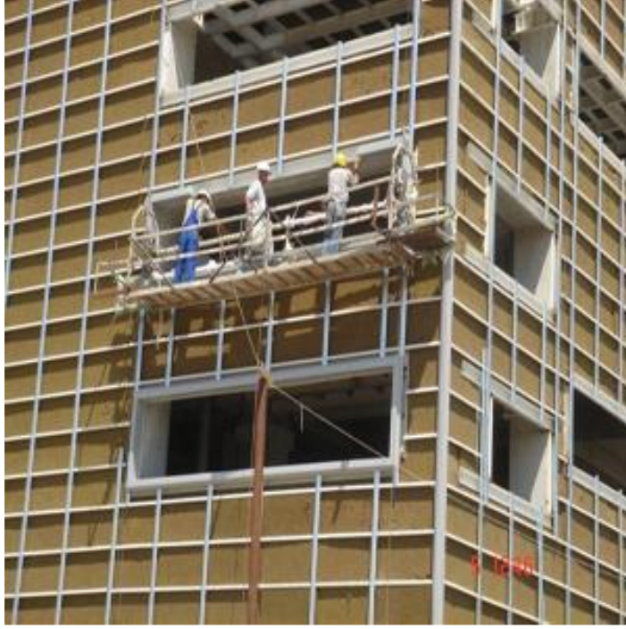
Şekil 3.42. Polyplex Folyo Fabrikası / Çorlu
