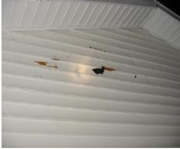
Őekil 3.28. Darbeyle birlikte Zarar Gören Plastik Kompozit Kaplama Örneđi Kaynak: Özmeral, 2006: 83.
