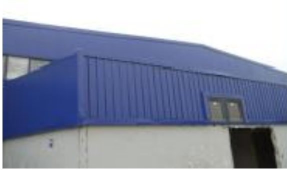
Şekil 2.18. Dış Cephe Kaplamalarında Kullanılan Tabakalı Kompozitler Kaynak: Zor, 2016: 27.
