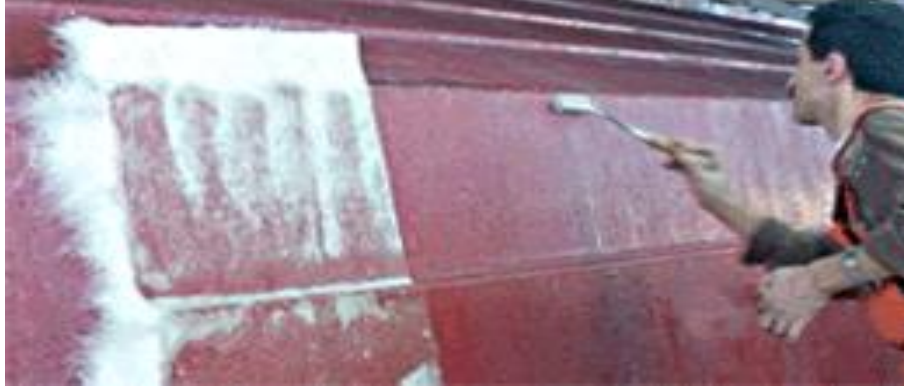
Şekil 3.2. El Yatırma Yöntemiyle Yapılan Dış Cephe Kaplama Örneği
