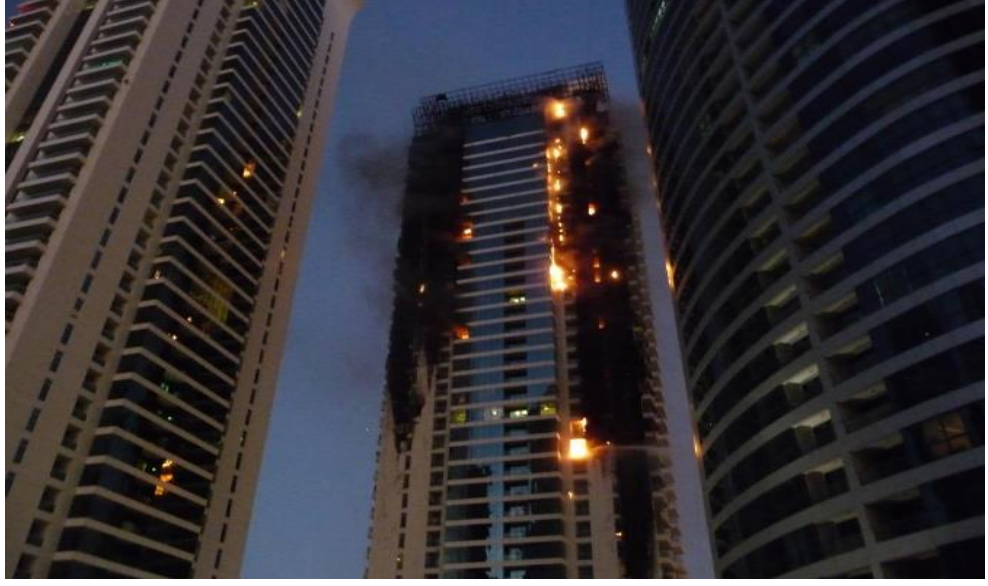
Şekil 3.41. Dubai Tamweel Tower Cephe Yangını Örneği
