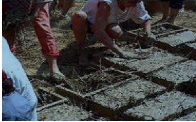
Şekil 2.4. Kerpicing Yapılışı
