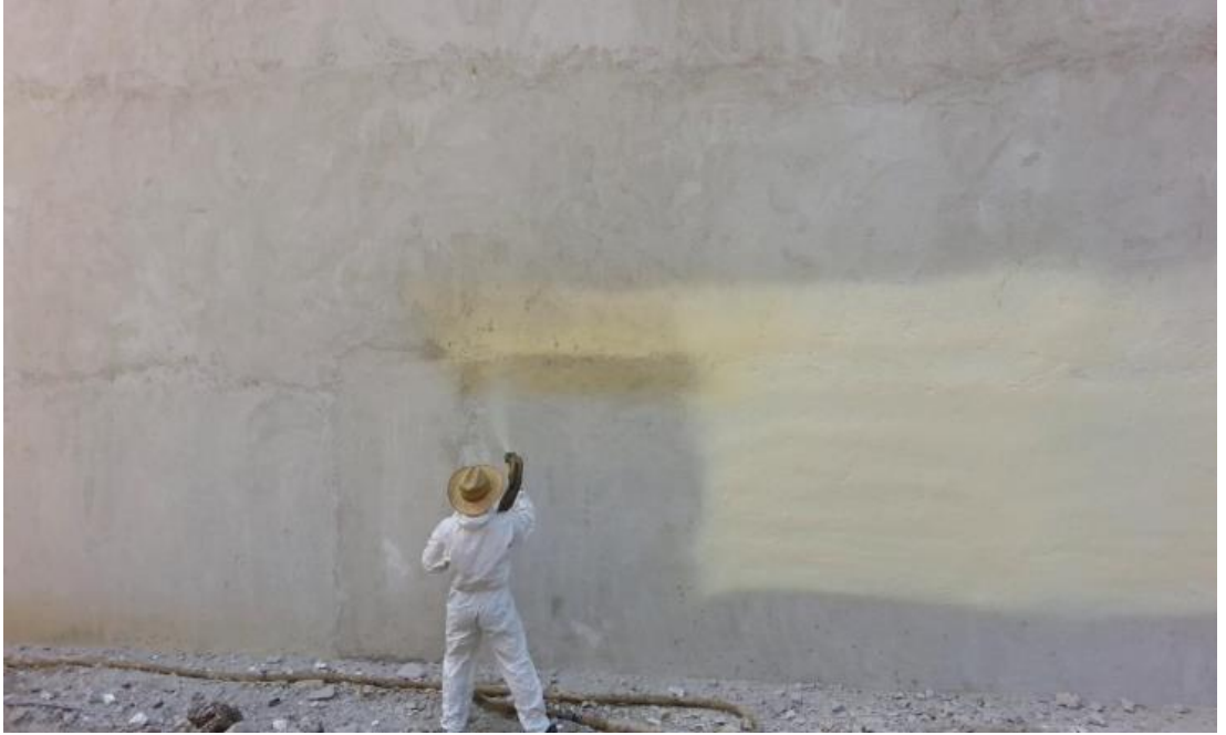
Şekil 3.4. Püskürtme Yöntemiyle Dış Cephe Kaplama Örneği
