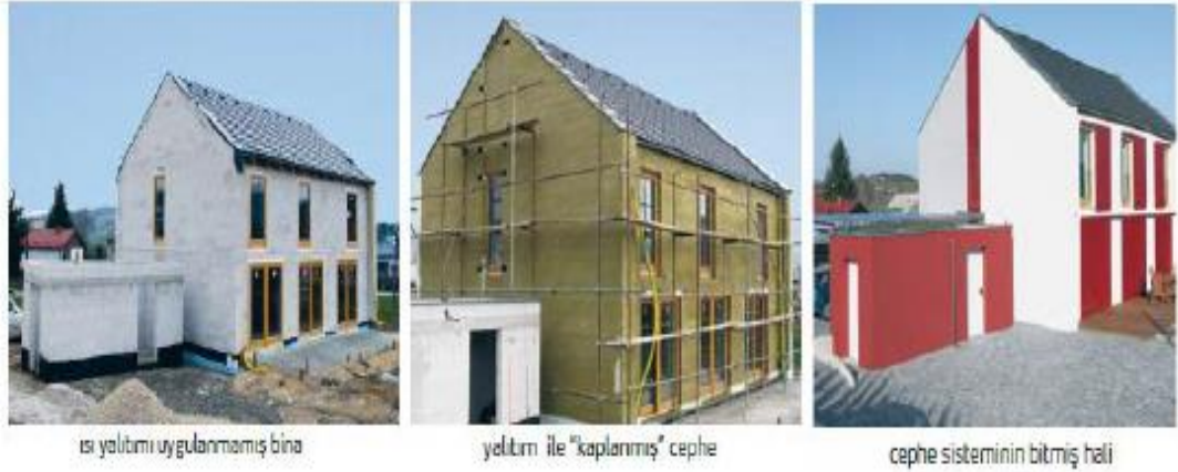
Şekil 3.22. ETICS uygulama örnekleri
