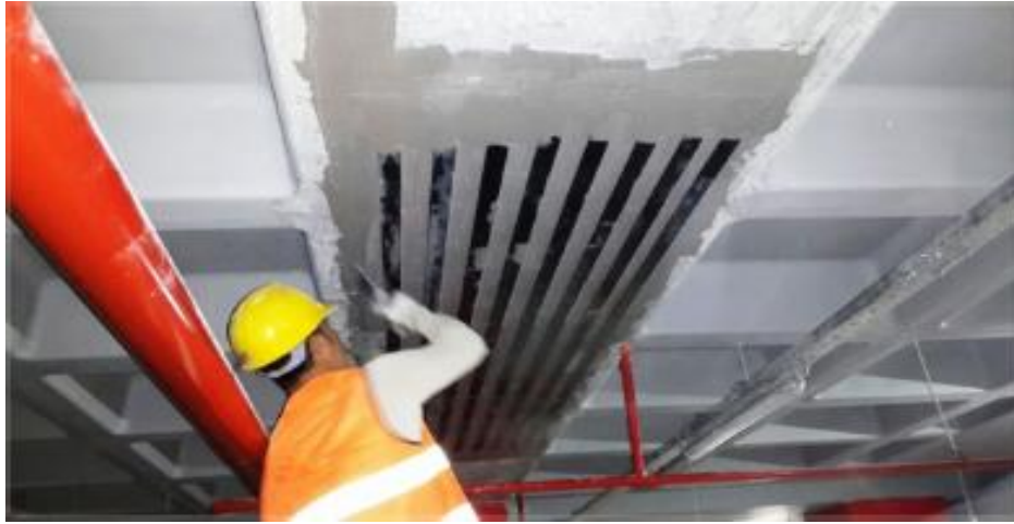
Şekil 2.39. Hasar Gören Yapılarda Lifli Polimer Güçlendirme
