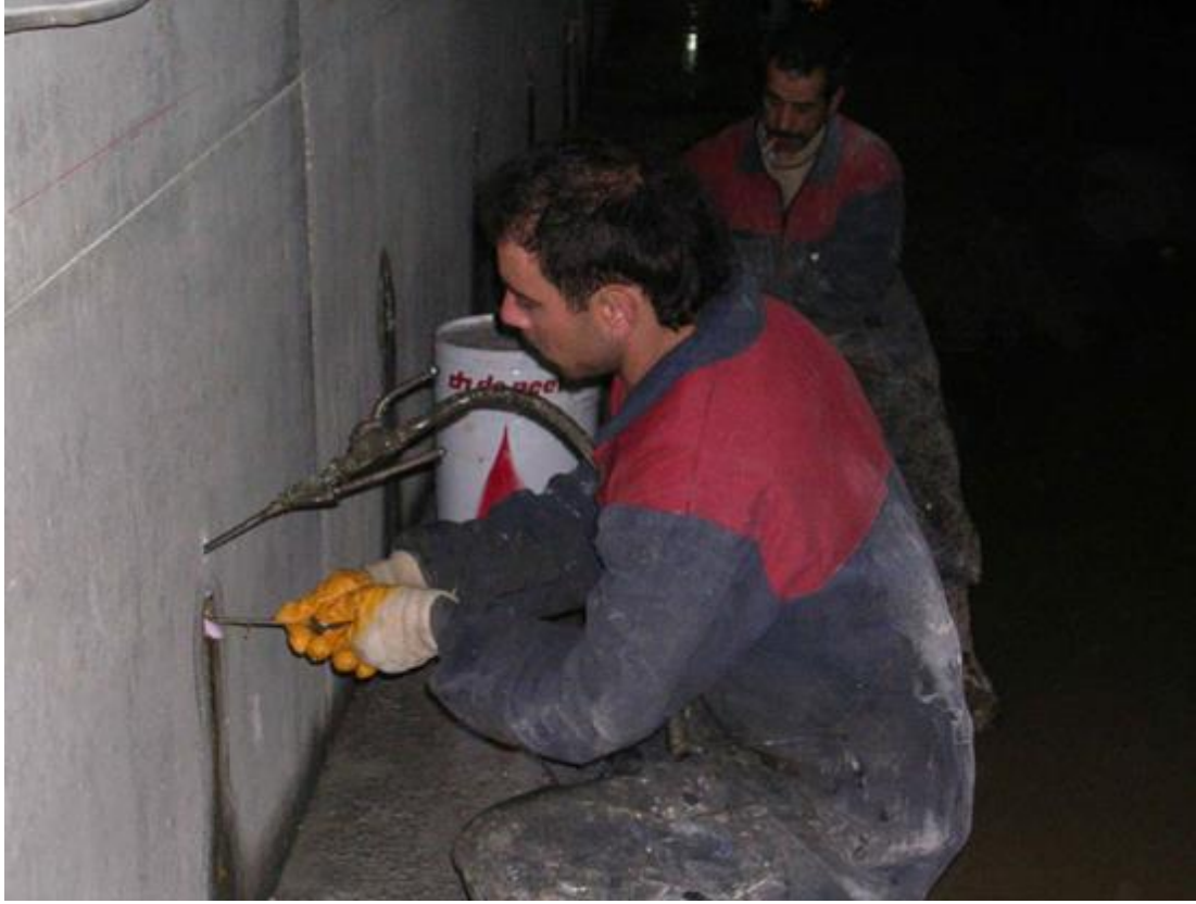
Şekil 3.6. Reçine Enjeksiyonu Yöntemi Örneği
