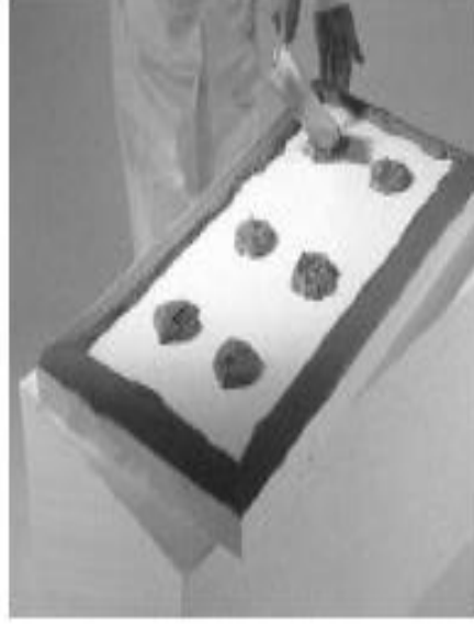
Şekil 3.25. Kompozit Dış Cephe Kaplamalarında Yapıştırma Harcı Kaynak: Özgüven, 2015: 18
