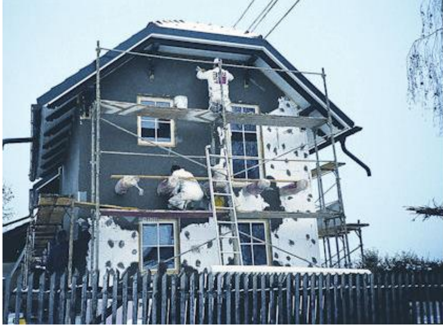
Şekil 2.9. Isı Yalıtımı İçin Dış Kaplama Örneği
