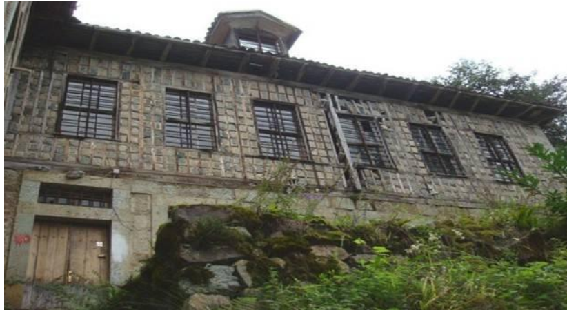
Şekil 3. 6. Doğu Karadeniz Mimarisinde Çıkmasız Cephe Örneği
