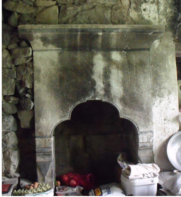
Şekil 4. 7. Doğal Taş Bloktan oluşturulmuş Şömine Memiş Paşa konağı, Ortaklar (Başköy) Köyü, Çamlıhemşin
