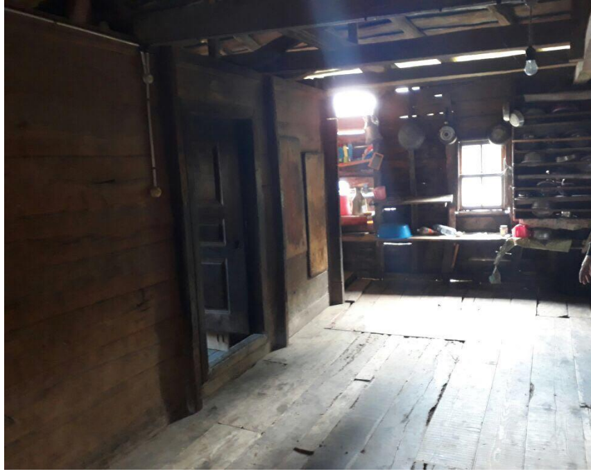
Şekil 5. 5. Doğu Karadeniz Evlerinde Ahşabın Zaman İçerisindeki “ Deformasyonu ve Mekân İçerisindeki Isı Kaybını Oluşturan Yüzeyler ”
