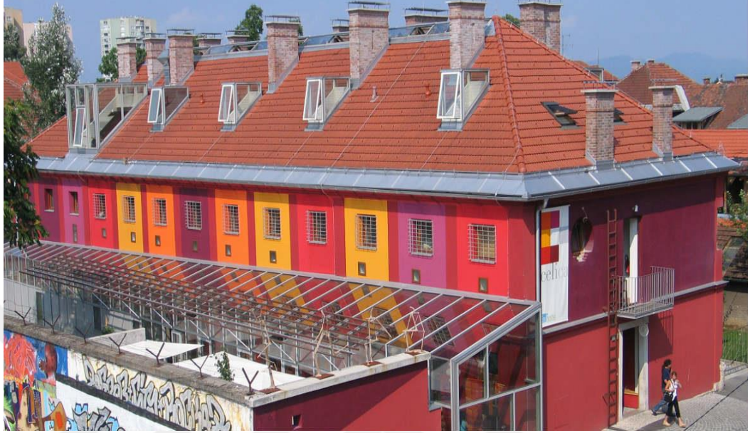
Şekil 3.3.2. Hotel Celica Dış Cephe
