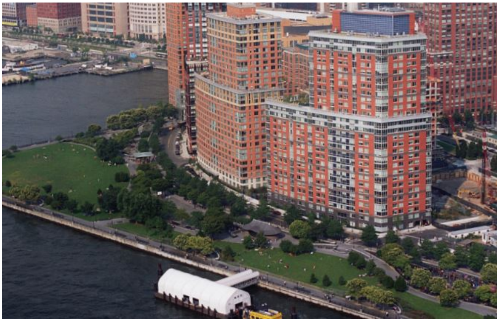
Şekil 7.2: Solaire Rezidans (hpbmagazine.org)
