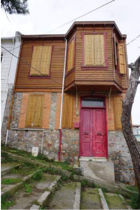
Şekil – 4.6 79 Ada 9 Parsel (Tek Cumbalı Cephe) (Bkn. Env. No:0316)
