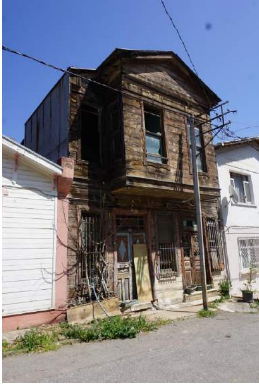
Şekil – 4.2 73 Ada 3 Parsel (Ahşap Karkas) (Bkn. Env. No:0280)
