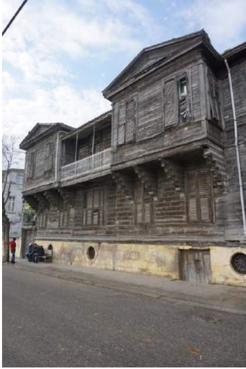
Şekil – 4.7 63 Ada 5 Parsel (Çift Cumbalı Cephe) (Bkn. Env. No:0227)
