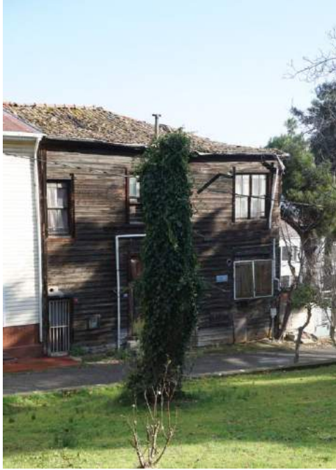
Şekil – 4.12 7 Ada 1 Parsel (Alaturka Kiremit) (Bkn. Env. No:0001)
