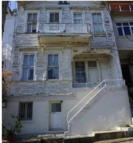
Şekil – 4.1 10 Ada 17 Parsel (Kagir+Ahşap) (Bkn. Env. No:0028)
