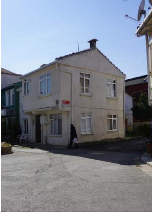
Şekil – 4.4 55 Ada 17 Parsel (Betonarme)(Bkn. Env. No:0199)
