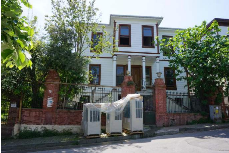
Şekil 3.14Heybeliada Eski İlkokul Binası, Heybeliada Kütüphanesi (Çelik Bay, 2017)
