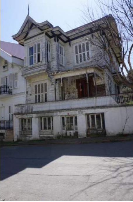
Şekil – 4.9 73 Ada 6 Parsel (Kırma Çatı) (Bkn. Env. No:0282)
