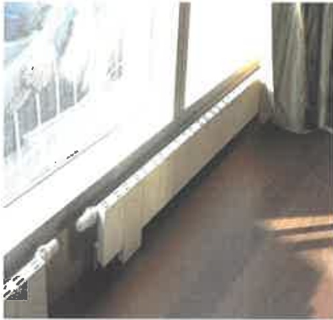
Şekil 4.24. Cephe Önlü Radyatör
