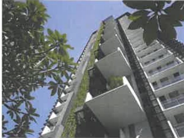
Şekil 3.16. Singapur Newton Konutları Cephesi (URL-53)
