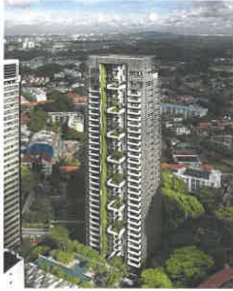
Şekil 3.15. Singapur Newton Konutları Cephesi (URL-52)
