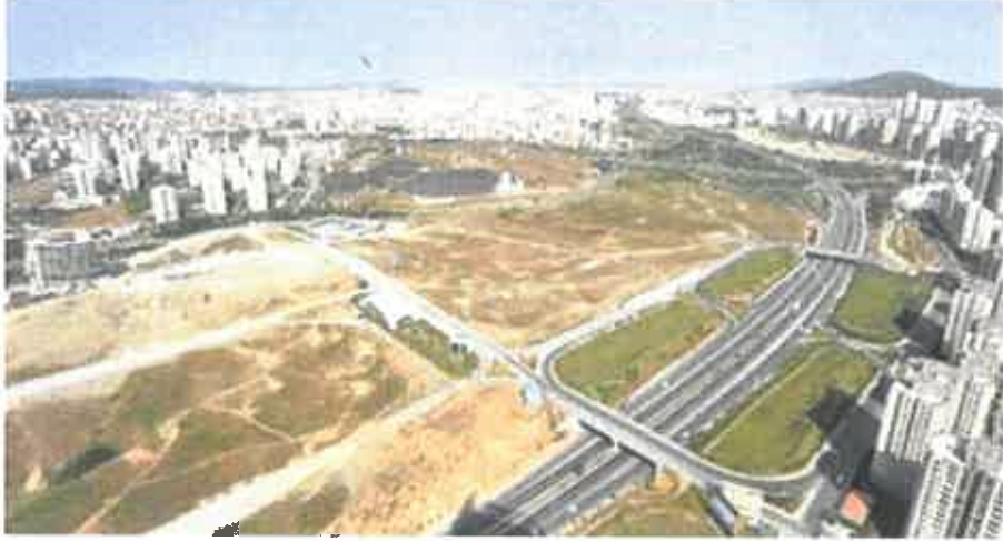
Şekil 4.5. Varyap Meridian İnşaat Alanı (URL- 62)
