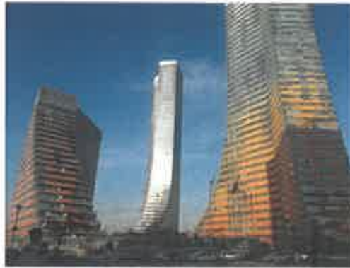
Şekil 4.1. Varyap Meridian Cephe Görünümü (URL-57)
