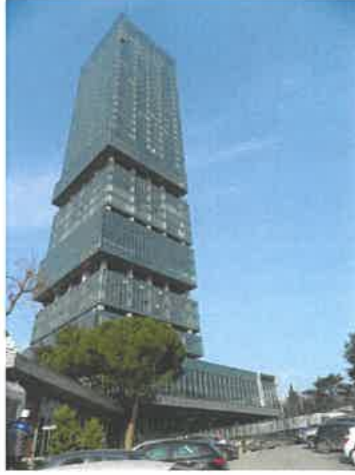
Şekil 3.10. İstanbloom Cephe Görünümü (URL-44)
