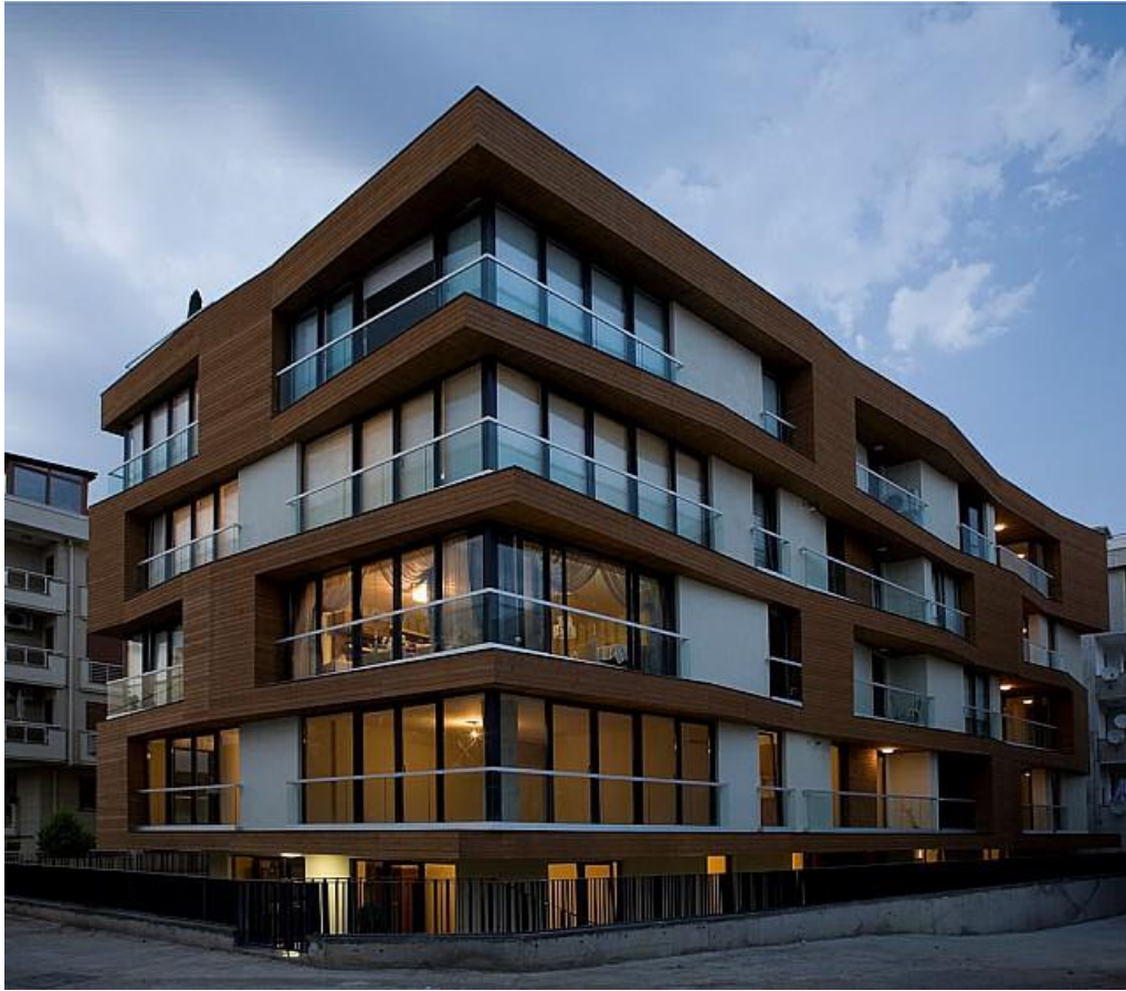
Resim 2.7. Günümüz Apartman Örneği
