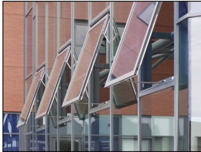
Şekil 4.26. Doğal havalandırmada kullanılan mekanik pencere örneği (URL-38)
