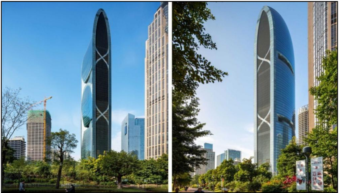
Şekil 4.78. Pearl River Tower Sağ ve Sol Yan Cepheleri (URL-103)
