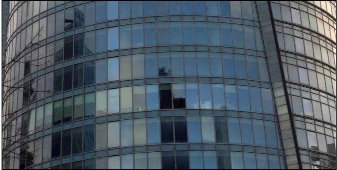
Şekil 4.97. Spine Tower Panel Cephe Sistemi (Taraftmdan Çekilmiştir)
