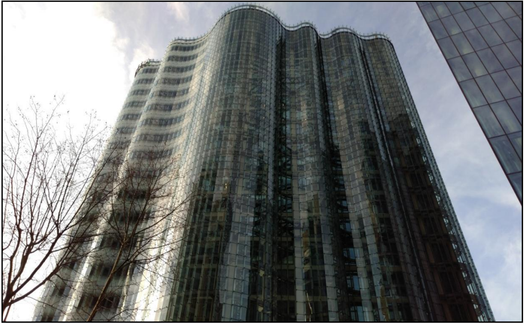
Şekil 4.85. Maslak no/1 Özel Performans Cam Giydirme Cephe (Taraftmdan Çekilmiştir)
