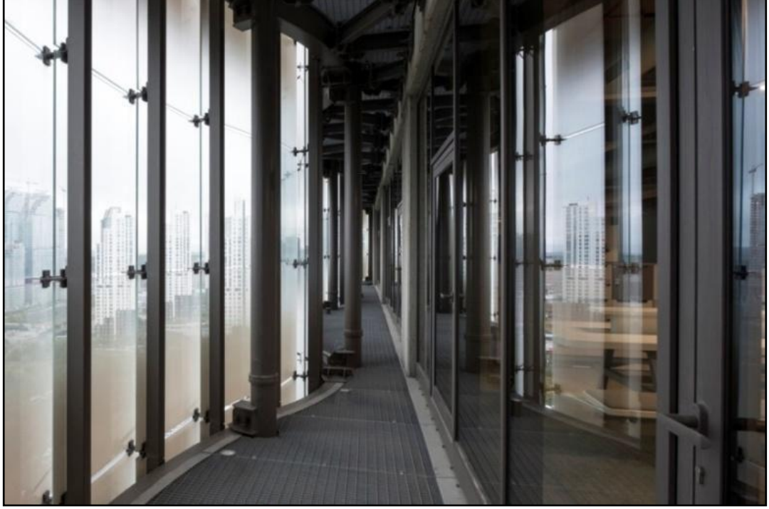
Şekil 4.67. Maslak No1 Binası Yürüme Yolu (URL-74)
