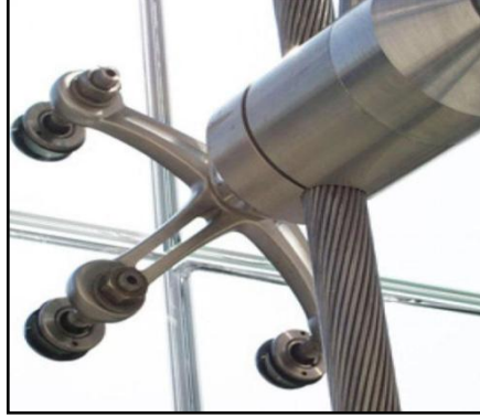
Şekil 4.60. Spider Cam Tutucu (URL-68)
