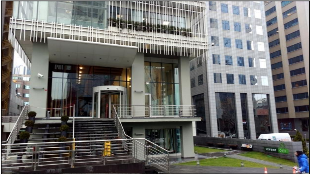
Şekil 4.87. Levent Ofis Bina Girişi (Taraftmdan Çekilmiştir)
