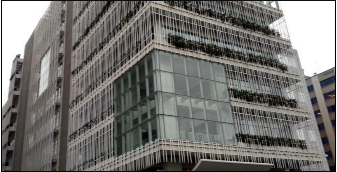
Şekil 4.90. Levent Ofis Binası Cephesi (Taraftan Çekilmiştir)
