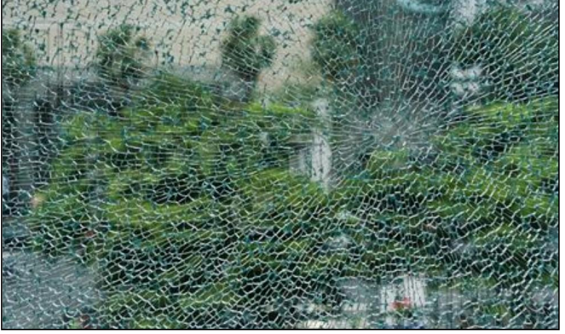
Şekil 4.43. Temperlenmiş Camın Darbe Aldıktan Sonraki Hali (URL-51)
