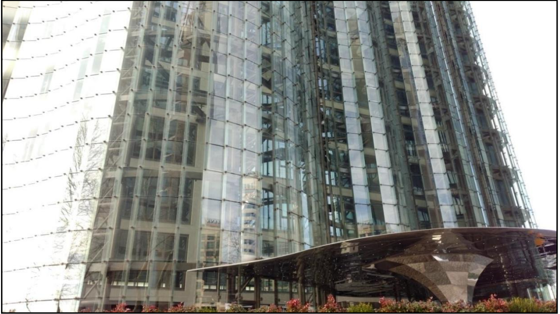
Şekil 4.80. Maslak No/1 Giriş Saçağı ve Ön Cephesi (Taraftan Çekilmiştir)
