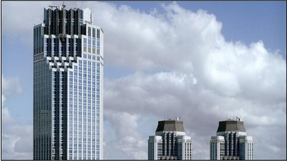
Şekil 4.4. Panel Sistem Örneği - İş Bankası Genel Müdürlük Binası (URL-24)
