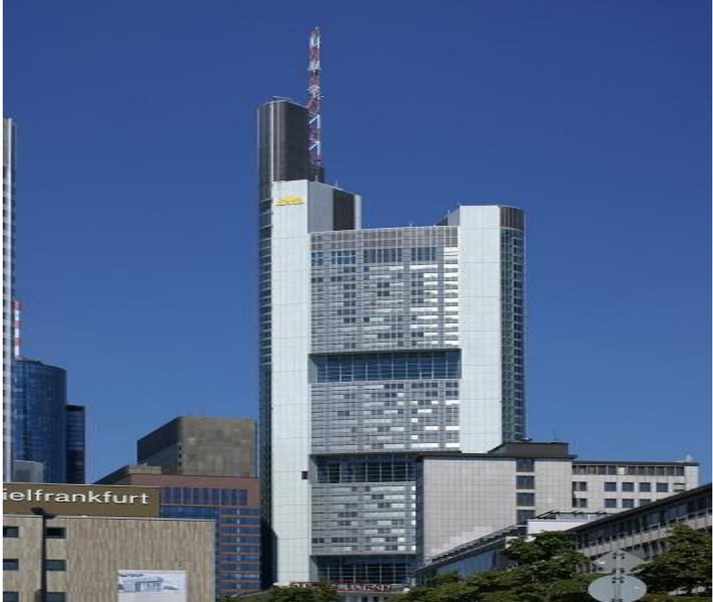
Şekil 2.10: Commerzbank Ofis Binası (Frankfurt, Germany) (Url-6)
