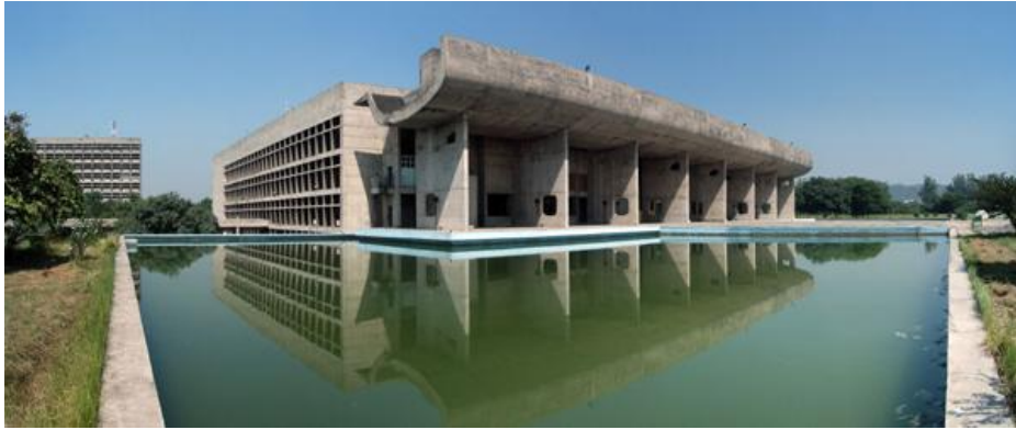
Şekil 2.39. Sekreteryä Binası http://www.mimdap.org/?p=9587
