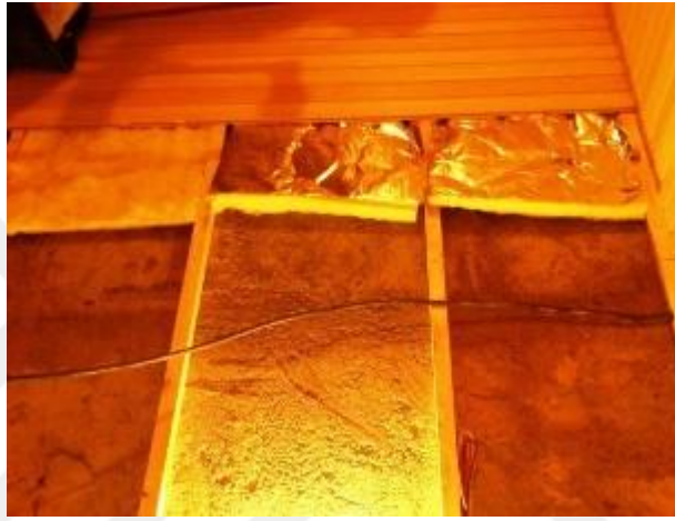
Şekil 5.50. Döşemelerde Cam Yünü Şilte
