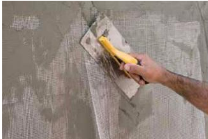
Şekil 5.20. Sıva ve Donatı Filesini Uygulaması
