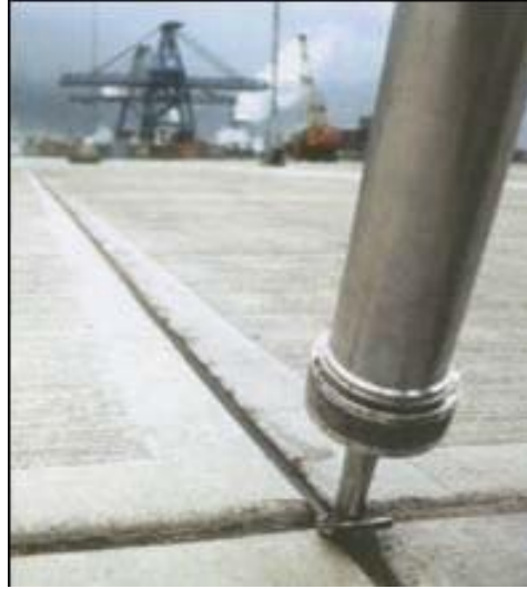
Şekil 6.11. Derz Dolgu Malzemesinin Uygulanması
