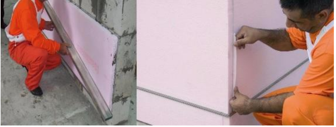
Şekil 5.9. Isı Yalıtım Levhalarının duvara Döşenmesi
