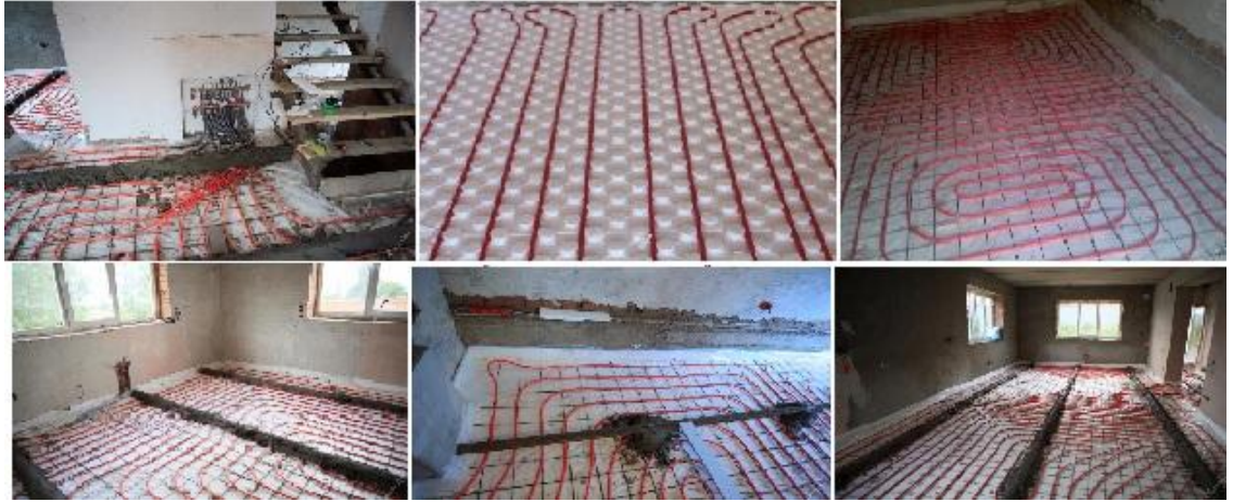
Şekil 5.52. Yerden ısıtılmalarda ısı yalıtım uygulaması
