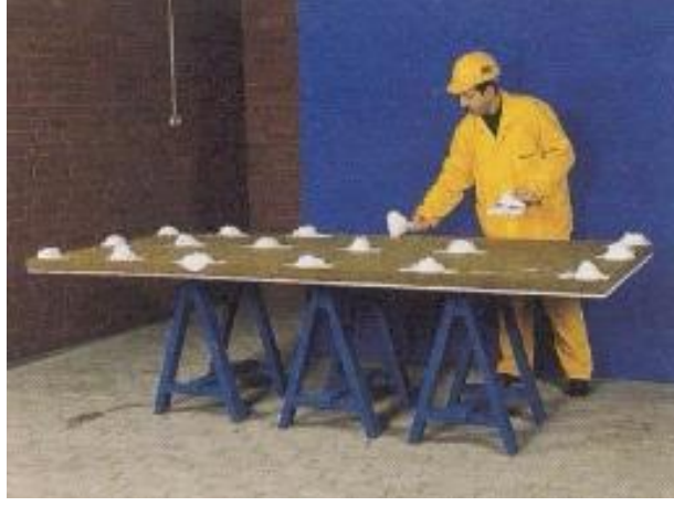
Şekil 5.24. Kompozit Panellerin Yapıştırılması
