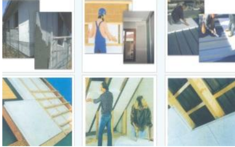
Şekil 6.8. Ekspande Polistren Köpük (EPS) Uygulaması
