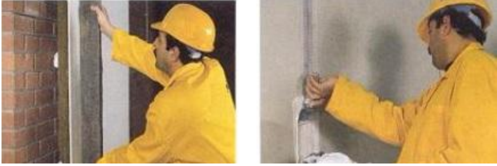
Şekil 5.25. Kompozit Panellerin Uygulanması
