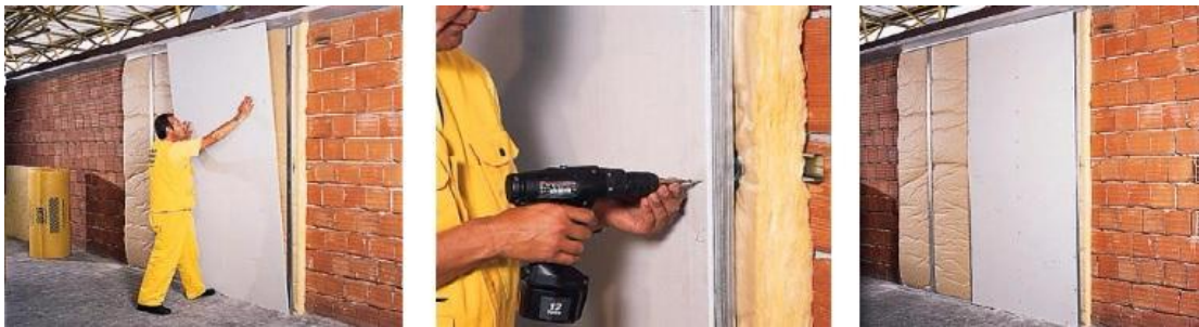
Şekil 5.32. Yalıtım Malzemelerinin Alçı Plakalarıyla Kaplanması
