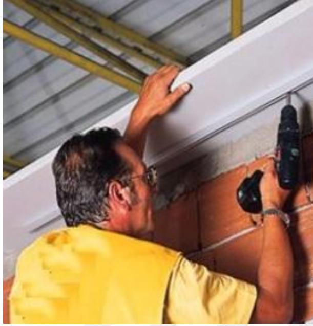
Şekil 5.28. U Profilin Tavana Dübellenmesi
