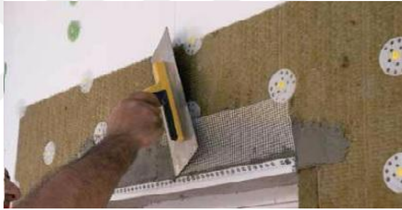
Şekil 5.17. Damlalı köşe Profillerinin Yerleştirilmesi
