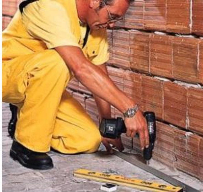
Şekil 5.29. U Profillerin Tabanda Dübellenmesi
