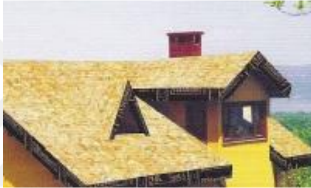
Şekil 6.5. Rende Yongasının Eğimli Çatıda Uygulanması
