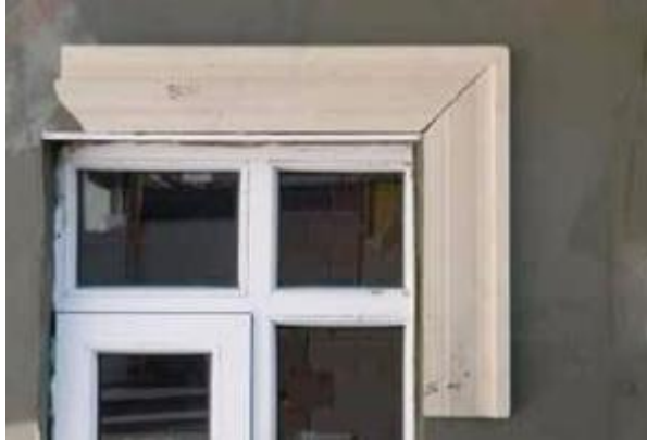
Şekil 5.22. Dekoratif Dış Cephe Profillerinin Yerleştirilmesi
