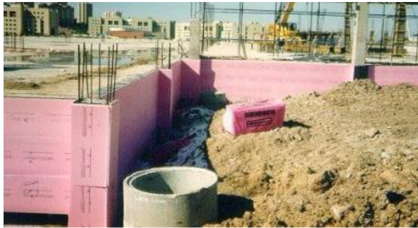
Şekil 5.3. Toprak Altında Kalan Duvarlarda Isı Yalıtımı
