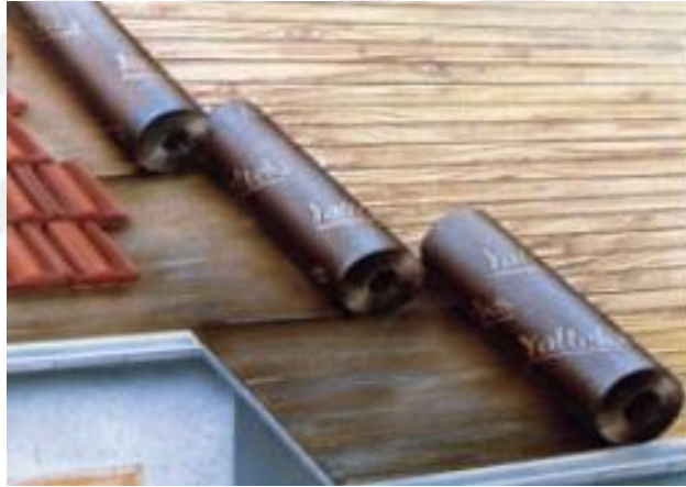
Şekil 6.13. Kiremit Altı Örtüsünün Döşenmesi
