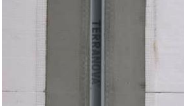
Şekil 5.18. Dilatasyon Profillerinin Yerleştirilmesi
