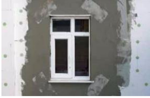
Şekil 5.21. Pencerelede Sıva ve Donatı Filesı Uygulaması
