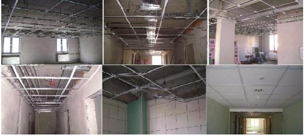
Şekil 5.53. Asma Tavan Levhası İle Isı Yalıtımı Uygulaması
