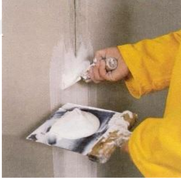
Şekil 5.26. Derz Dolgu Harcının Uygulanışı
