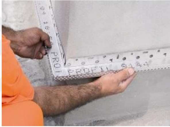
Şekil 5.6. Köşe Bağlantılarında Su Basman Profillerinin Yerleştirilmesi
