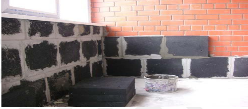
Şekil 6.7. Cam Köpüğü Uygulaması
