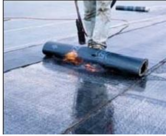
Şekil 6.12. Polimer Esaslı Su Yalıtım Malzemesinin Yüzey Üzerine Serilmesi
