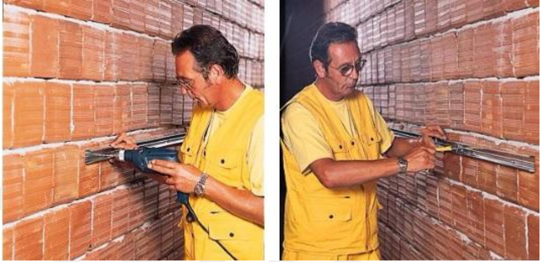
Şekil 5.30. C Profillerin Yatay Olarak Dübellenmesi
