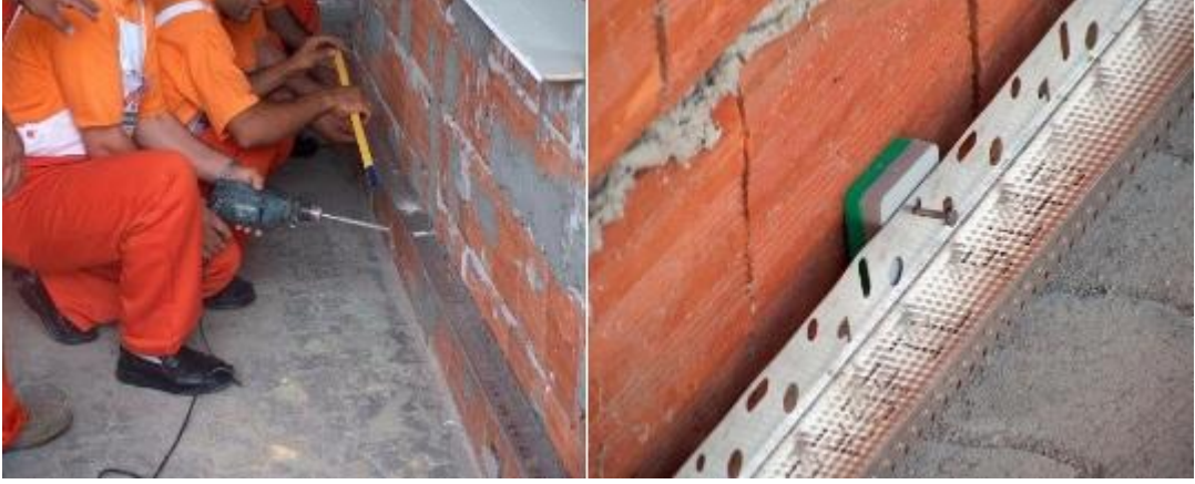
Şekil 5.5. Su Basman Profillerinin Yerleştirilmesi
