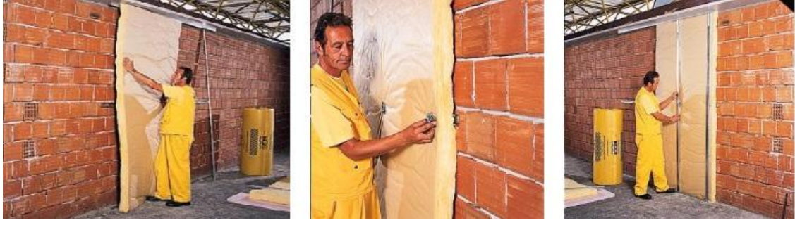
Şekil 5.31. Yalıtım Malzemelerinin Yerleştirilmesi
