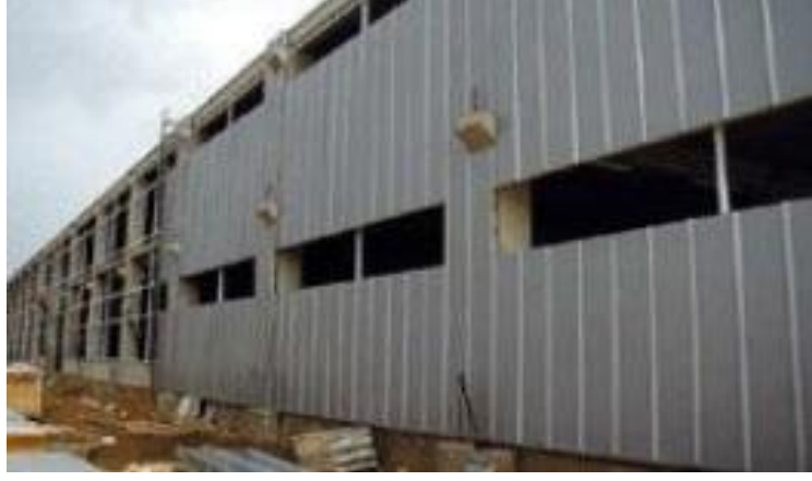
Şekil 6.10. Yapılarda Poliüretan Sert Köpükten Oluşturulmuş Kompozit Panelin Dış Cephede Uygulanması
