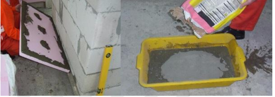
Şekil 5.7. Noktasal Yapıştırma Metodu
