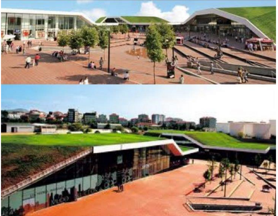
Şekil 5.19. Meydan AVM,55 Bin Metrekarelik Çatı Formunun 30 Bin Metrekaresi Yeşil Alan
