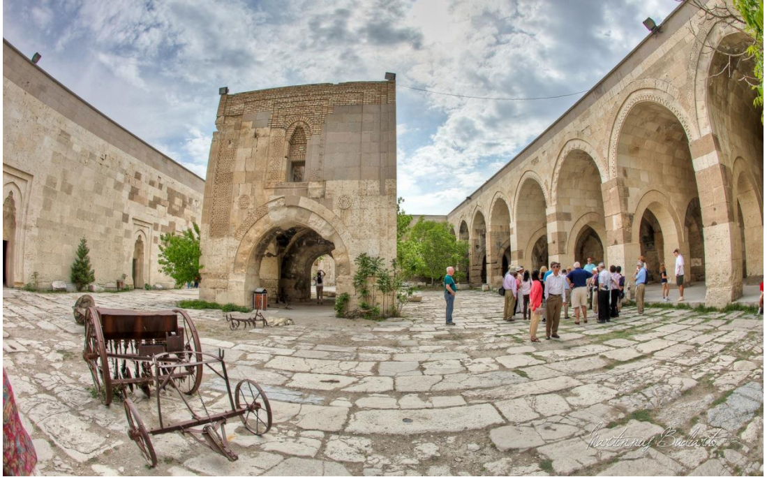
Şekil 3.4. Sultan Han (Aksaray)
